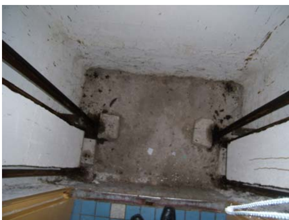
Prohlubeň šachty – betonové protiváhy
