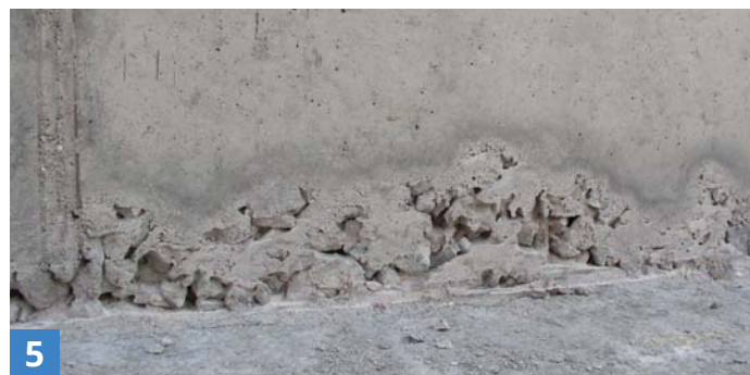
Odtok cementového mléka
