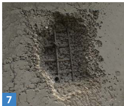
Obnažená armatura a štěrkové hnízdo
