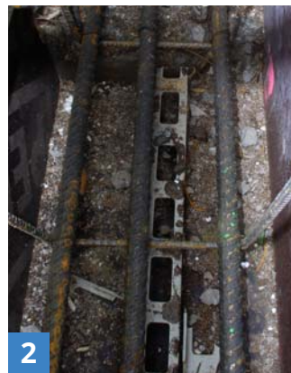
Nečistoty v bednění
