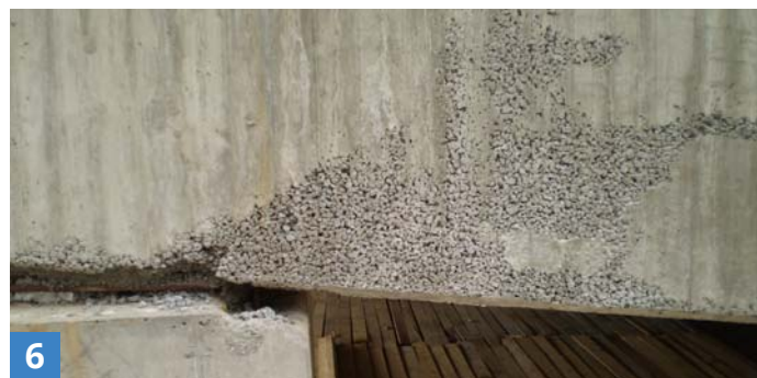
Štěrkové hnízdo, odtok cementového mléka
