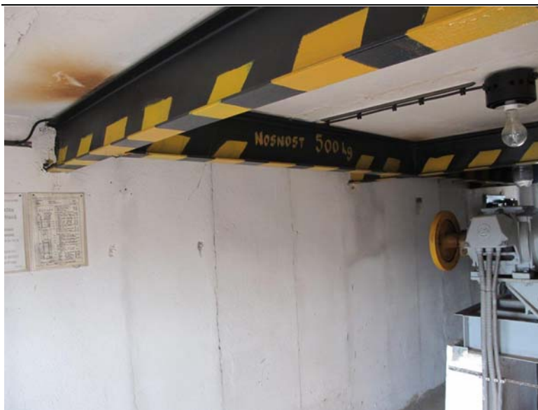
montážní nosníky ve strojovně
