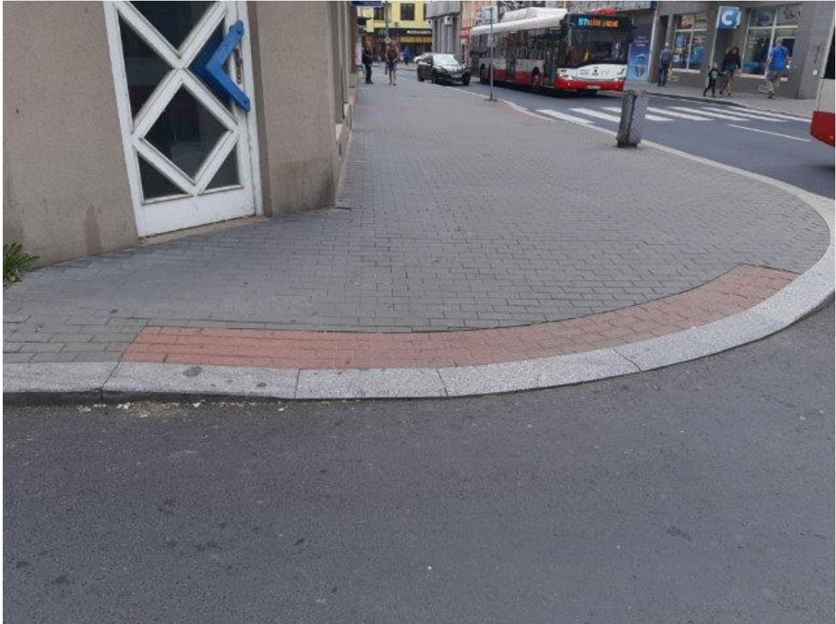
Obrázek 2 - Varovný pás u napojení na ul. Zámečnická
