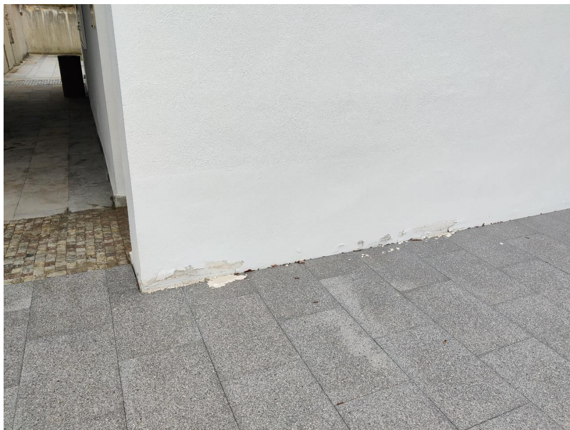
Oprava spodní části zdi a doplnění soklu
