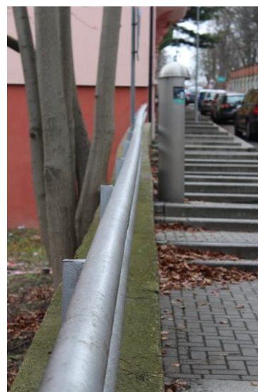
Vyklonění opěrky a zábradlí
