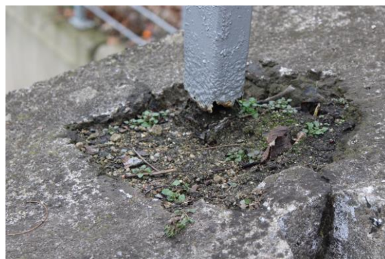
Koroze sloupků zábradlí
