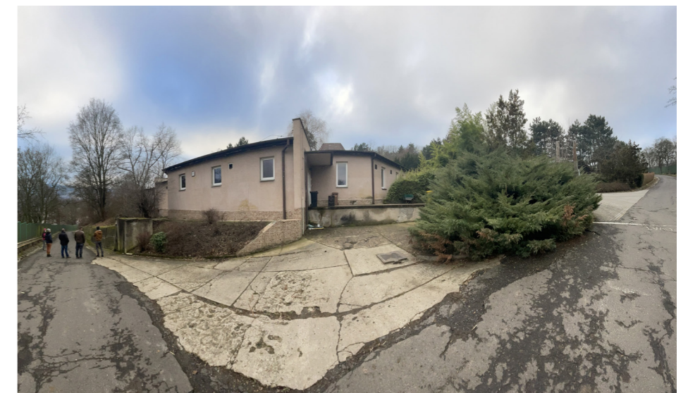
H. Zadní strana stávajícího pavilonu
