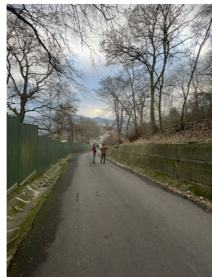
F. Opěrná zídka svahu výběhu
