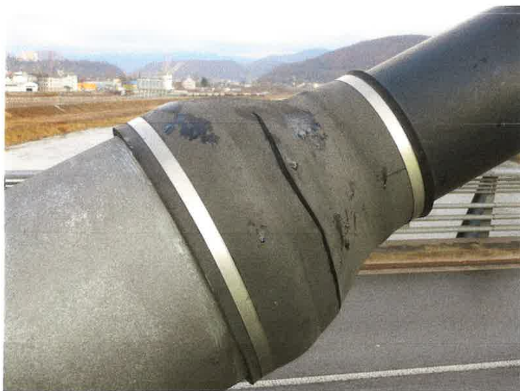
Obr. 50 Detail zásadní poruchy gumové objímky u jednoho závěsu
