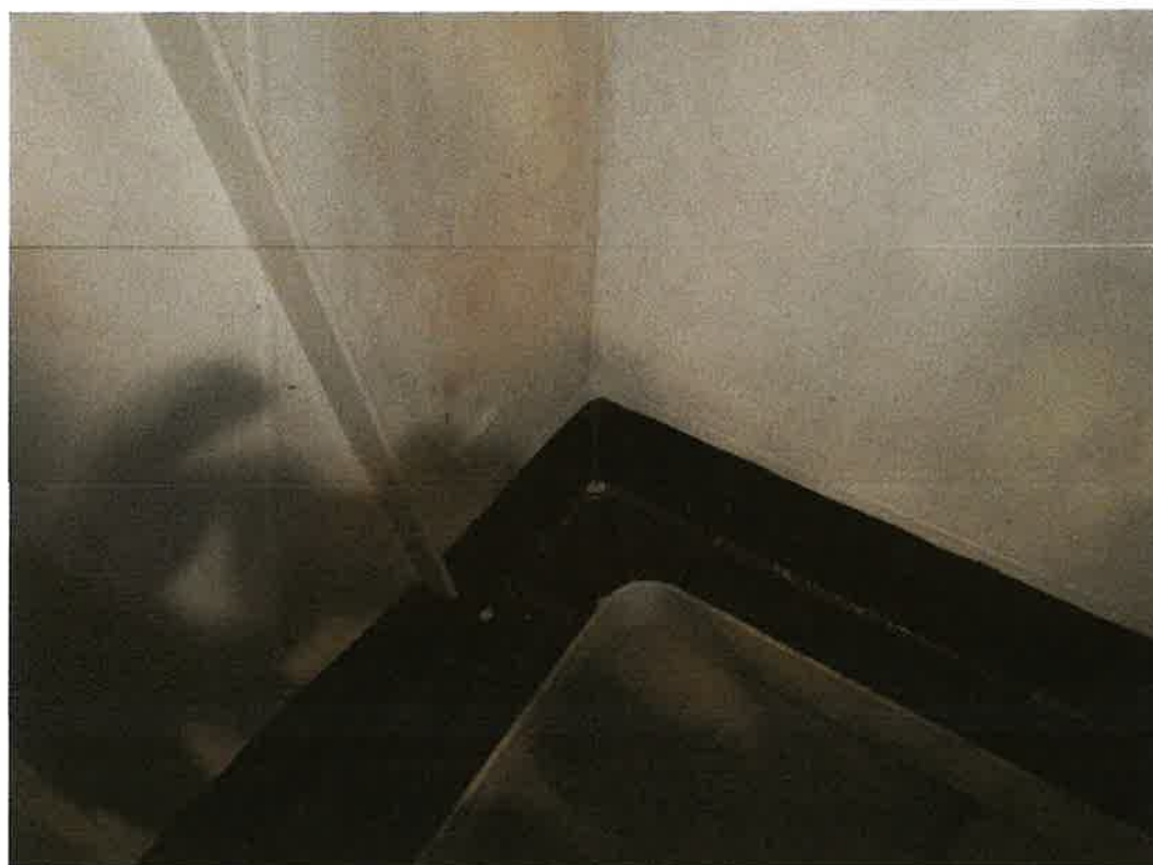
Obr. 30 Ochrana bezodtokových rohů výztuh černým asfaltovým nátěrem, lub 10
