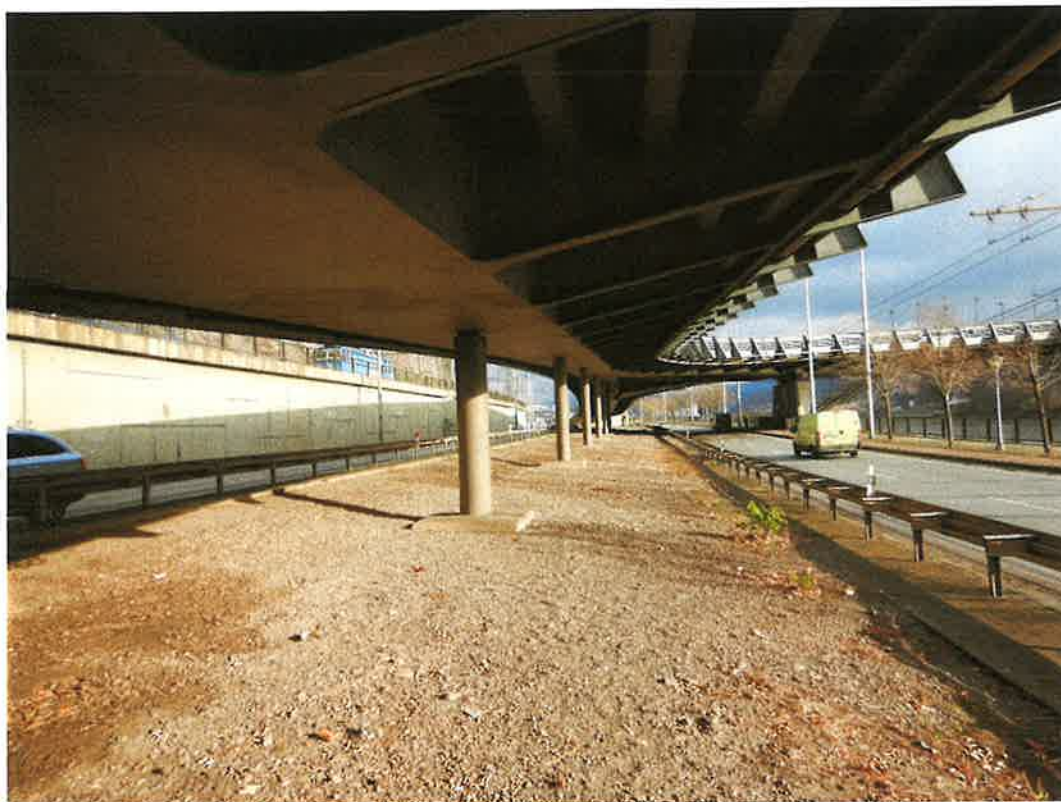
Obr. 7 Celkový pohled na mostní rampy od opěry č. 0 Centrum od Ústí na Děčín
