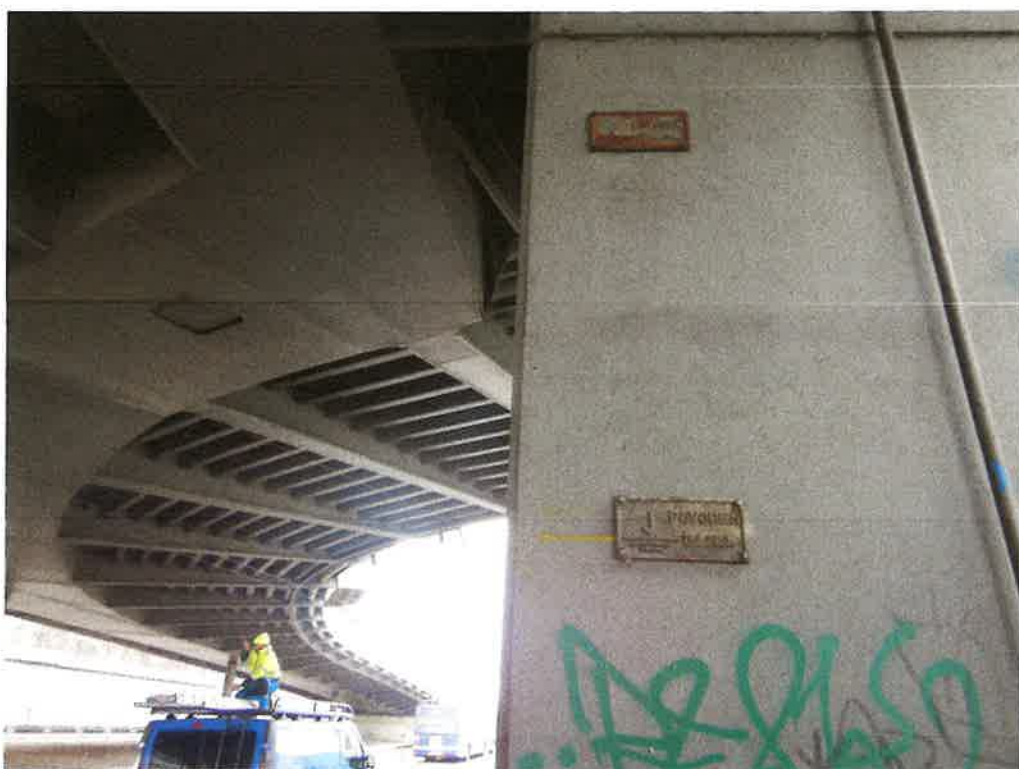
Obr. 56 Kontrola podhledu u rozpletu a tabulky s úrovní povodní 2002 a 2013
