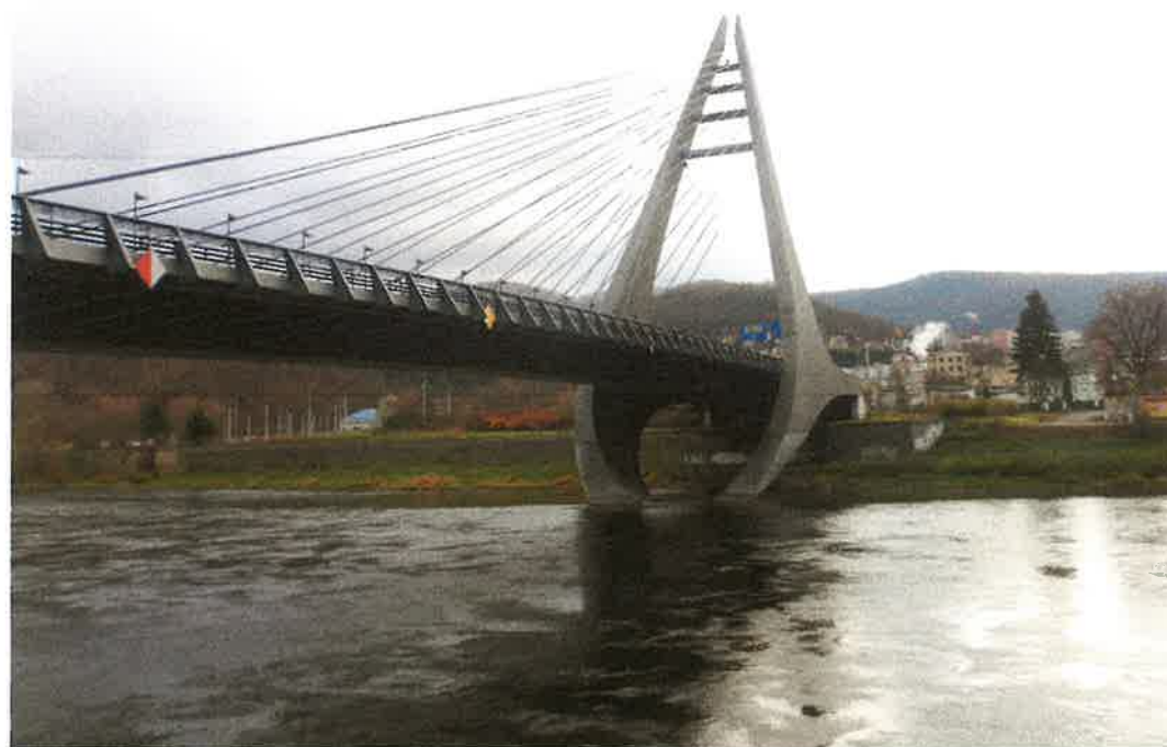
Obr. 2 Celkový pohled na most přes řeku na Střekov
