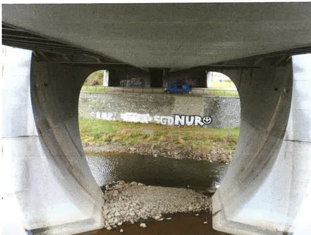
Obr. 9 Podhled z krajního pole , betonová část pylonu a nábrežní zeď Střekov
