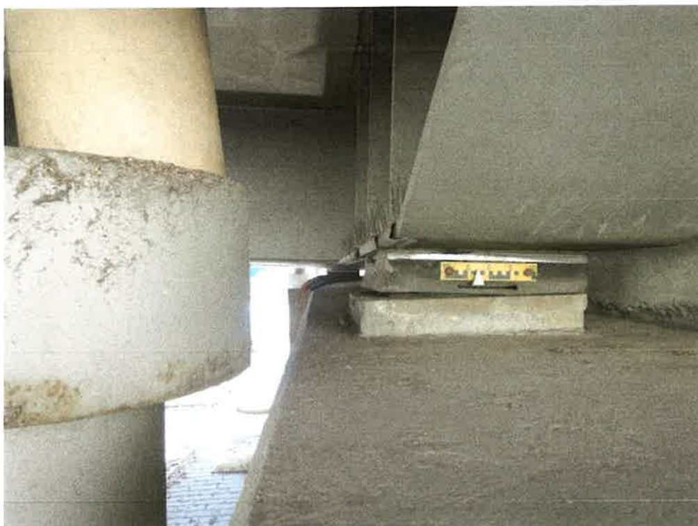
Obr. 63 Mostní rampy, ložisko na opěře 0 Centrum
