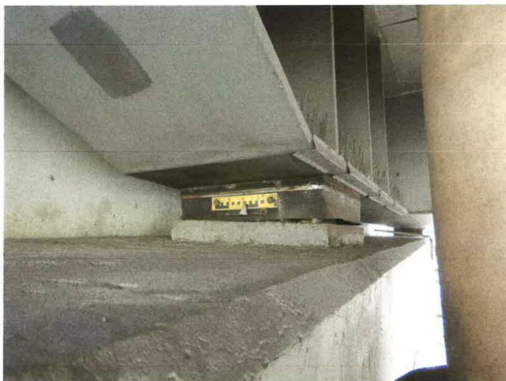
Obr. 62 Mostní rampy, ložisko na opěře č. 10 Krásné Březno
