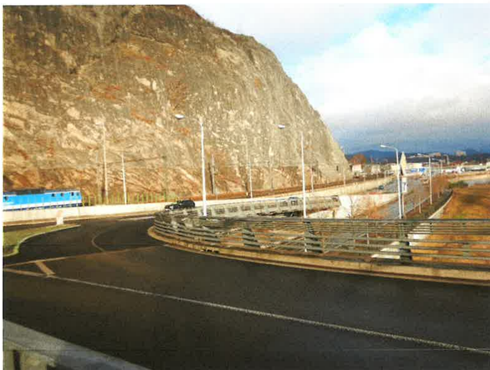
Obr.51 Pohled na rampu Krásné Březno přes mostní závěr na rozpletu ramp
