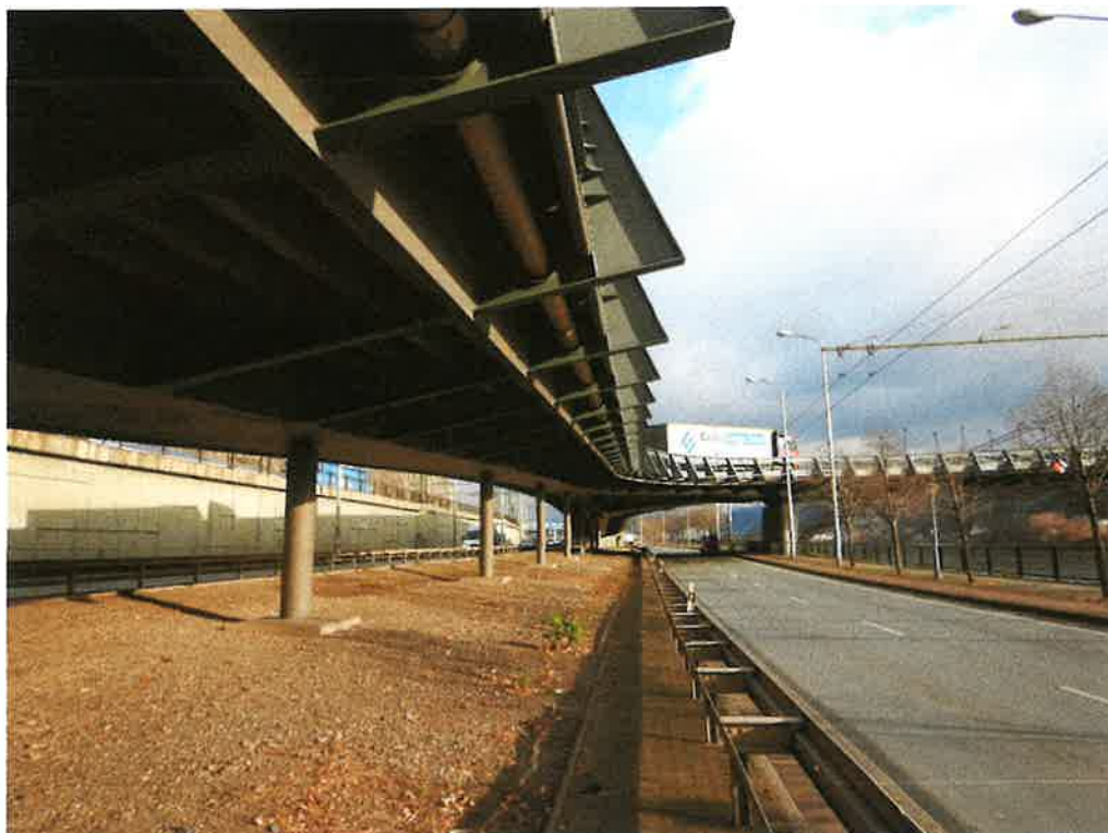
Obr. 61 Mostní rampy, celkový pohled od opěry č. 0 ke Krásnému Březnu
