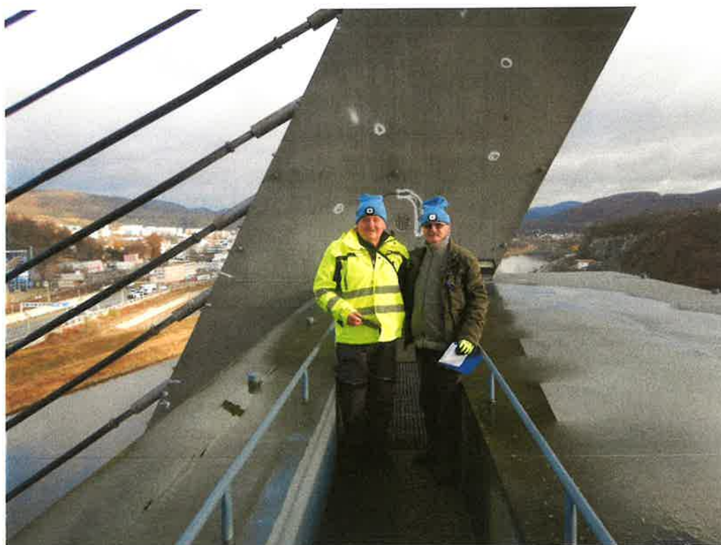
Obr.33 Pochůzí lávka na prvním křídlea a osoby provádějící HPM, směr na Děčín
