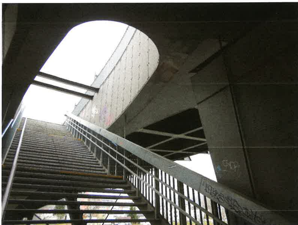
Obr. 59 Výstup schodištěm na most
