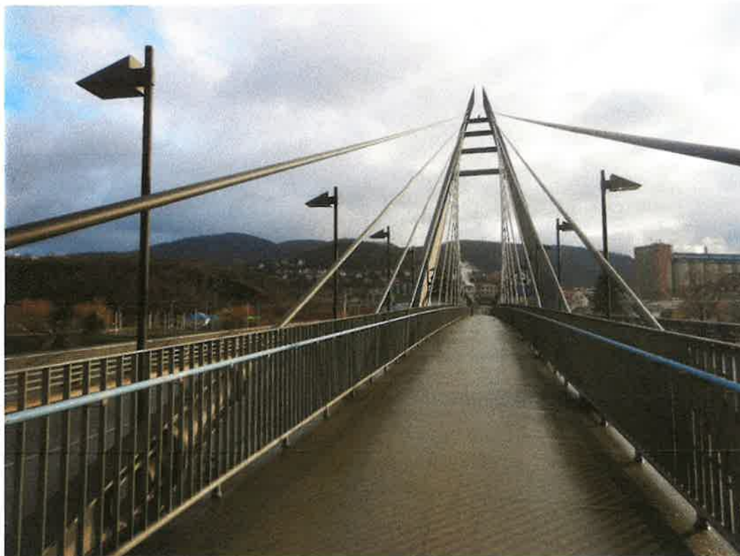
Obr3. Pohled ze středového chodníku na Střekov
