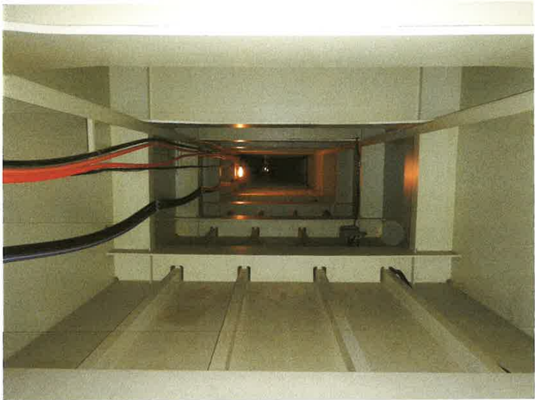
Obr. 25 Pohled do průchozí dutiny hlavního trámu s inž. sítěmi, běžný čistý
