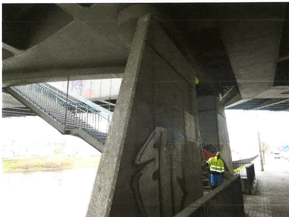
Obr. 53 Opěra hl. mostu č. 1, celkový pohled s výstupním schodištěm
