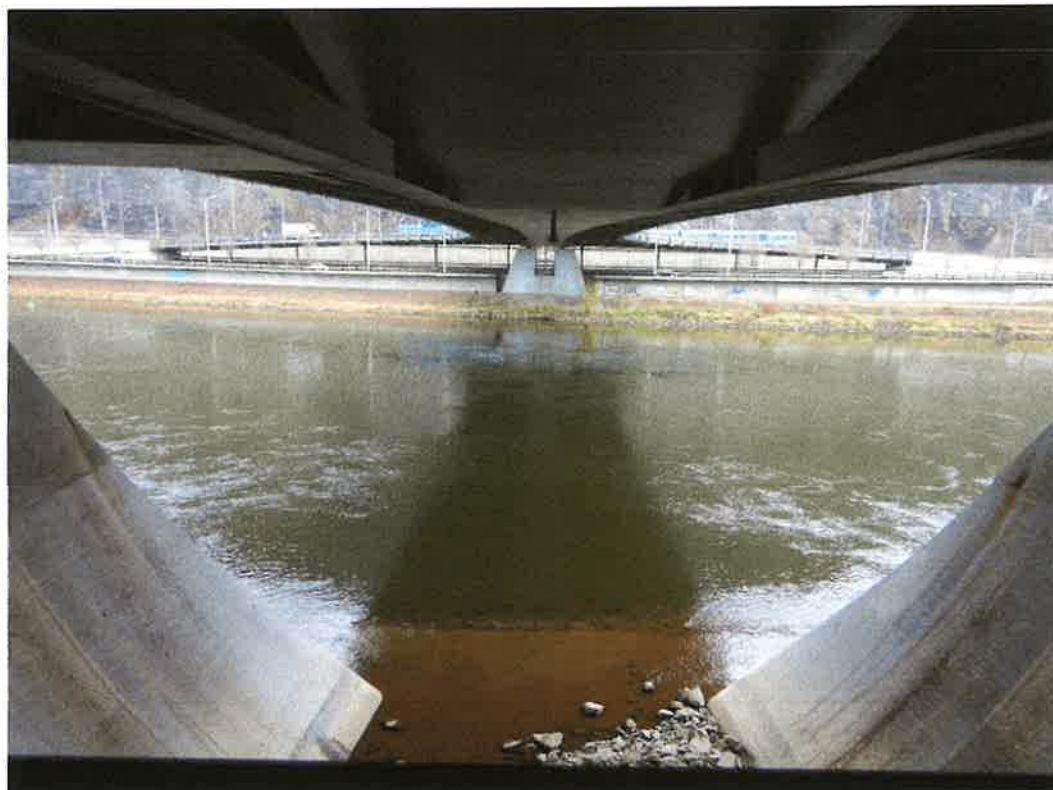
Obr. 8 Celkový podhled hlavního pole mostu s pohledem na mostní rampy
