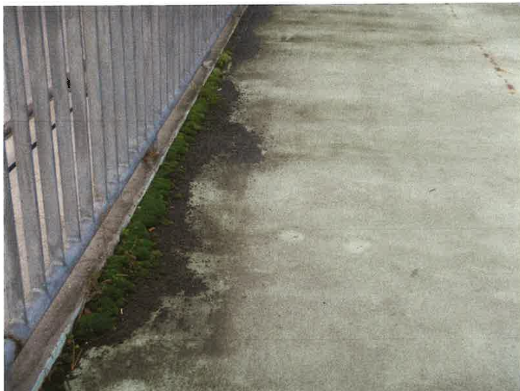
Obr.48 Vegetace a rez na středové původní vodící liště na chodníku
