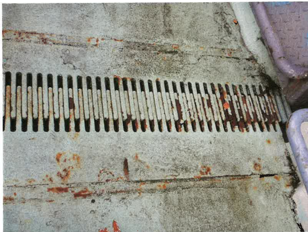
Obr. 47 Rez na a kolem prstového závěru na rampě chodníku na most
