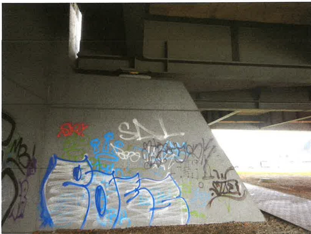
Obr. 41 Střekovská opěra hlavního mostu a Graffiti
