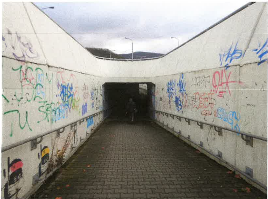
Obr. 44 Výstup z podchodu na středový chodník mostu
