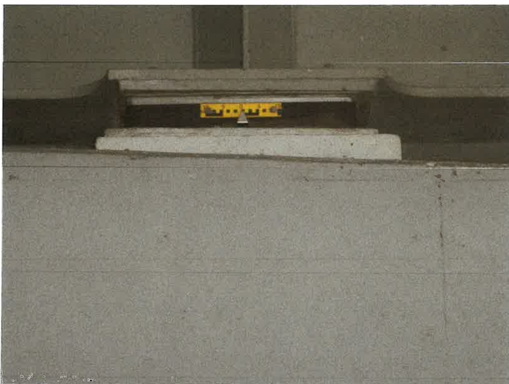
Obr. 42 Detail ložiska na střekovské opěře
