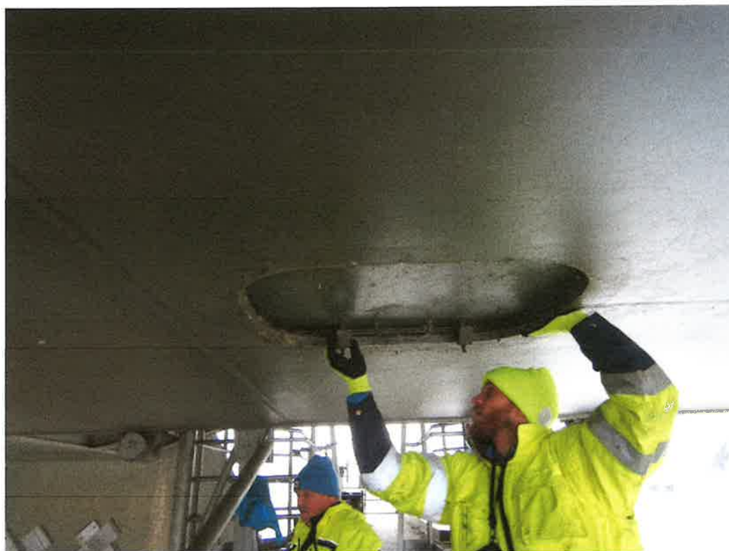
Obr. 17 Vstup z revizního vozíku poklopem do tubusu trámu před odkrytím
