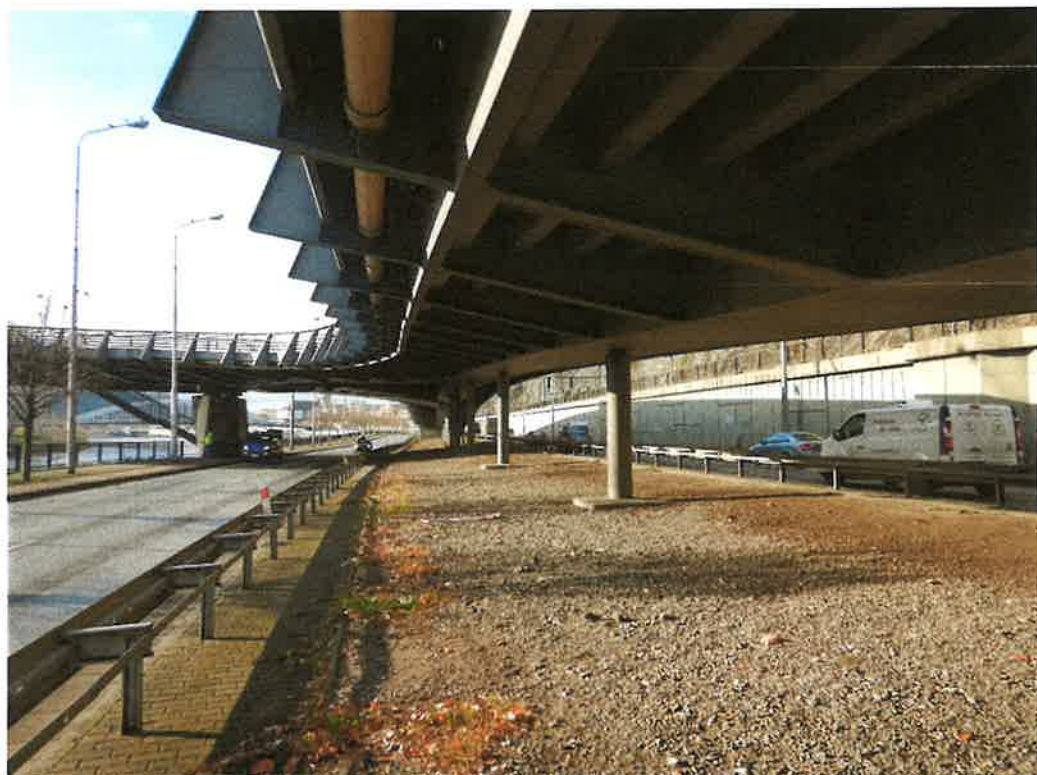
Obr. 6 Celkový pohled/podhled na mostní rampy od opěry č.10 Krásné Březno
