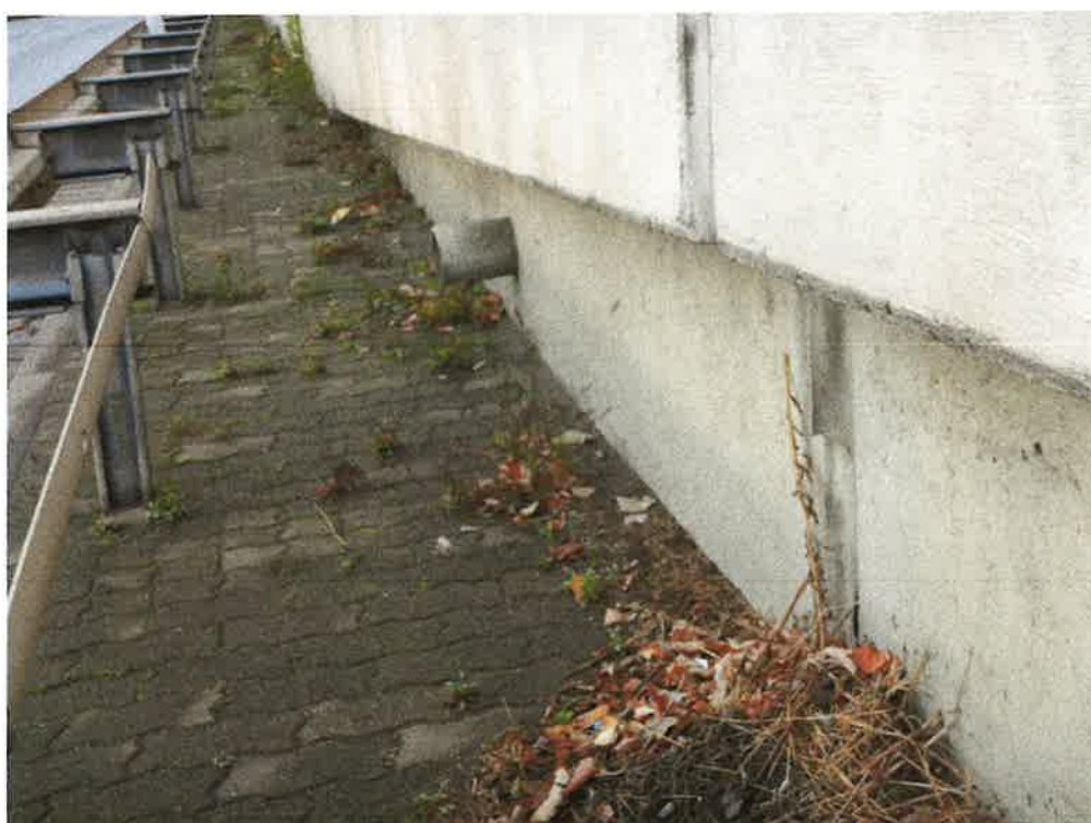
Obr. 66 Vegetace podél opěrných zdí u mostních ramp
