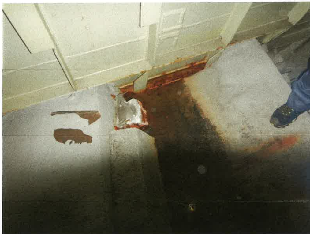
Obr.23 Detail spáry se zatopenou kotvou, půdorys
