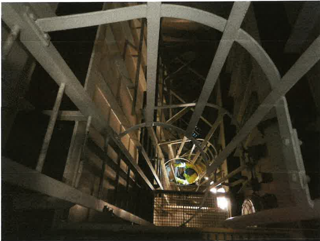
Obr. 39 Interiér pylonu se stoupacím žebříkem
