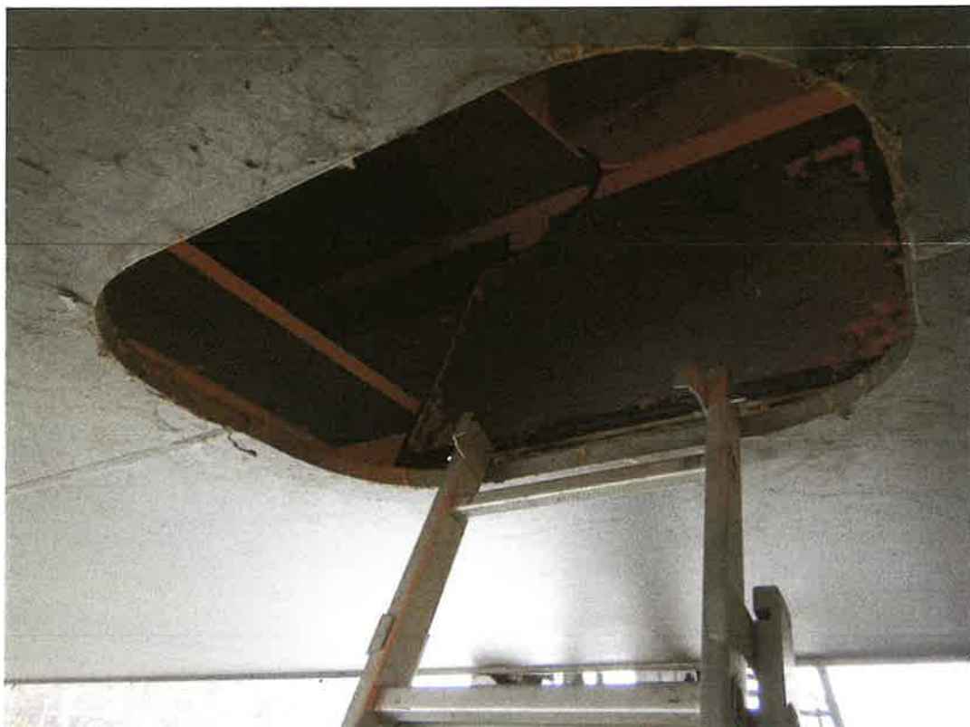
Obr. 18 Otevřený vstup z revizního vozíku do tubusu trámu
