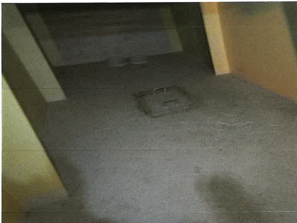
Obr.21 Nejnižší úroveň spáry ocel/beton, zcela suchá, poklop stálého zařízení
