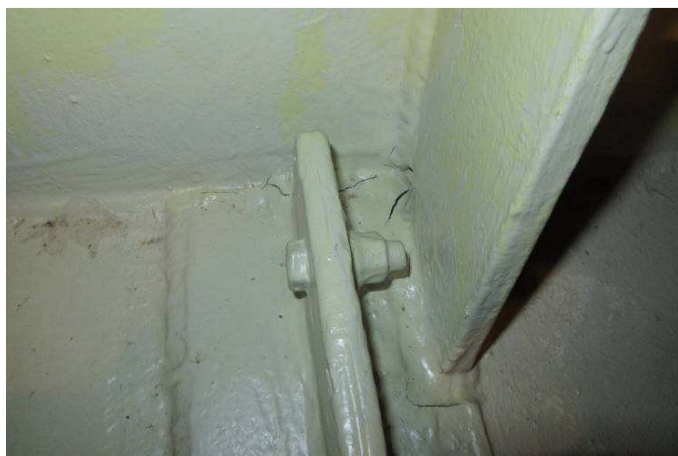
Obr. 122 – Pohled na připojení revizních žebříků, praskání nátěru (velká tloušťka nátěrů)
