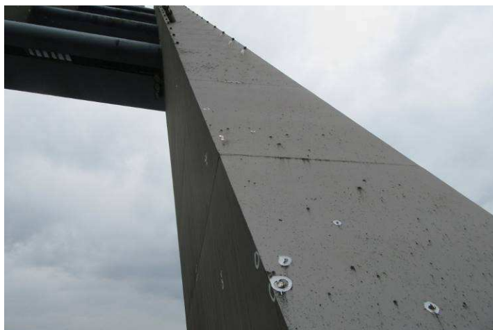
Obr. 96 – Pohled na pylon, lokální výskyt mechtů, usazování nečistot, prorozavění, odlupování
