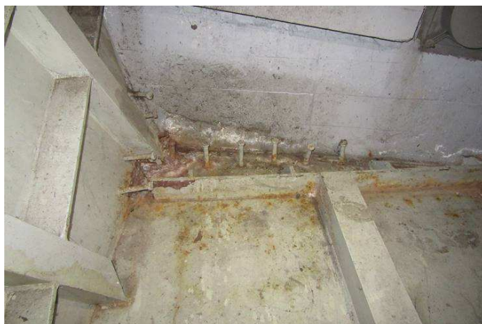
Obr. 98 – Pohled na patní oblast pylonu, styk oceli a betonu, intenzivní prorozavění Ri5, podkorodování, výskyt CHRL
