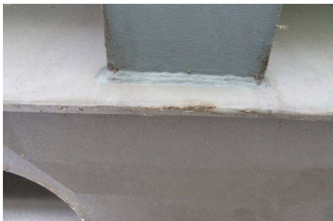
Obr. 19 – Pohled na svislý koncový plech konzoly a připojení římsové části, koroze na hranách, podkorodování
