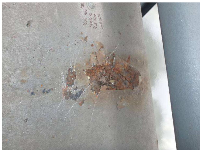
Obr. 145 – Pohled na vodorovnou plochu římsy, prerezavění, podkorodování
