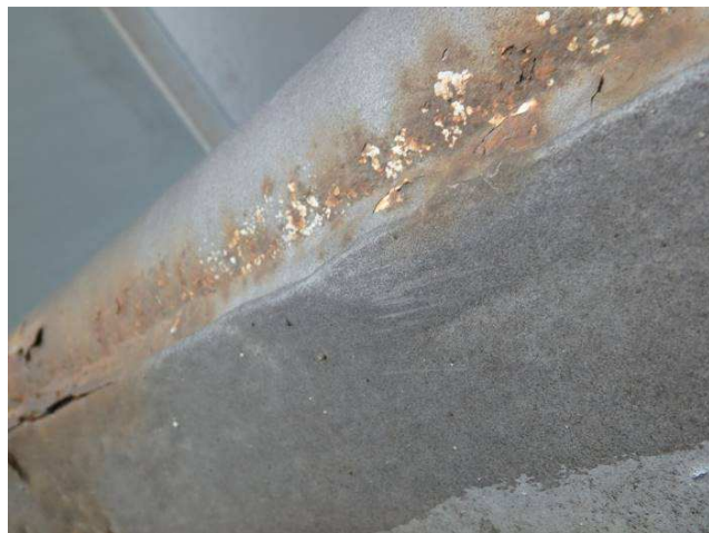
Obr. 154 - Pohled na vnější hranu římsy, prerezávání R i5 , podkorodování, křídování a smívání vrchního nátěru
