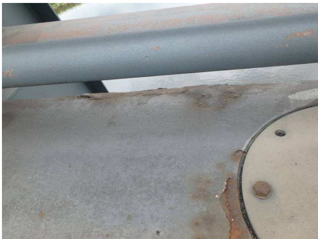
Obr. 153 - Pohled na vnější hranu vodorovné části římsy, prerezávání, podkorodování, odlupování, koroze spojovacího materiálu
