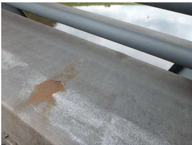
Obr. 151 - Pohled na vnější římsové obruby, prerezávání R i5 , podkorodování, plošná koroze, odlupování, křídování a smívání vrchního nátěru
