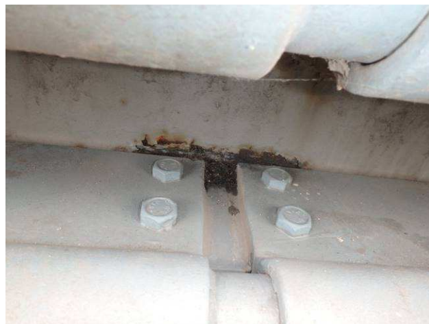
Obr. 174 – Pohled na patku sloupku svodidla, prerezavění, podkorodování
