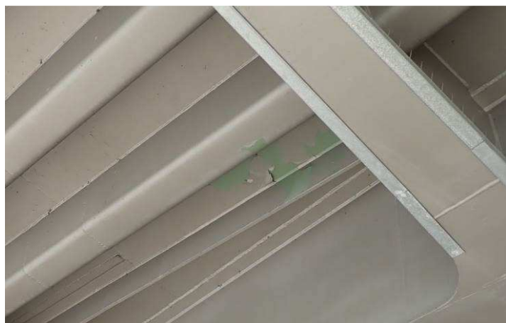
Obr. 51 – Pohled na korýtkové výztuhy a konzolu rampy, odlupování vrchního nátěru
