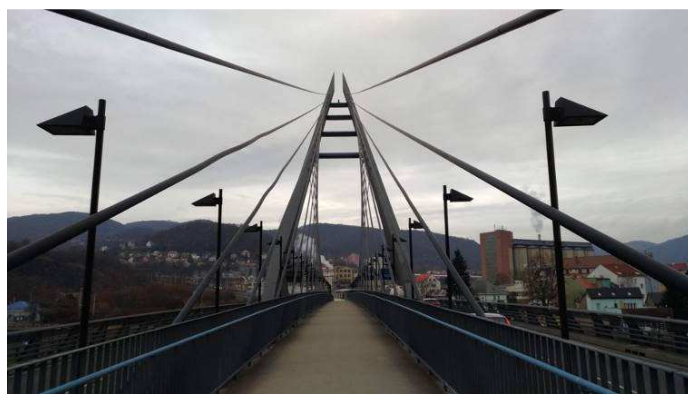
Obr. 264 - Pohled na závěsy mostu, výrazné zvlnění dvojice závěsů
