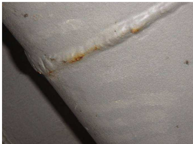
Obr. 29 – Pohled na montážní styk korýtkové výztuhy mostovky, prorezavění
