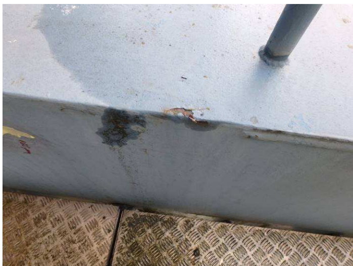
Obr. 79 – Pohled na hranu příčnicku pylonu (křídlo), prorezavění Ri3 až Ri4, podkorodování, odlupování, křídování
