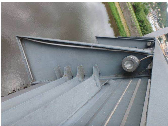
Obr. 199 – Pohled na sloupek svodidla, prorezavění v místech přípojů vodorovného zachytňovacího systému
