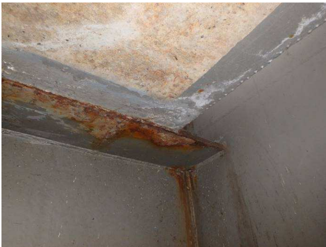
Obr. 09 – Pohled na napojení příčnicku a desky, prorezavění Ri5, koroze na hranách, plošná koroze, kontaminace CHRL
