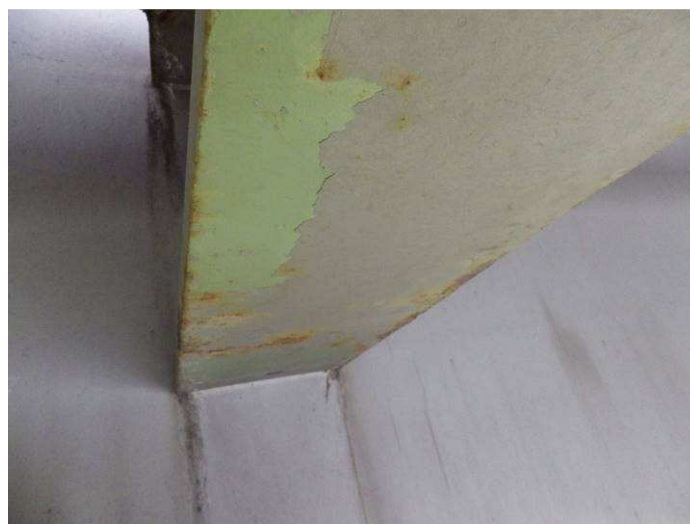
Obr. 46 – Pohled na příčník a parapet pylonu, odlupování vrchních vrstev, prerezávání Ri3 až Ri5, koroze na hranách
