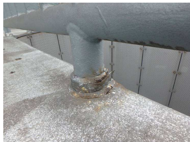
Obr. 228 – Pohled na přípoj zábradlí, prorezavění, podkorodování
