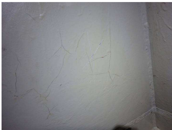
Obr. 124 – Pohled na stěnu pylonu, praskání nátěru místy až k základnímu nátěru
