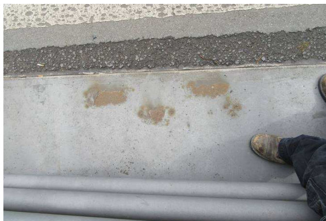
Obr. 136 – Pohled na vnější římsové obruby, prorezavění Ri5, plošná koroze
