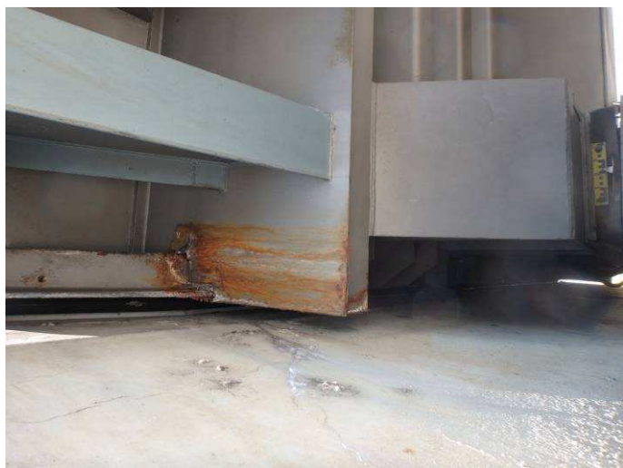
Obr. 37 – Pohled na koncovou část mostu u MZ, korozní produkty, podkorodování, prerezávání, protékání z vozovky
