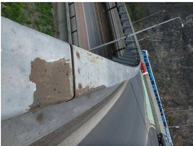
Obr. 191 – Pohled na madlo svodidla, plošná koroze, prorezávání, koroze spojovacího materiálu
