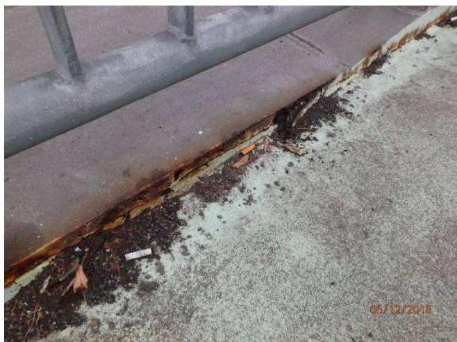
Obr. 277 – Pohled na napojení pochozí izolace k OK, intenzivní koroze a ztráta ochranné funkce izolace
