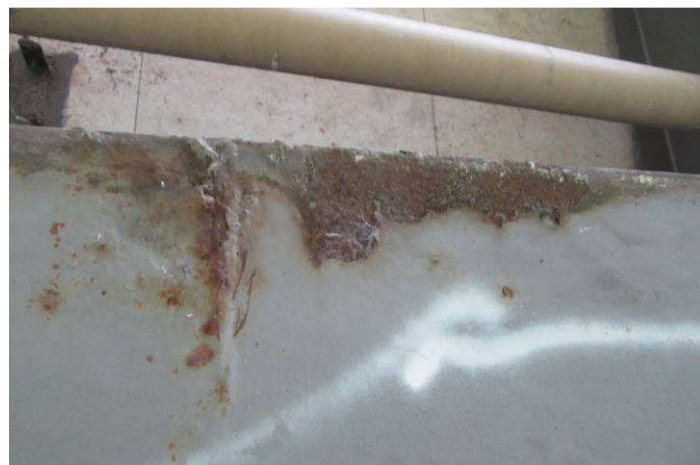
Obr. 72 - Pohled na hranu parapetu pylonu, koroze na hranách, podkorodování
