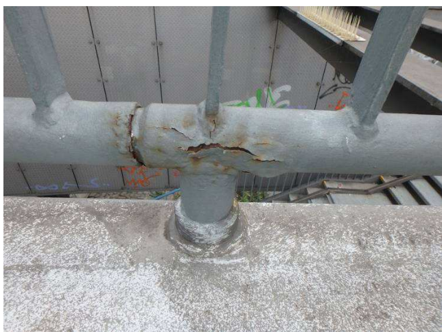
Obr. 227 - Pohled na spodní pas zábradlí, prorezavění, podkorodování, odlupování, plošná koroze
