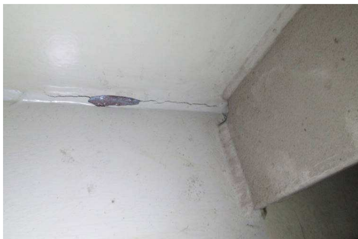
Obr. 121 – Pohled na stěnu a výztuhy pylonu, praskání nátěru v celém souvrství
