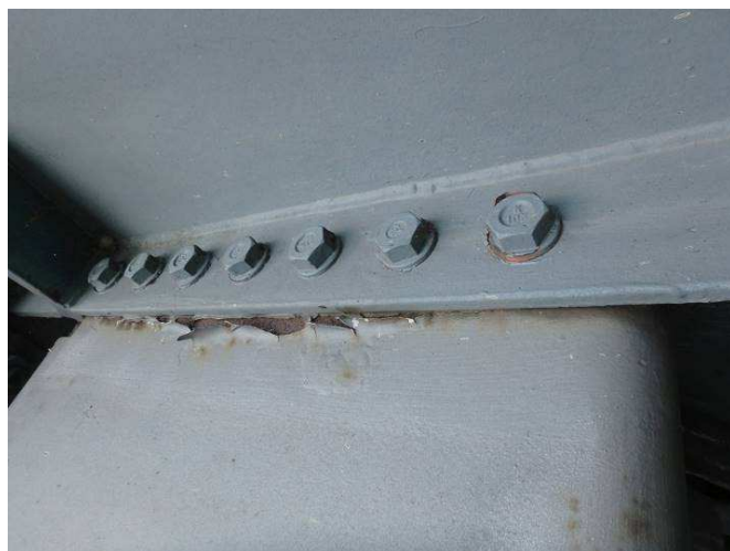
Obr. 158 – Pohled na šroubový styk svislé části římsy, prorezavění, podkorodování, odlupování
