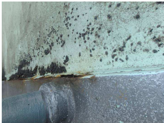
Obr. 168 - Pohled na horní pas komory, prorozavění na hranách, podkorodování, smívání vrchního nátěru
