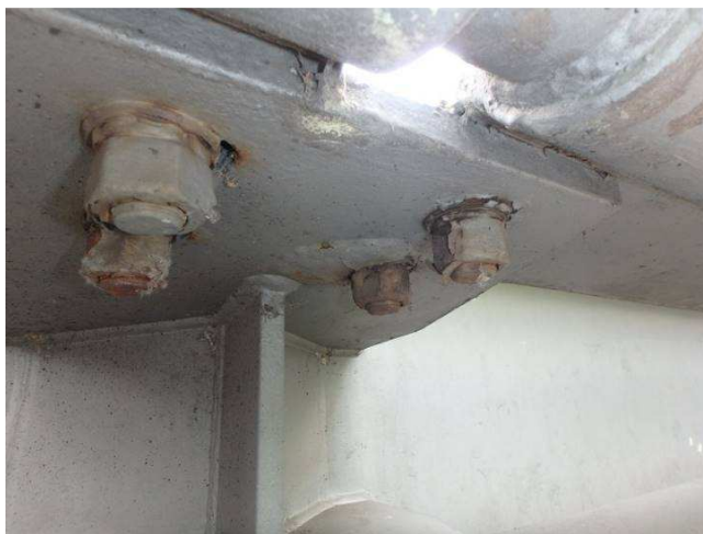
Obr. 180 - Pohled na přípoj vodorovného záchytného systému, koroze spojovacího materiálu
