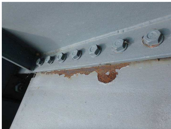
Obr. 159 - Pohled na šroubový styk svislé části římsy, stav podkorodování po odstranění nesoudržných vrstev
