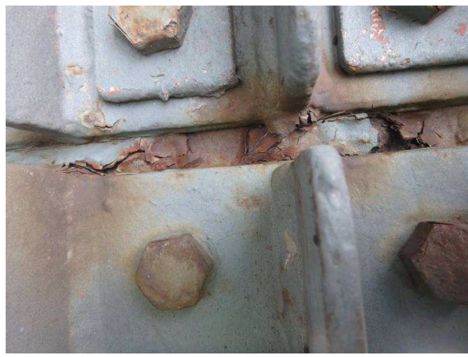
Obr. 202 – Pohled na šroubový spoj výplně svodidel, prorezavění, podkorodování, plošná koroze, koroze spojovacího materiálu
