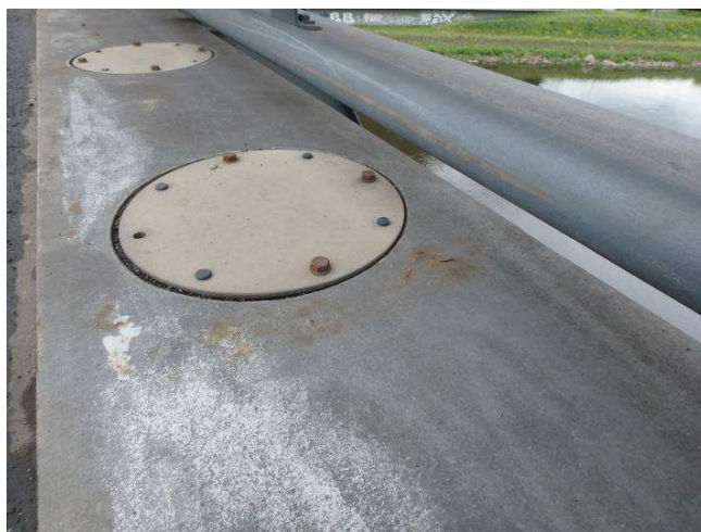
Obr. 152 - Pohled na vnější římsové obruby, prerezávání R i5 , plošná koroze, podkorodování, odlupování, křídování a smívání vrchního nátěru
