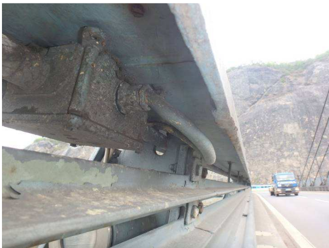
Obr. 189 – Pohled na madlo a výplně svodidla, koroze na hranách, prorezávání, odlupování, elektro skříňka plošná koroze
