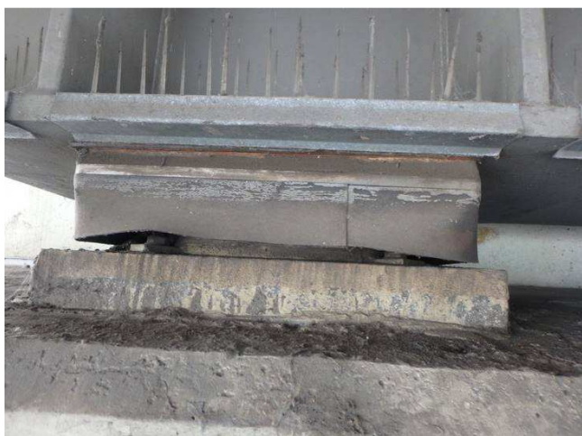
Obr. 315 – Pohled na ložisko, koroze horní desky
