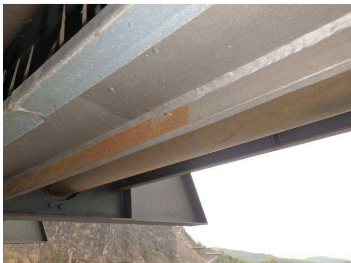
Obr. 21 – Pohled na převislou část koncového plechu konzoly, plošná koroze, prorozavění Ri5
