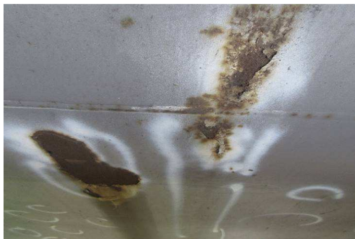
Obr. 74 – Pohled na stěnu parapetu pylonu, prerezávání Ri5, podkorodování, plošná koroze
