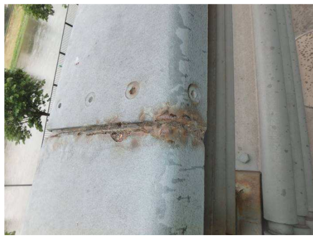
Obr. 198 – Pohled na styk madla svodidla, prorezavění, podkorodování, koroze spojovacího materiálu
