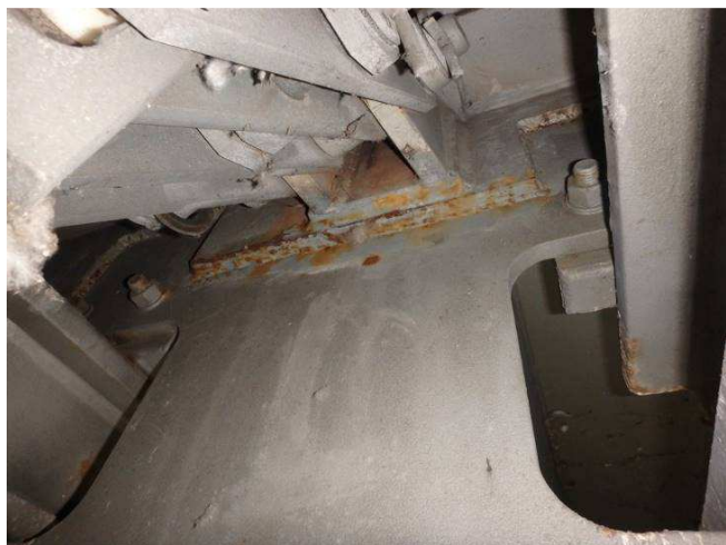
Obr. 303 – Pohled na montážní styk MZ, prorozavění, podkorodování
