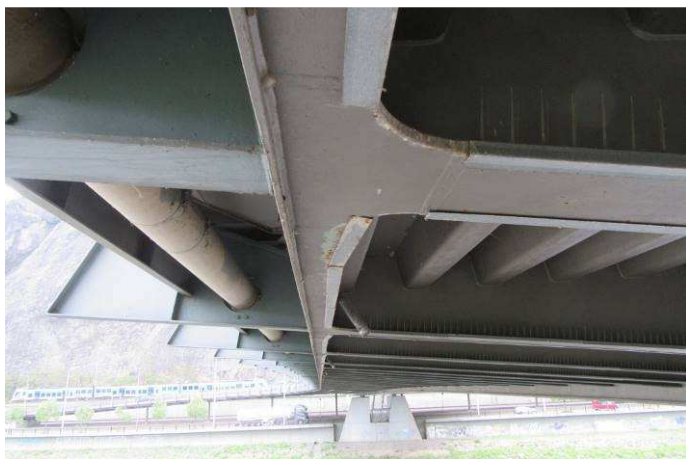
Obr. 39 – Pohled na NK a zábrany proti holubům, koroze na hranách, prerezávání Ri5
