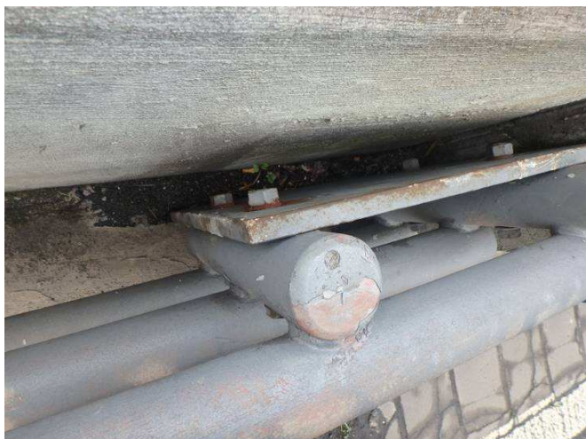
Obr. 179 - Pohled na koncovou část svodidla, prerezávání, koroze na hranách, odlupování vrchního nátěru
