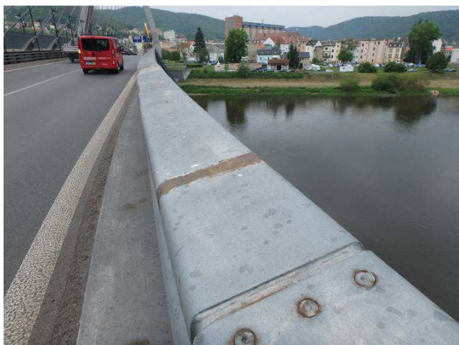
Obr. 193 – Pohled na madlo svodidla, plošná koroze, koroze spojovacího materiálu, koroze na hranách
