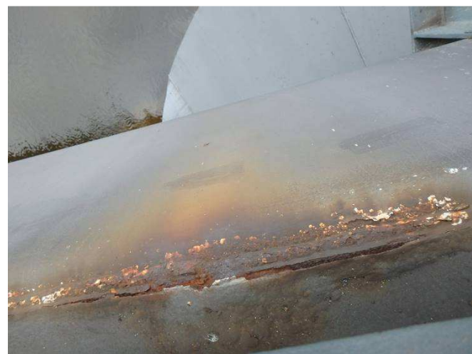
Obr. 144 - Pohled na vnější hranu římsy, prorozavění, podkorodování
