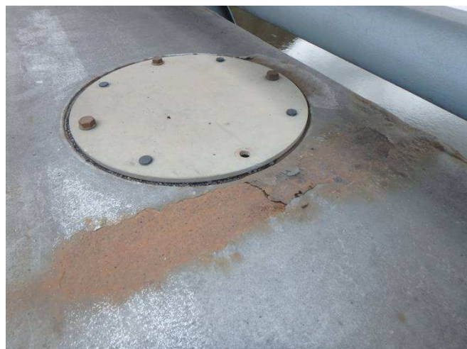
Obr. 146 – Pohled na vodorovnou plochu římsy, prerezavění, podkorodování, plošná koroze, koroze spojovacího materiálu
