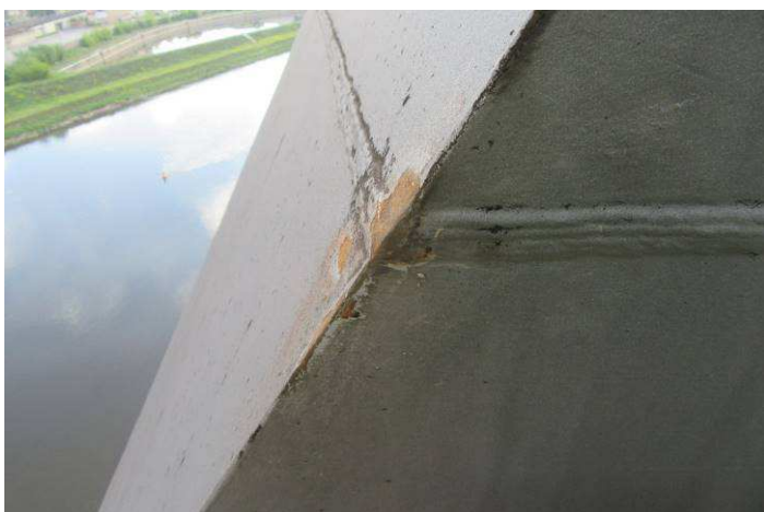
Obr. 59 – Pohled na montážní styk levého pylonu, prerezávání Ri5, plošná koroze, křídování
