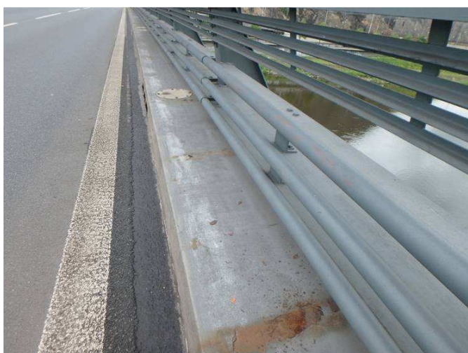
Obr. 149 - Pohled na vnější římsové obruby, prerezavění Ri5, plošná koroze, odlupování, křídování a smívání vrchního nátěru
