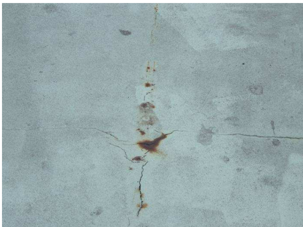
Obr. 273 – Pohled na trhliny v pochozí izolaci, koroze podkladních vrstev
