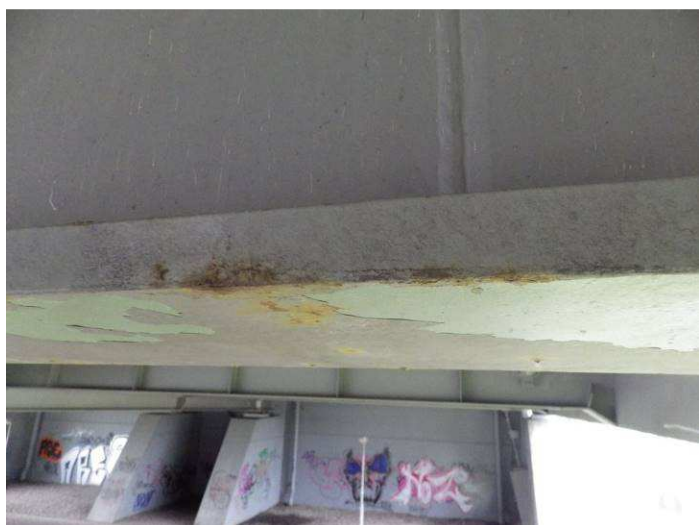
Obr. 47 – Pohled na příčník, odlupování PKO, koroze na hranách, prerezávání
