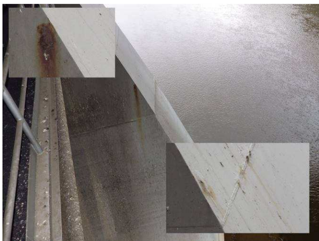
Obr. 61 – Pohled na levý pylon, prorozavění Ri5, podkorodování, křídování
