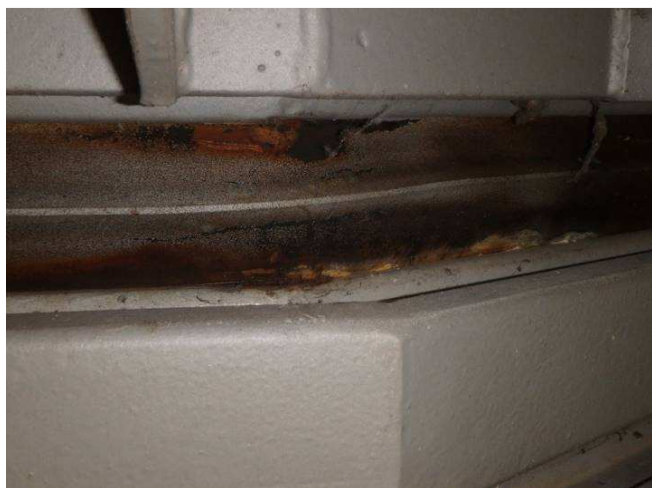
Obr. 295 – Pohled na těsnící gumu MZ, známky protékání okolo těsnící gumy, počínající degradace gumy
