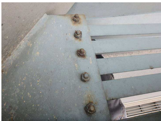
Obr. 185 – Pohled na připojení vodorovných výplní svodidel, koroze spojovacího materiálu, prorezavění
