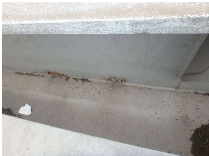
Obr. 165 - Pohled na vnitřní vodorovnou část římsy a svislou část komory, prorozavění a podkorodování
