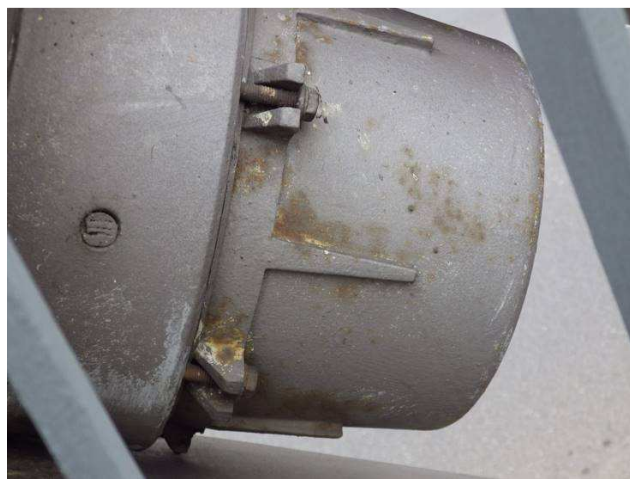
Obr. 214 – Pohled na krytku závěsu, prorezavění Ri3 až Ri4, smívání vrchního nátěru, koroze na hranách
