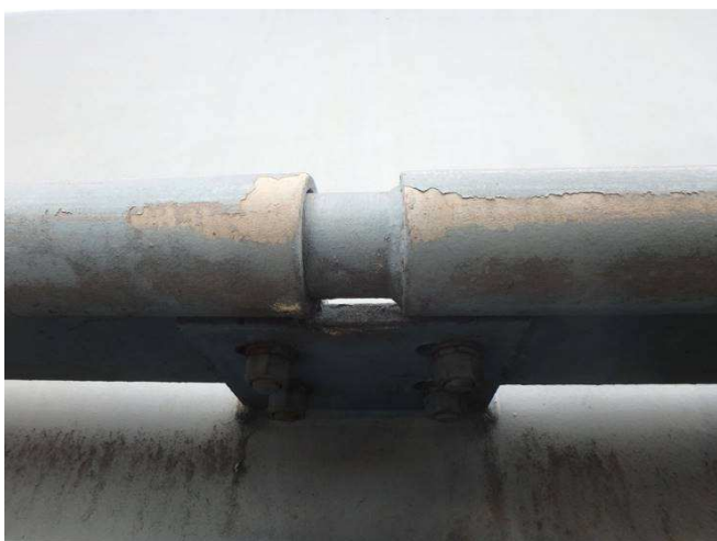
Obr. 239 – Pohled na vodorovný záchytný systém, odlupování vrchní vrstvy
