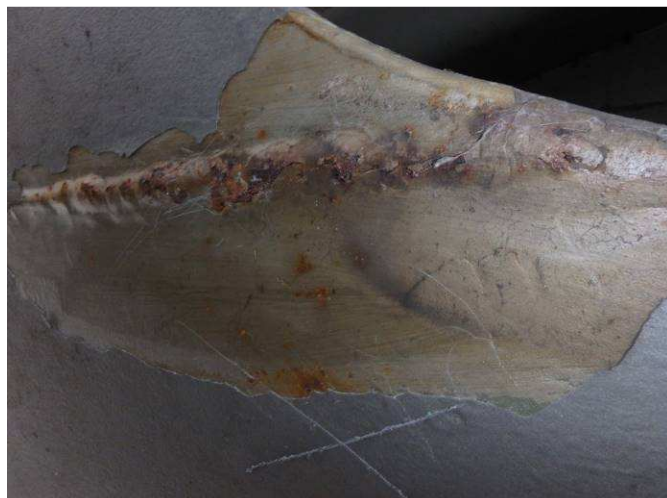
Obr. 30 – Pohled na montážní styk, prorezavění, podkorodování
