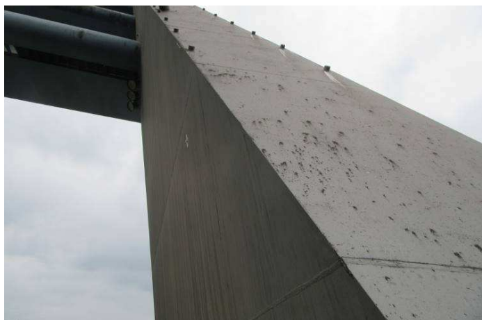
Obr. 97 – Pohled na pylon, kontaminace ploch mechy, prorozavění
