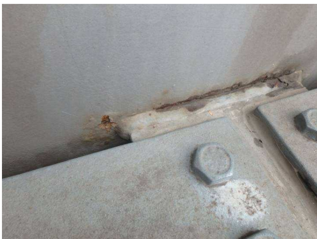
Obr. 175 – Pohled na uchycení vodorovného zádržného systému, prerezávání, podkorodování
