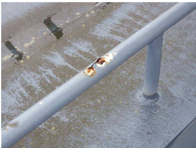
Obr. 87 - Pohled na madlo zábradlí na příčníku pylonu (křídlo), odlupování od základního materiálu, podkorodování, mechy a znečištění ploch, křídování
