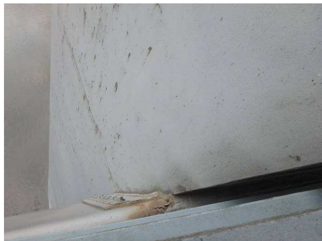
Obr. 64 – Pohled na styk pylonu a římsy, prorozavění Ri5, podkorodování na styku s římsou, křídování
