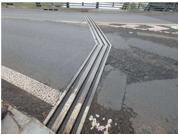
Obr. 307 – Pohled na MZ a vozovkové souvrství, degradace vozovkového souvrství, stojící voda v MZ
