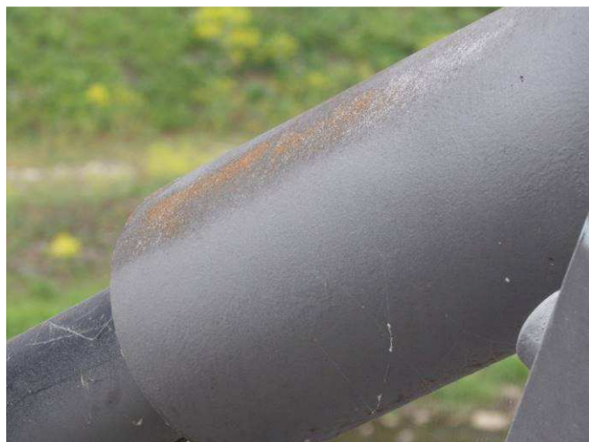
Obr. 82 – Pohled na kotevní oblasti závěsů, prorezavění Ri5
