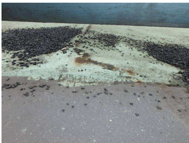
Obr. 275 – Pohled na napojení pochozí izolace a OK, trhliny v izolaci, koroze podkladních vrstev
