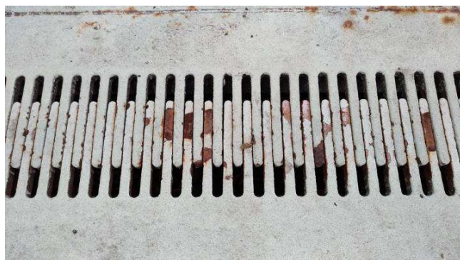
Obr. 290 – Pohled na prstový MZ, prerezávání, podkorodování, výskyt korozních produktů základního materiálu
