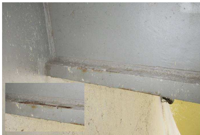
Obr. 12 – Pohled na spodní pásnici příčnicku, koroze na hranách, podkorodování, znečištění ptačím trusem
