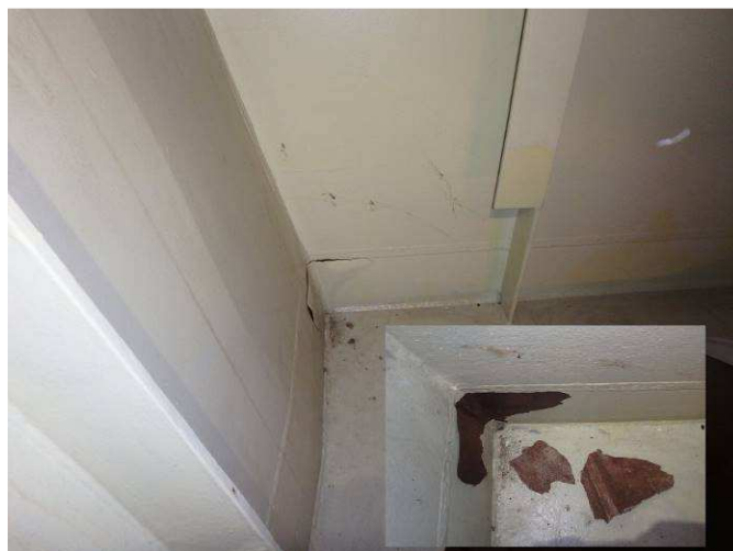
Obr. 118 - Pohled na výztuhy pylonu, odlupující se nátěr, počínající koroze základního materiálu
