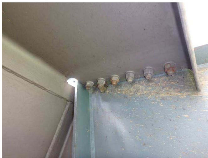
Obr. 160 – Pohled na šroubový styk svislé části římsy z vnitřní části, koroze spojovacího materiálu, znečištění ptačím trusem
