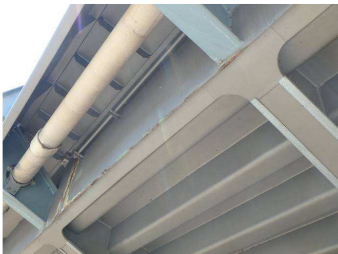
Obr. 13 – Pohled na svislý plech konzoly, koroze na hranách, podkorodování, kontaminace CHRL
