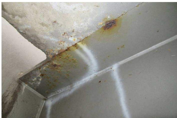
Obr. 04 – Pohled na styk ŽB desky a příčnicku, koroze na hranách, lok. prorozavění Ri5, výskyt CHRL
