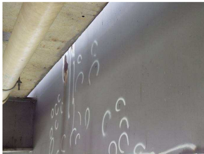
Obr. 76 - Pohled na stěnu parapetu pylonu, prerezávání Ri5, podkorodování, plošná koroze
