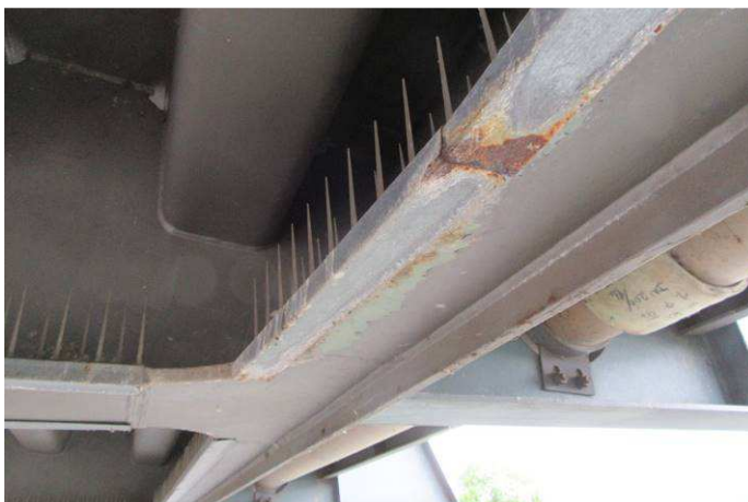
Obr. 40 - Pohled na NK a zábrany proti holubům, koroze na hranách, prerezávání Ri5, odlupování, plošná koroze plechů zábran
