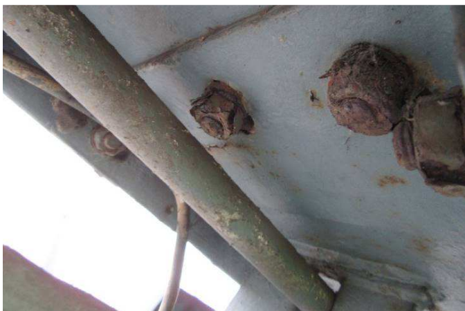
Obr. 183 – Pohled na madlo svodidla ze spodu, koroze spojovacího materiálu, prorezavění
