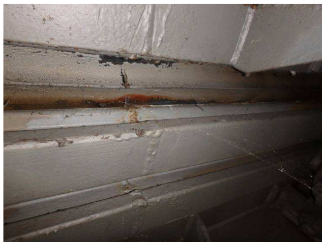
Obr. 302 – Pohled na těsnicí profil MZ, korozní produkty v oblasti gumy, protékání v okolí gumy
