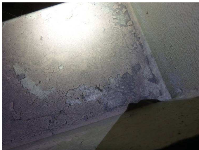
Obr. 125 – Pohled na výztuhu v komoře rampy, usazování drobných prachových částic
