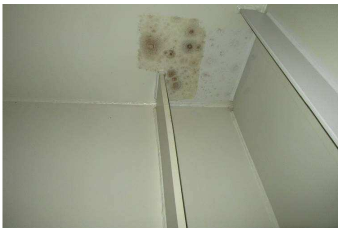
Obr. 130 – Pohled od komory mostu, výskyt plísní v oblasti oprav PKO
