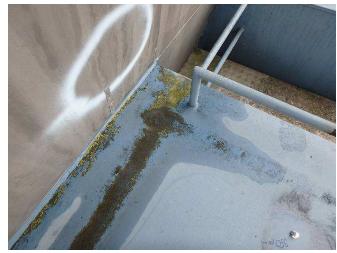
Obr. 90 – Pohled na vodorovné plochy příčníku pylonu (křídla), výskyt mechů a lišejníků, usazování nečistot, narušené vrchní nátěry
