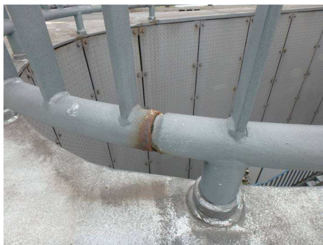
Obr. 232 – Pohled na slzičkové plechy kapotáže a zábradlí. Prerezavění, podkorodování
