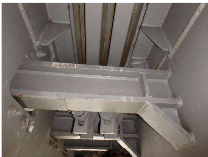
Obr. 33 – Pohled na zarážky u MZ, koroze na hranách, kontaminace ptačím trusem
