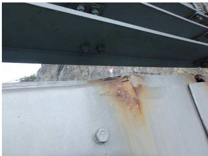
Obr. 157 - Pohled na vnější svislé plochy římsy, prorezavění, podkorodování
