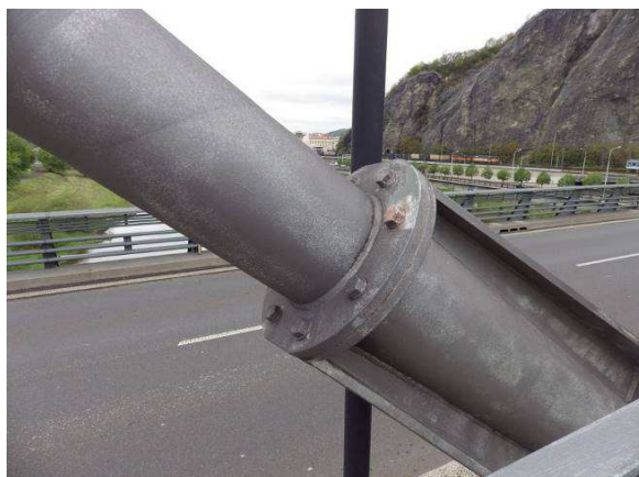
Obr. 212 – Pohled na závěs, koroze na hranách, smívání vrchního nátěru
