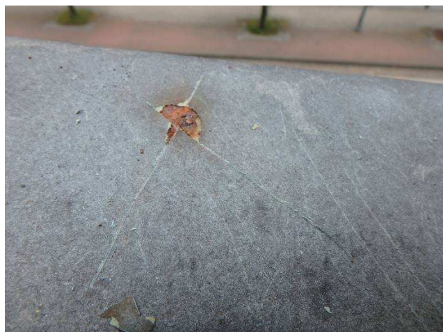
Obr. 218 – Pohled na madlo zábradlí, podkorodování, nevyhovující X-řez
