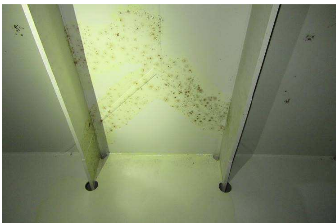
Obr. 132 - Pohled do komory mostu, výskyt plísní v oblasti oprav PKO
