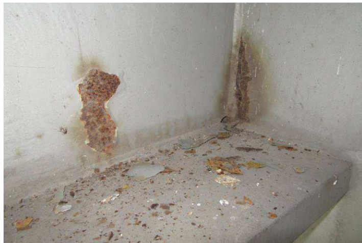
Obr. 10 – Pohled na styk příčnicku a parapetu pylonu, podkorodování, prorezavění
