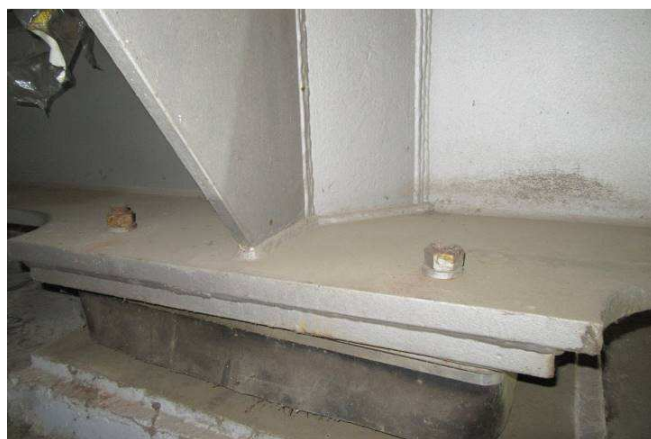
Obr. 310 – Pohled na uchycení ložiska, obráceně osazené šrouby (hlava by měla být zezhora)
