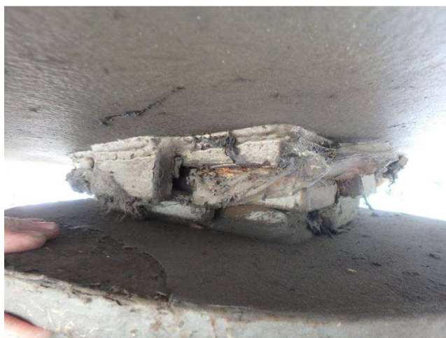
Obr. 316 – Pohled na atypické vahadlové ložisko na pilířích rampy, deformace ocelových částí, degradované a vyteklé PVC vložky, poškozená PKO na hlavě pilíře
