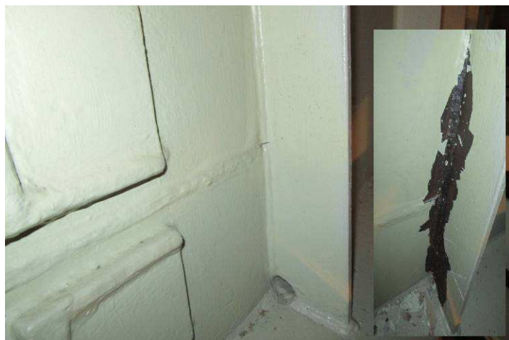
Obr. 111 – Pohled na výztuhu stěny pylonu, indikace trhliny v ONS, zjištěno následné plošné odlupování systému PKO, základní materiál bez známek koroze
