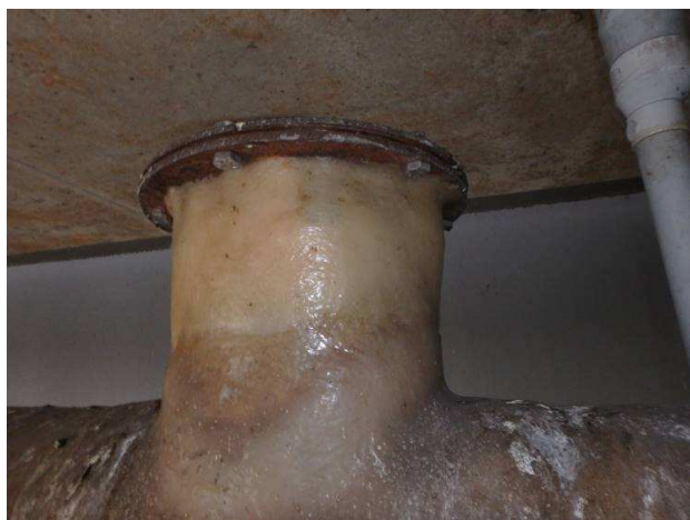
Obr. 248 – Pohled na odvodnění (čistící kus), plošná koroze, výrazné CHRL úsady, znečištění ptačím trusem
