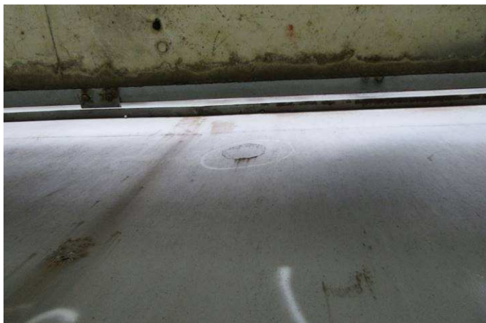
Obr. 75 - Pohled na stěnu parapetu pylonu, prerezávání Ri5, podkorodování
