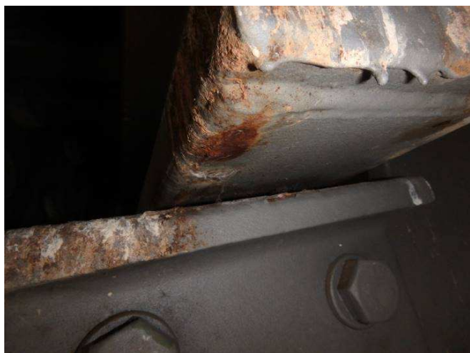
Obr. 297 – Pohled na ocelové zářezky MZ, intenzivní koroze
