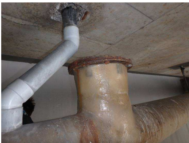
Obr. 247 – Pohled na odvodnění (čistící kus), koroze po vrstvách (lamelace), výrazné CHRL úsady, znečištění ptačím trusem
