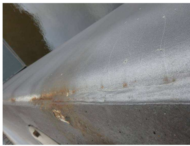
Obr. 150 - Pohled na vnější hranu římsy, prerezavění, podkorodování
