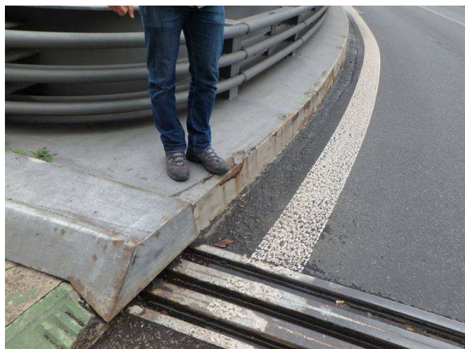
Obr. 140 - Pohled na svislou část obruby vnější římsy v oblasti MZ, prorozavění, podkorodování a odlupování ochranných nátěrů římsy
