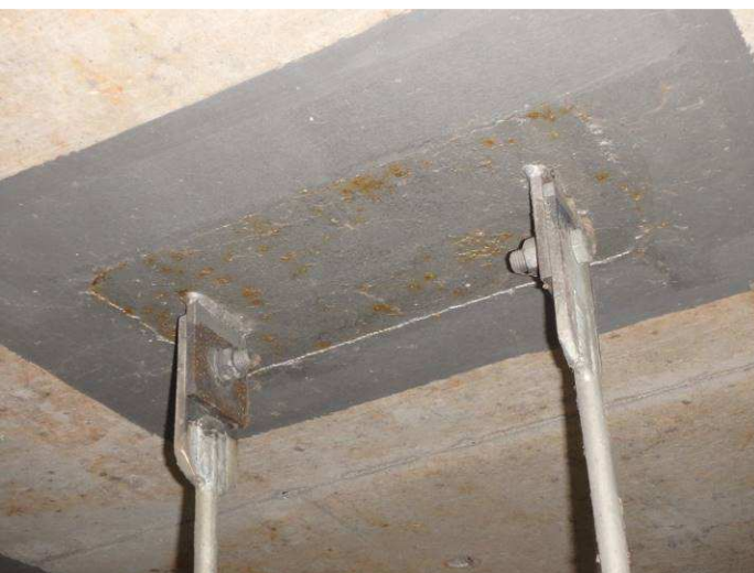
Obr. 42 – Pohled na uchycení odvodnění, prerezávání Ri4
