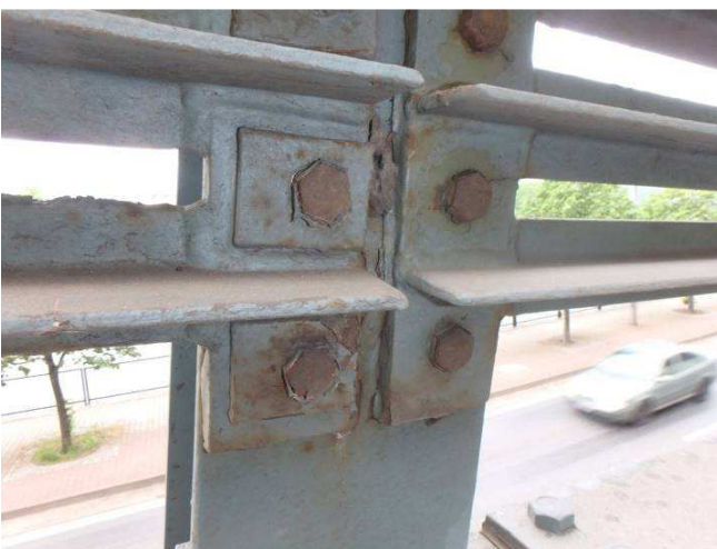
Obr. 197 – Pohled na šroubový styk výplně svodidla, prorezavění, podkorodování, koroze spojovacího materiálu
