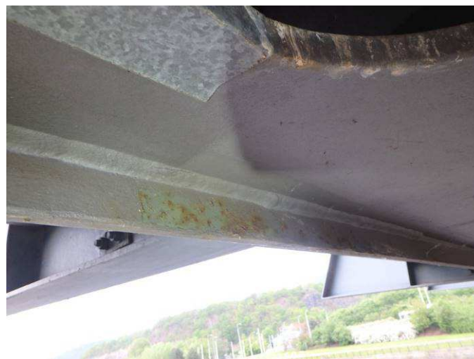
Obr. 22 - Pohled na převislou část koncového plechu konzoly, prorozavění Ri5, koroze na hranách, kontaminace ptačím trusem
