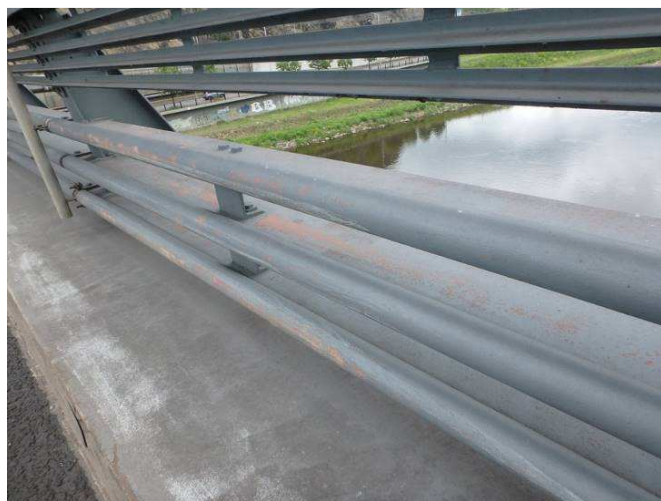
Obr. 200 – Pohled na vodorovné zachytňovací systémy, prorezavění, odlupování, smívání vrchního nátěru
