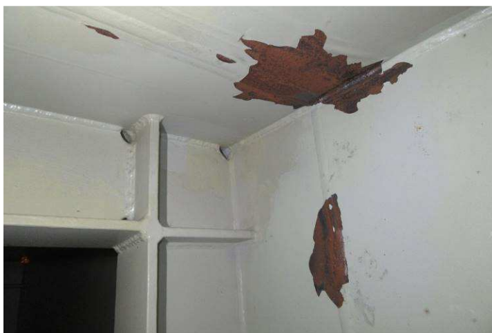
Obr. 114 – Pohled na montážní styk pylonu (parapetní část), odlupování celého souvrství ONS, podkorodování přilehlých oblastí
