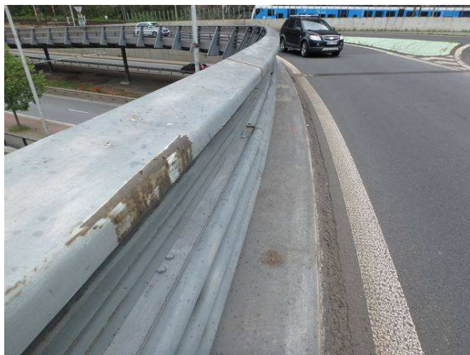
Obr. 192 - Pohled na madlo svodidla, plošná koroze, prorezávání
