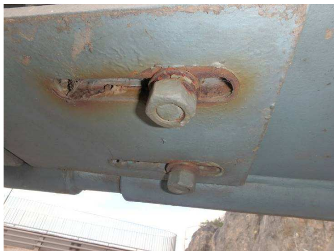
Obr. 206 – Pohled na uchycení vodorovného zádržného systému, prorazavění, koroze na hranách, koroze spojovacího materiálu
