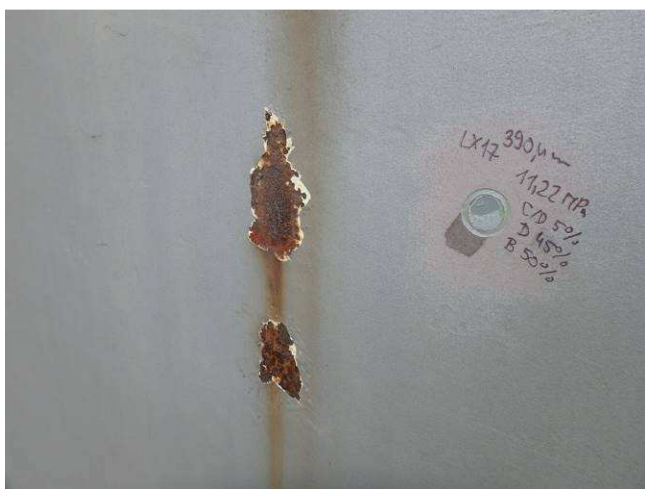
Obr. 65 – Pohled na plochu parapetu pylonu, prorozavění Ri5, plošná koroze, křídování
