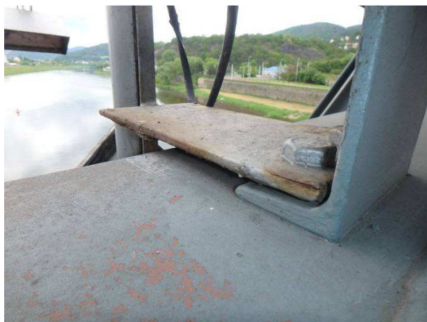
Obr. 284 – Pohled na uchycení konstrukce plavebních značek, intenzivní prorezavění, rovnoměrná i nerovnoměrná koroze
