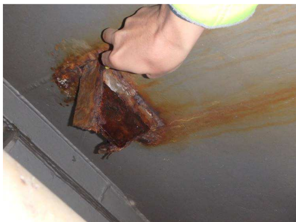
Obr. 255 – Pohled na pravděpodobné odvodnění v průběhu výstavby, intenzivní koroze po vrstvách, pravděpodobný průnik vody z vozovky
