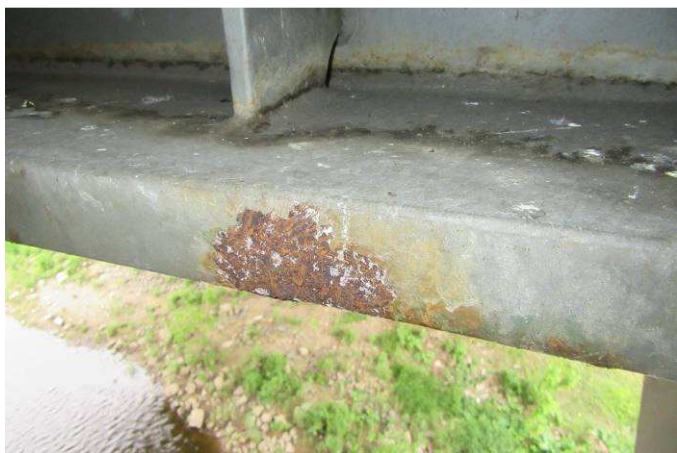
Obr. 11 – Pohled na spodní pásnici příčnicku, koroze na hranách, plošná koroze, podkorodování, znečištění ptačím trusem
