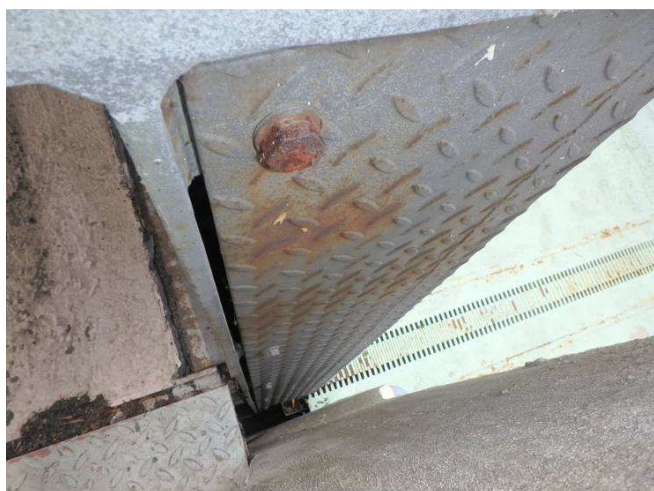
Obr. 231 – Pohled na slzičkové plechy kapotáže, prerezavění, koroze spojovacího materiálu
