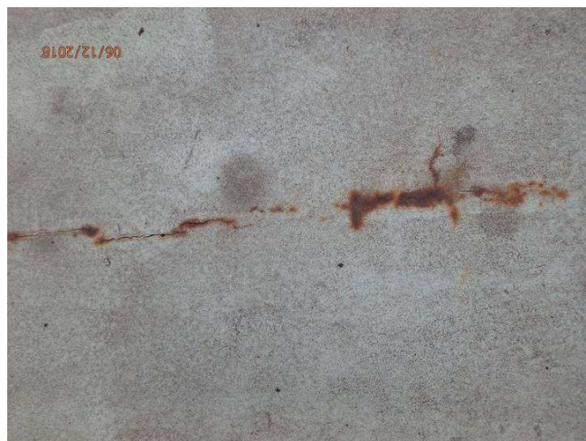
Obr. 278 – Pohled na trhliny v pochozí izolaci, koroze podkladních vrstev
