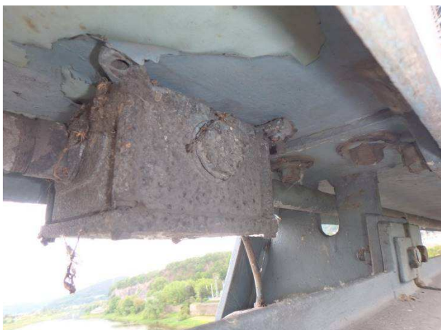
Obr. 283 – Pohled na elektroinstalaci pod madlem, intenzivní koroze a tvorba korozních produktů
