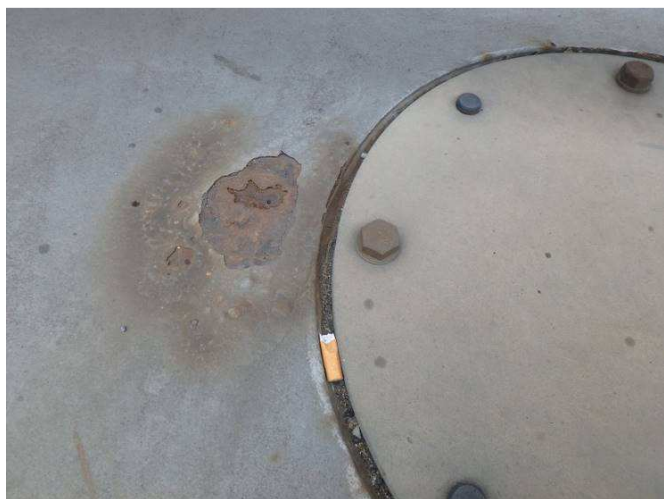
Obr. 141 – Pohled na vodorovnou římsovou část v blízkosti revizního otvoru, prorozavění Ri5, podkorodování, koroze spojovacího materiálu
