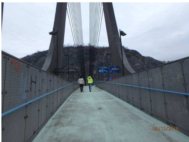
Obr. 235 – Pohled na slzičkové plechy a chodník, prerezávání, koroze spojovacího materiálu
