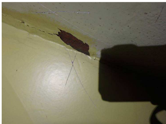
Obr. 119 - Pohled na stěnu komory, odlupující se ONS, podkorodování, koroze základního materiálu
