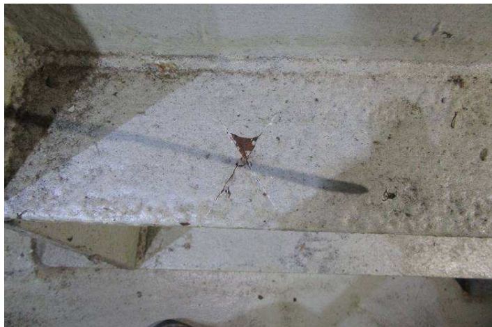
Obr. 99 – Pohled na výztuhy pylonu v patní části, prorozavění, podkorodování, zatřené korozní produkty a nečistoty, nevyhovující X-řez
