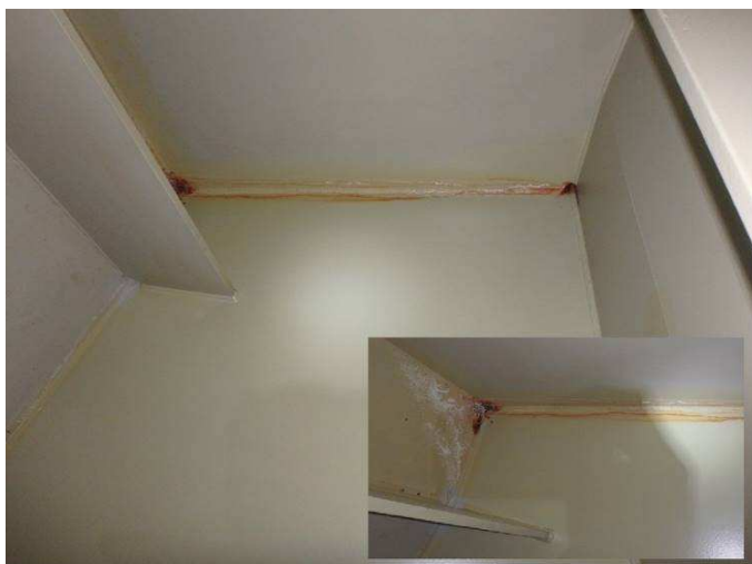
Obr. 128 – Pohled na výztuhy a styk plechů koncového příčnicku, prorezavění, netěsnící svar v rohu (zřejmě poruchy izolace), výskyt CHRL
