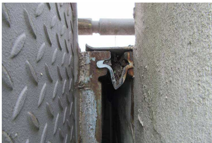
Obr. 288 – Pohled na MZ, koroze F-profilů, zcela zanesené gumy nečistotami, počínající degradace těsnících profilů
