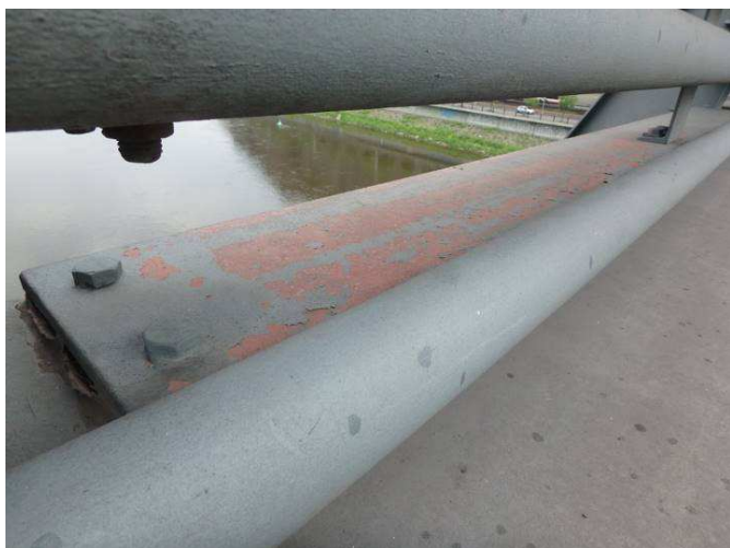
Obr. 187 – Pohled na vodorovné konstrukce zádržného systému, koroze na hranách, odlupování a smívání vrchního nátěru
