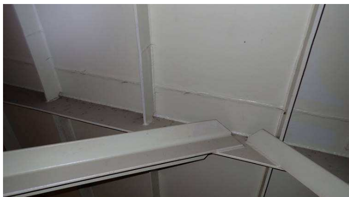
Obr. 123 – Pohled na montážní styk pylonu, praskání nátěru v oblasti montážního styku
