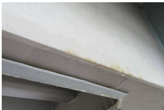
Obr. 18 – Pohled na svislý koncový plech konzoly, koroze na hranách, podkorodování
