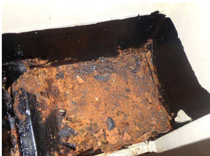
Obr. 106 - Pohled na L výztuhy pylonu, intenzivní prorezavění, plošná koroze, kondenzace vody bez možnosti odtoku
