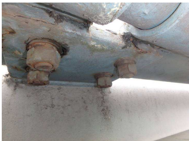
Obr. 177 - Pohled na přípoj vodorovného záchytného systému, prerezávání, koroze na hranách, odlupování, koroze spojovacího materiálu
