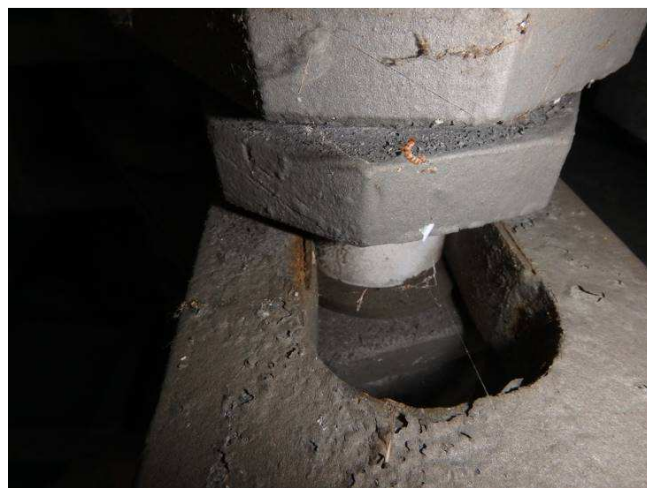
Obr. 296 – Pohled na detail nůžkového mechanismu MZ, drobná koroze
