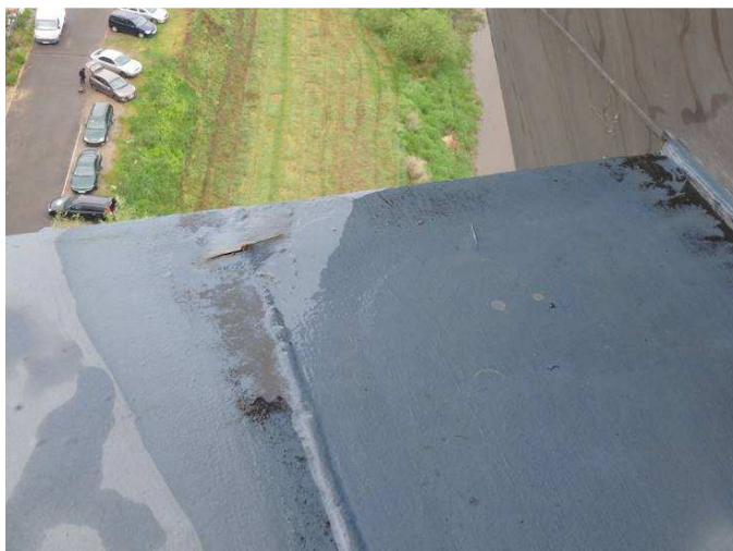
Obr. 88 – Pohled na vodorovnou plochu příčníku pylonu (křídla) v místě montážního svaru, prorozavění, odlupování od základního materiálu, podkorodování, křídování
