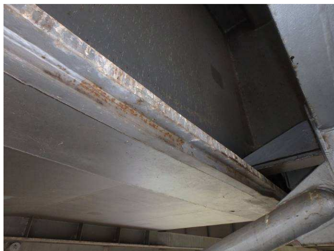
Obr. 20 – Pohled na spodní pás komory, koroze na hranách, prorozavění Ri5, podkorodování, kontaminace ptačím trusem
