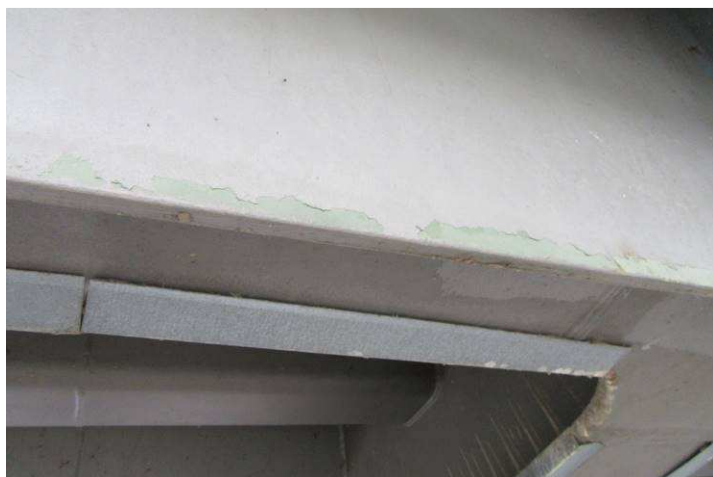
Obr. 49 – Pohled na svislý koncový plech konzoly, odlupování vrchních vrstev PKO, koroze na hranách
