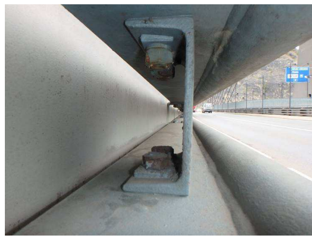
Obr. 178 – Pohled na spojku vodorovného záchytného systému, koroze spojovacího materiálu
