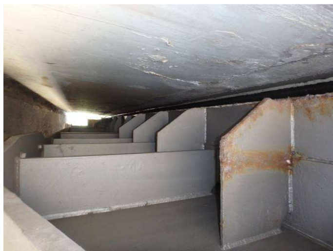
Obr. 36 – Pohled na koncové příčníky u MZ, prorezavění Ri5, podkorodování, plošná koroze
