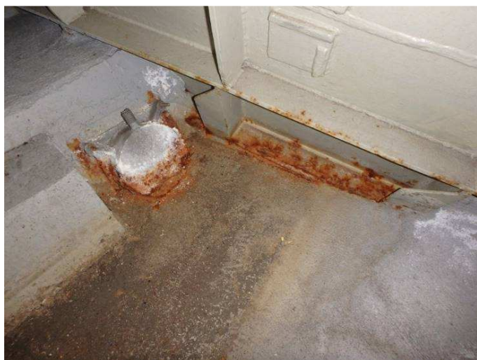
Obr. 102 - Pohled na patní část pylonu v místě krytu předpětí betonové části, intenzivní prorozavění, výskyt CHRL, podkorodování
