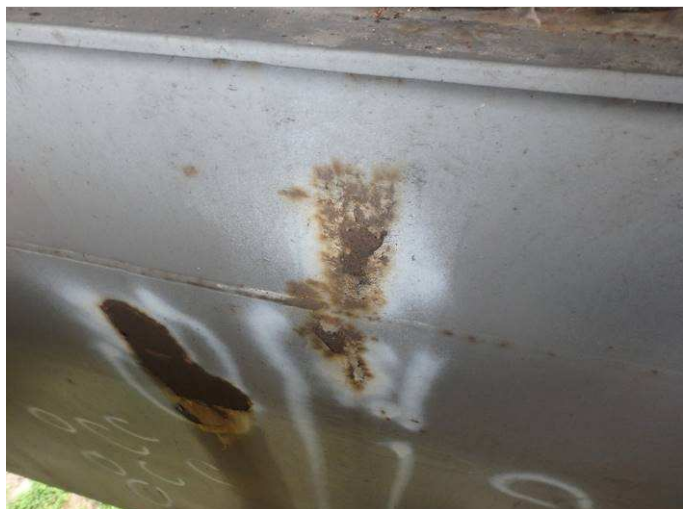
Obr. 77 - Pohled na stěnu parapetu pylonu, prerezávání Ri5, podkorodování, plošná koroze
