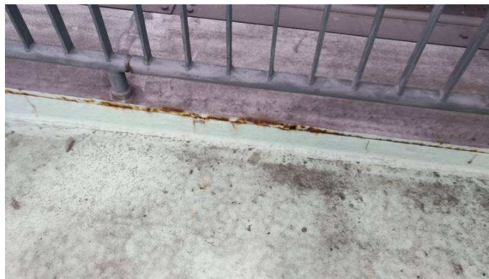
Obr. 274 – Pohled na hranu v místě pochozí izolace, ztráta ochranné funkce
