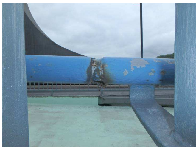
Obr. 225 – Pohled na spojku madla zábradlí, prorezavění, odlupování vrchního nátěru
