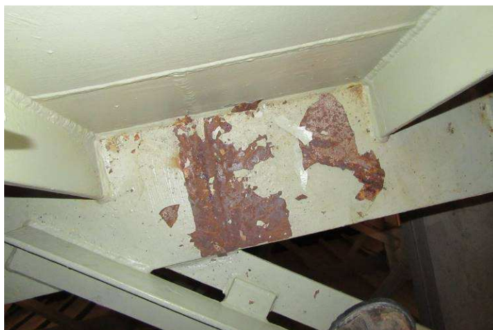
Obr. 110 – Pohled na montážní svar, odlupování, podkorodování, plošná koroze základního materiálu
