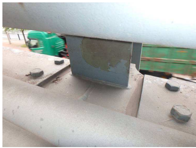
Obr. 238 – Pohled na sloupek svodidla, odlupování vrchní vrstvy
