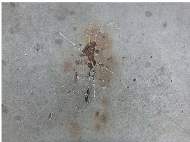
Obr. 217 – Pohled na plochu římsy, podkorodování, nevyhovující X-řez
