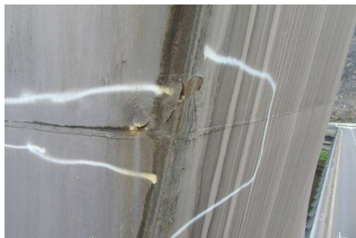
Obr. 54 – Pohled na PKO montážního styku pravého pylonu, odlupování, podkorodování, křídovávání
