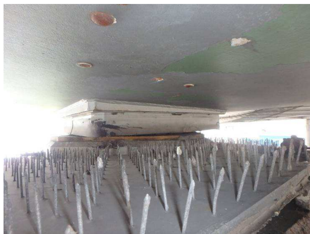
Obr. 314 – Pohled na ložisko, koroze spodní desky, odlupování nátěrů na NK
