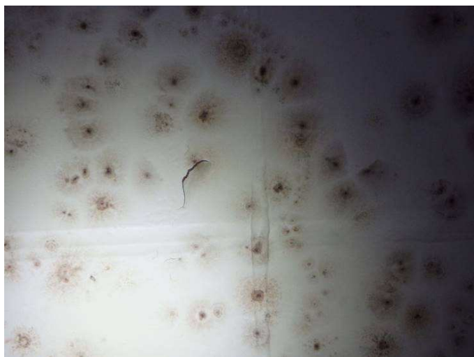
Obr. 135 – Pohled na stěnu komory mostu, výskyt černě zabarvených plísni kruhového tvaru, odlupování
