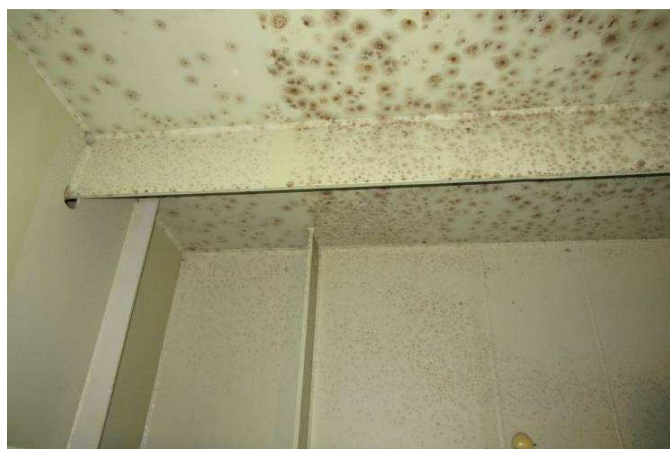
Obr. 131 – Pohled do komory mostu, výskyt černě zabarvených plísní
