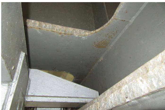
Obr. 17 – Pohled na spodní pásnice, koroze na hranách, prorezavění Ri5, podkorodování, kontaminace ptačím trusem
