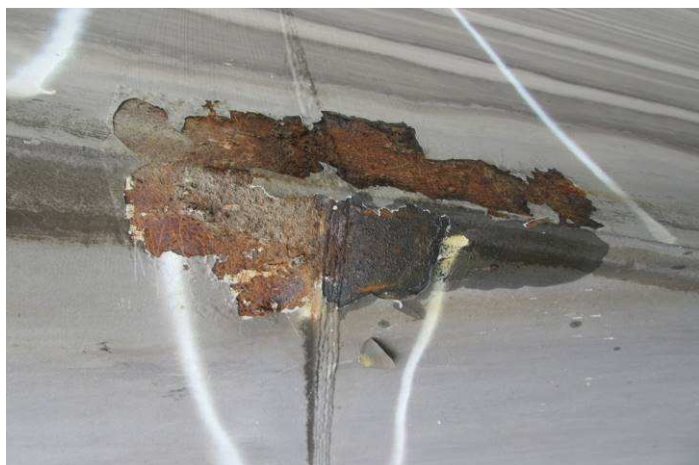
Obr. 55 – Pohled na montážní styk pravého pylonu po odstranění odlupujících OPS, plošná koroze, podkorodování, křídování
