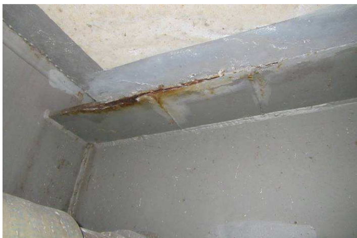
Obr. 03 – Pohled na styk ŽB desky a příčnicku, koroze na hranách, korozní produkty, výskyt CHRL
