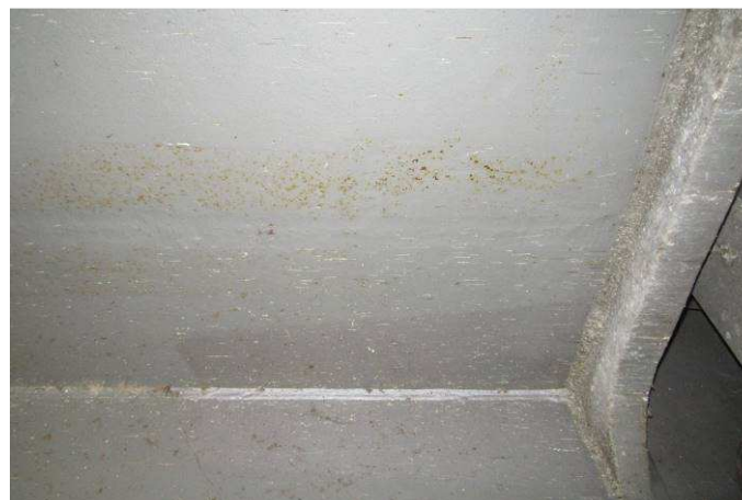
Obr. 24 – Pohled na plochu NK, prorozavění Ri3 až Ri4, kontaminace nečistotami
