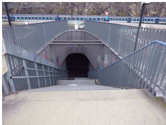
Obr. 230 – Pohled na slzičkové plechy kapotáže
