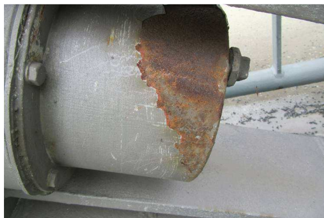
Obr. 210 – Pohled na krytku závěsu, podkorodování, plošná koroze
