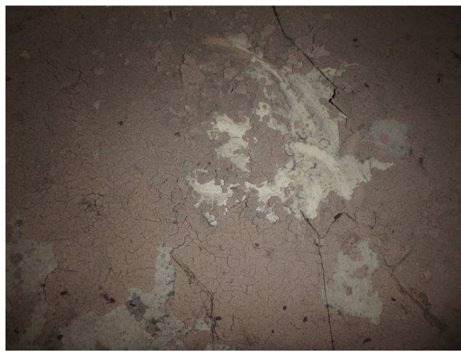
Obr. 126 – Pohled na dno komory rampy, usazování drobných prachových částic
