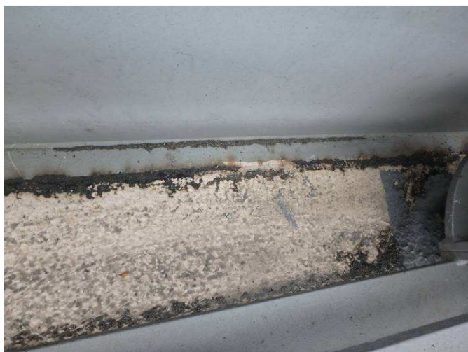
Obr. 163 – Pohled na vnitřní vodorovnou část římsy, prorozavění na hranách a podkorodování
