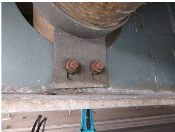
Obr. 254 – Pohled na přípoj odvodnění, koroze na hranách, koroze spojovacího materiálu
