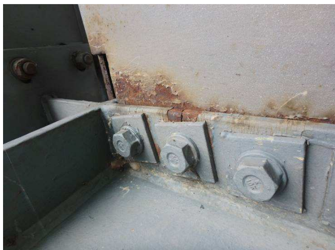
Obr. 269 - Pohled na přípoj svislé části římsy, praskliny v základním materiálu
