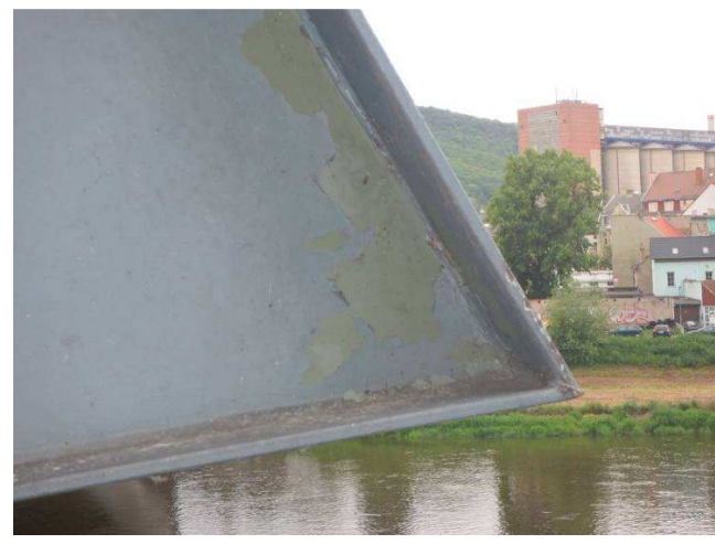
Obr. 240 – Pohled na spodní část sloupku svodidla (konzolová část), odlupování vrchní vrstvy
