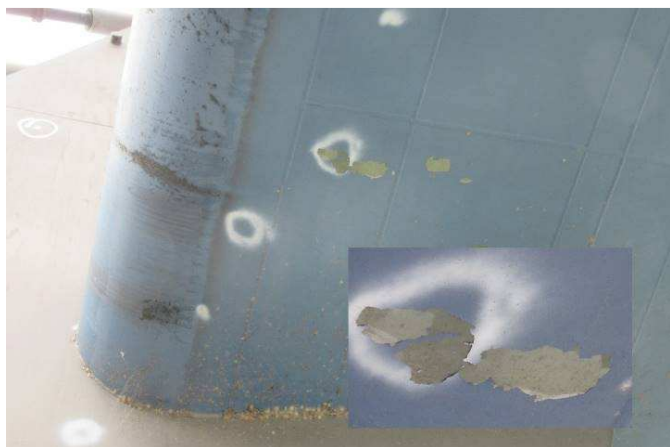
Obr. 85 – Pohled na příčník pylonu (křídlo), odlupování vrchních vrstev, prorozavění Ri4 až Ri5, křídování
