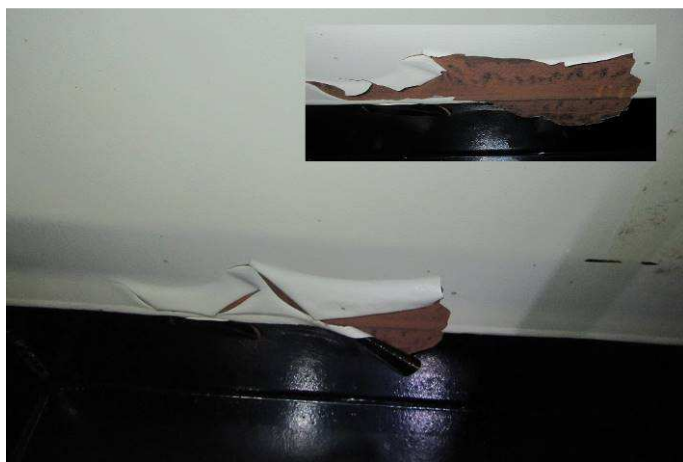
Obr. 108 - Pohled na styk stěny a výztuhy pylonu, odlupování kompletního ONS, počínající plošná koroze základního materiálu
