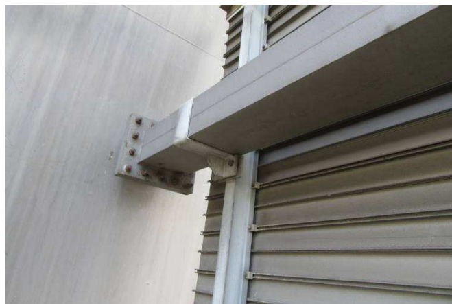
Obr. 280 – Pohled na uchycení portálu DZ k pylonu, koroze spojovacího materiálu
