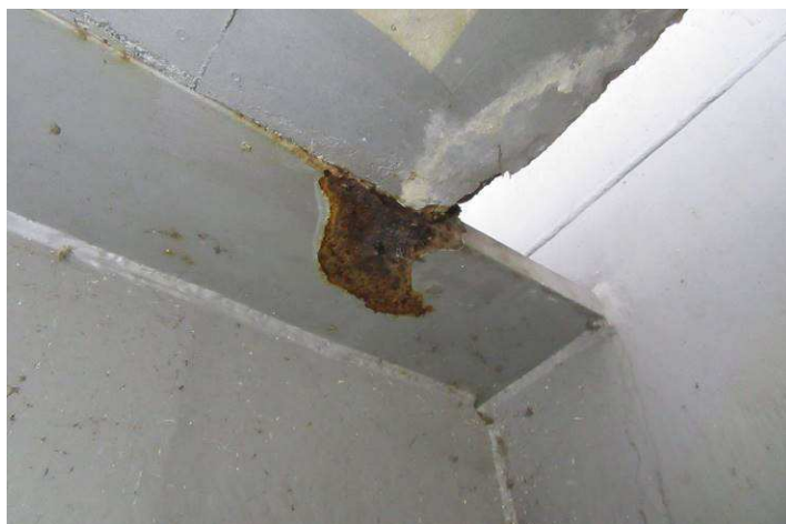
Obr. 02 – Pohled na styk ŽB desky a příčnicku, plošná koroze, koroze na hranách, vznik korozních produktů, výskyt CHRL
