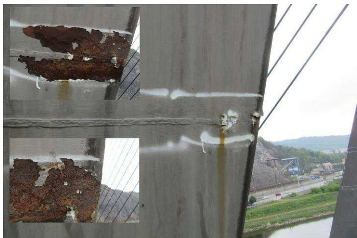
Obr. 57 – Pohled na montážní styk pravého pylonu, odlupování, podkorodování, plošná koroze, křídování
