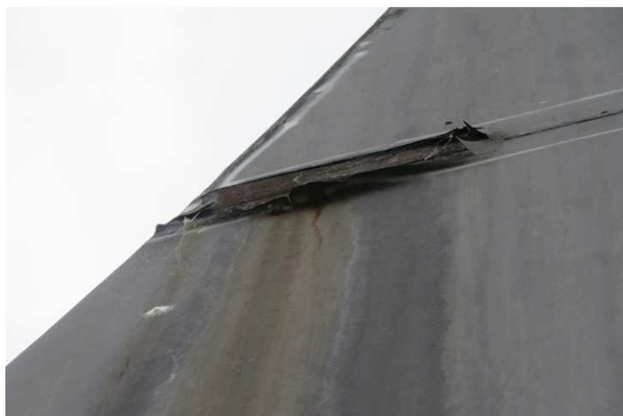
Obr. 56 – Pohled na montážní styk pylonu, odlupování stávajícího OPS, podkorodování, plošná koroze, křídování
