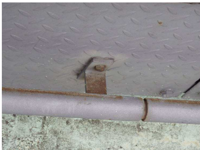
Obr. 223 – Pohled na vodící prvky zábradlí, prorezavění, plošná koroze
