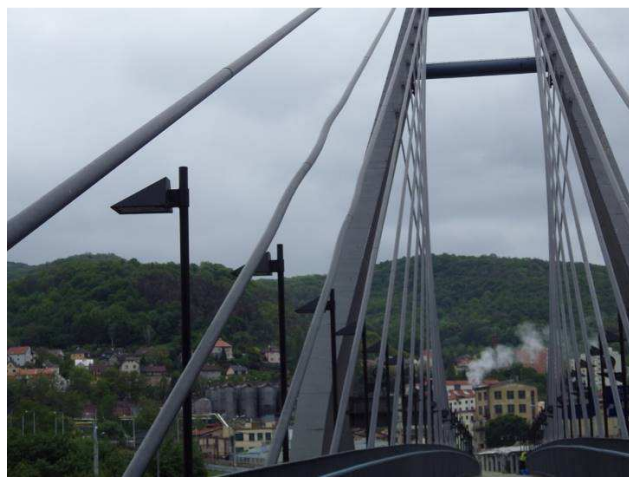
Obr. 262 - Pohled na závěsy mostu, výrazné zvlnění dvojice závěsů
