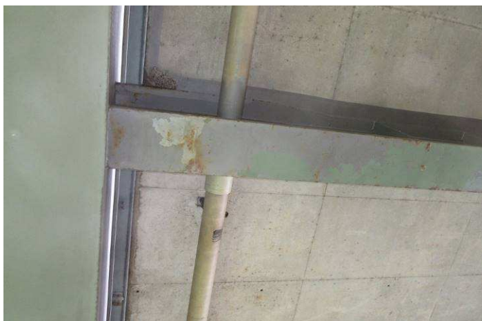
Obr. 43 – Pohled na příčník a parapetní nosník, odlupování vrchních vrstev, prerezávání Ri5, koroze na hranách
