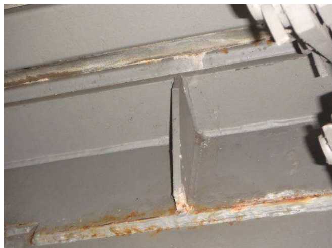
Obr. 32 – Pohled na montážní svary MZ, prorezavění Ri5, podkorodování
