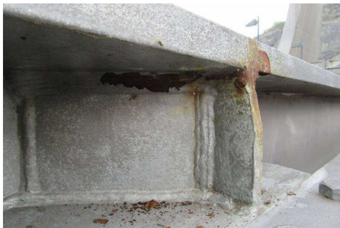
Obr. 173 – Pohled na připojení sloupku svodidla, prerezavění, podkorodování, odlupování, smívání vrchního nátěru
