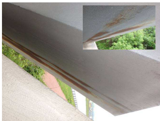
Obr. 66 – Pohled na koncovou část parapetu pylonu, prorozavění a plošná koroze
