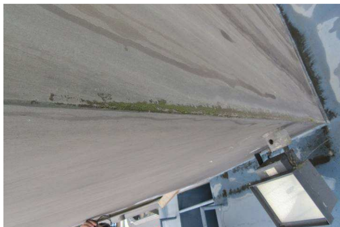
Obr. 95 – Pohled na bok pylonu, výskyt mechtů, narušení vrchních vrstev nátěrů, křídovávání
