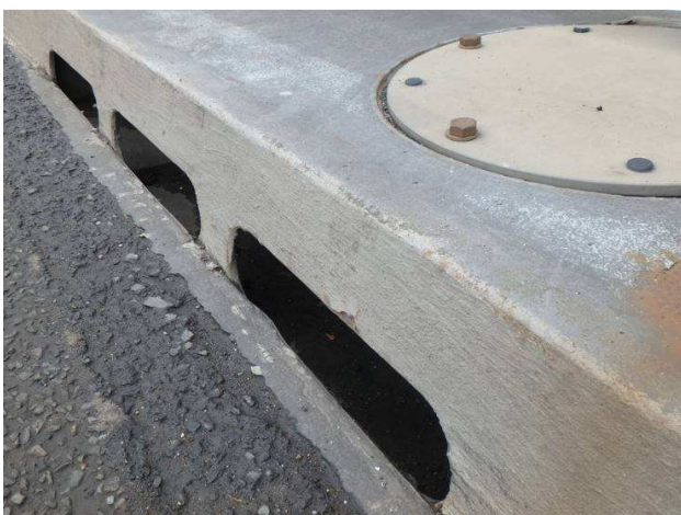
Obr. 249 – Pohled na odvodňovací otvory u říms včetně čistícího poklopu, odlupování ochrany, prorozavění, degradované asfaltové vrstvy, koroze spojovacího materiálu
