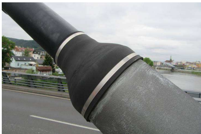
Obr. 265 - Pohled na krycí manžetu konce závěsu, degradace gumy, smívání nátěrů ocelové části
