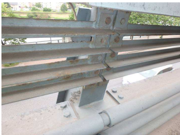
Obr. 219 – Pohled na šroubové styky svodidla, podkorodování, prorozavění, koroze spojovacího materiálu
