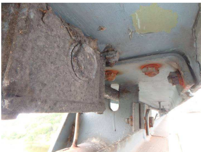
Obr. 287 - Pohled na spodní líc madla s rozvodem elektro, intenzivní prorezavění, rovnoměrná i nerovnoměrná koroze, elektro skříň a rozvody- úplná degradace PKO
