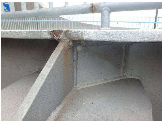
Obr. 181 – Pohled na připojení sloupku svodidla, prorezavění, podkorodování, smívání vrchního nátěru
