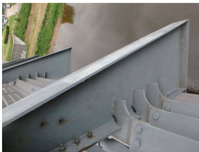
Obr. 186 – Pohled na vnější sloupek svodidla, prorezavění a koroze spojovacího materiálu
