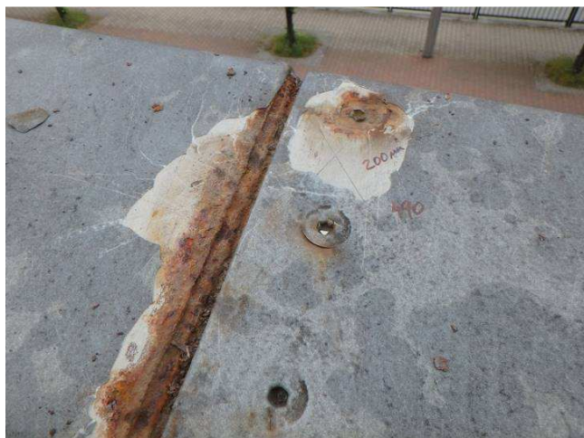
Obr. 195 – Pohled na styk madla svodidla, koroze na hranách, podkorodování, koroze spojovacího materiálu
