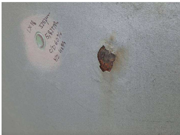
Obr. 67 – Pohled na stěnu pylonu, prorezavění, podkorodování, plošná koroze, křídování
