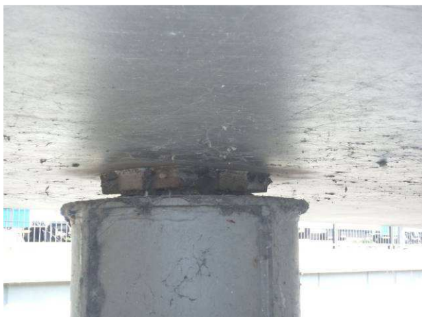
Obr. 245 – Pohled na pilíř rampy a ložisko
