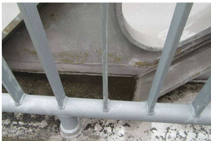
Obr. 208 – Pohled na kotevní oblast závěsu, prorazavění Ri3 až Ri4, koroze na hranách, smívání vrchního nátěru
