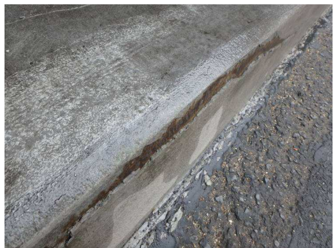
Obr. 143 - Pohled na svislou část obruby vnější římsy, prorozavění, podkorodování a odlupování ochranných nátěrů římsy
