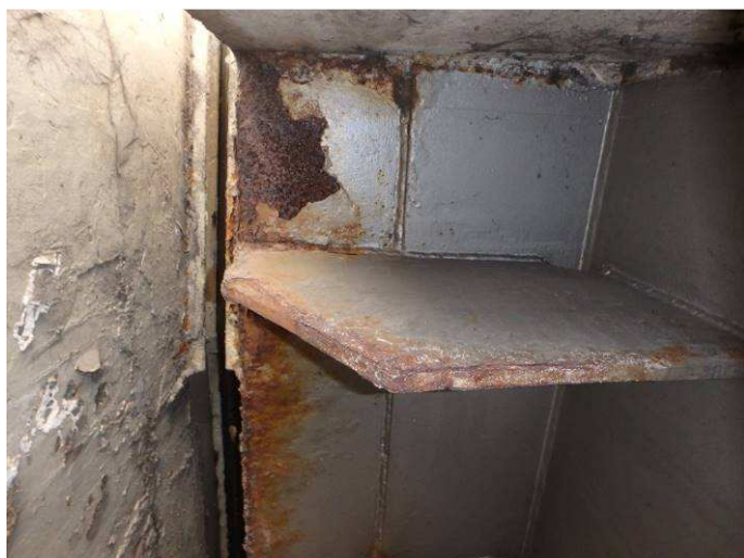
Obr. 35 – Pohled na koncové příčníky u MZ, prorezavění Ri5, podkorodování, plošná koroze
