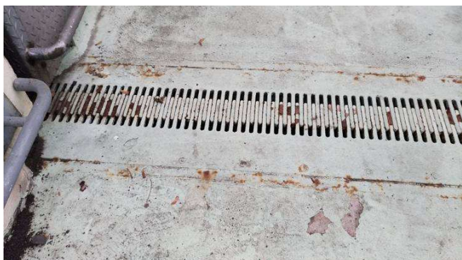
Obr. 289 – Pohled na prstový MZ, prerezávání, podkorodování, výskyt korozních produktů základního materiálu
