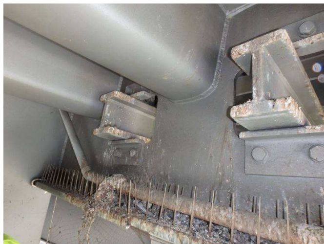
Obr. 304 – Pohled na zarážky MZ, prorozavění, podkorodování, úsady ptačího trusu, koroze odvodnění
