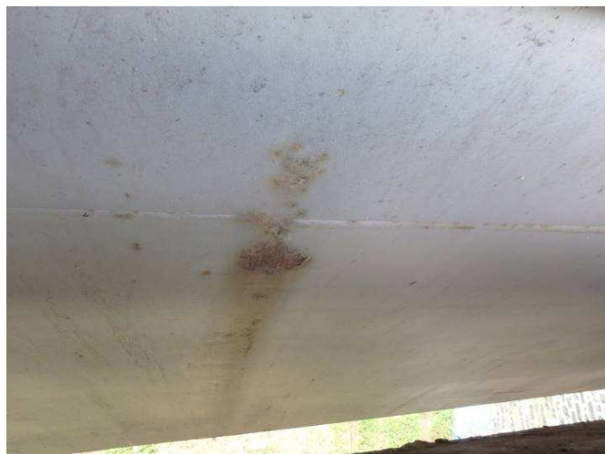
Obr. 78 Pohled na stěnu parapetu pylonu, prerezávání Ri5, podkorodování
