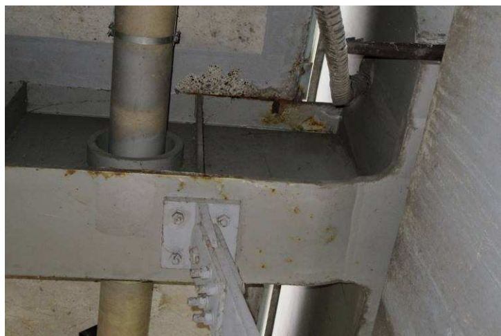
Obr. 14 – Pohled na koncový příčník, koroze na hranách, prorezavění Ri3-Ri5, kontaminace ptačím trusem a CHRL
