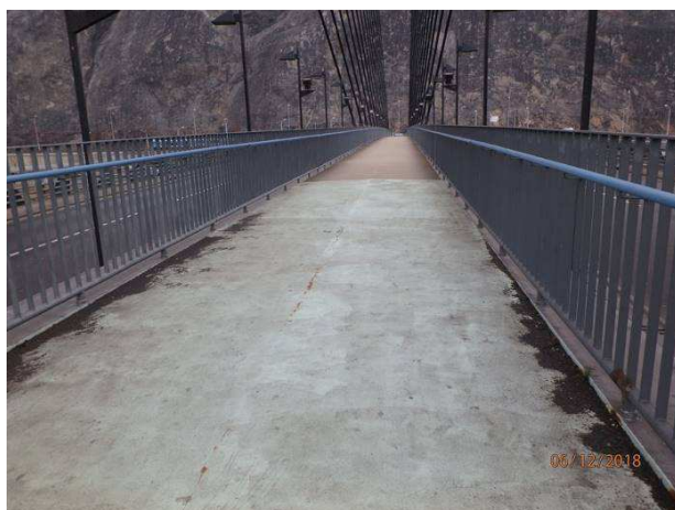
Obr. 276 – Pohled na pochozí izolaci, trhliny ve středové části, koroze základního materiálu
