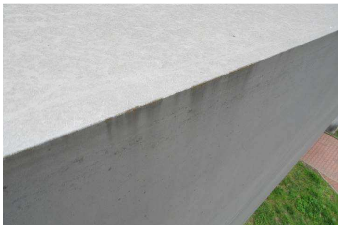
Obr. 71 – Pohled na hranu parapetu pylonu, koroze na hranách, podkorodování, křídování
