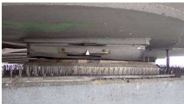
Obr. 311 – Pohled na ložisko, koroze spojovacího materiálu, porušený ukazatel pohybu
