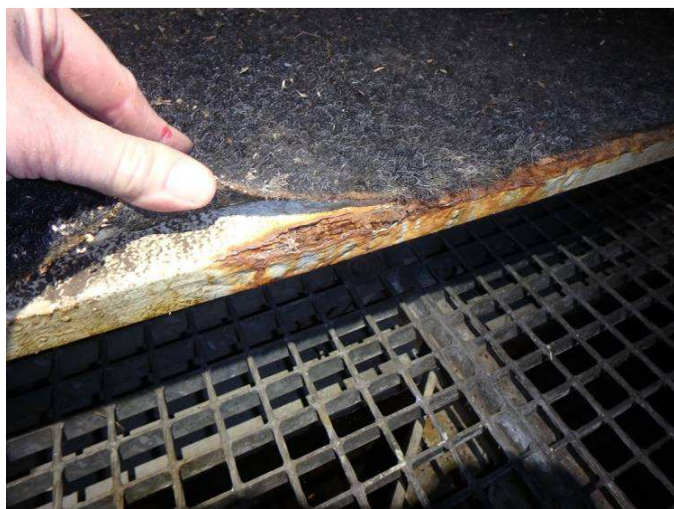
Obr. 104 - Pohled na plech u vstupu do pylonu, prorezavění a výskyt koroze po vrstvách (lamelace)
