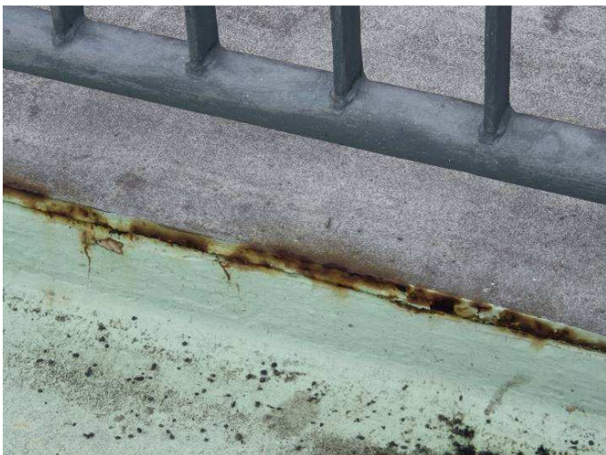
Obr. 167 – Pohled na horní pas komory, prorozavění na hranách, podkorodování, smívání vrchního nátěru
