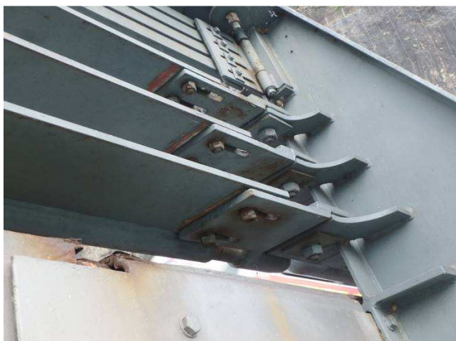
Obr. 207 – Pohled na dilatační úsek svodidla, prorazavění, koroze na hranách styků
