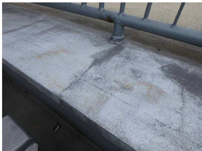
Obr. 171 - Pohled na horní pas komory, prerezavění Ri3, smívání vrchního nátěru
