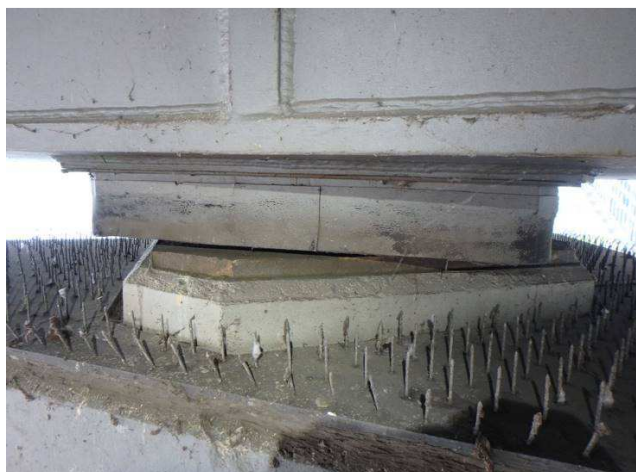
Obr. 313 – Pohled na ložisko, koroze spodní desky
