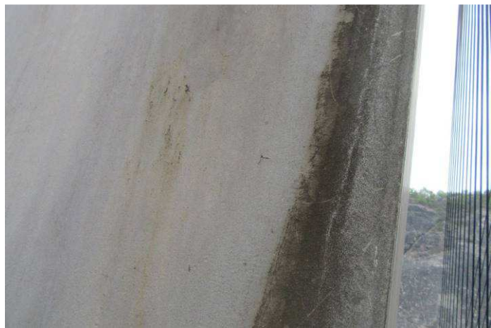
Obr. 69 – Pohled na pylon, prorezavění Ri3 až Ri4, na hranách usazování nečistot a mečů, křídování
