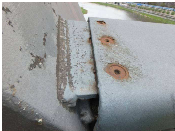
Obr. 184 – Pohled na přípoj madla svodidla, koroze spojovacího materiálu, koroze na hranách styku
