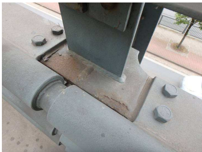
Obr. 194 – Pohled na uchycení vodorovného zádržného systém, prorezavění, podkorodování, plošná koroze
