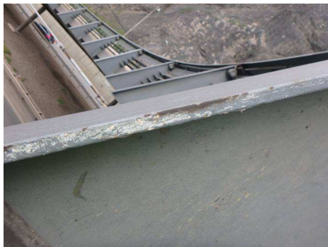
Obr. 204 – Pohled na sloupek svodidla, koroze na hranách, smívání vrchního nátěru
