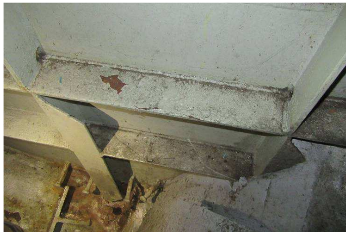
Obr. 100 - Pohled na výztuhy pylonu v patní části, prorozavění, podkorodování, zatřené korozní produkty a nečistoty
