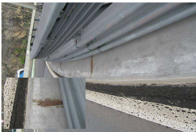
Obr. 137 - Pohled na vnější římsové obruby, prorezavění Ri5, plošná koroze, odlupování, křídování a smívání vrchního nátěru
