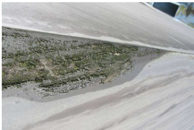
Obr. 94 – Pohled na hranu pylonu, výskyt mechtů a narušení vrchní vrstvy nátěru, křídovávání
