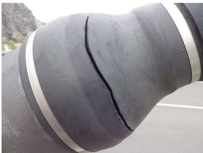
Obr. 263 – Pohled na krycí manžetu konce závěsu, trhлина a degradace gumy
