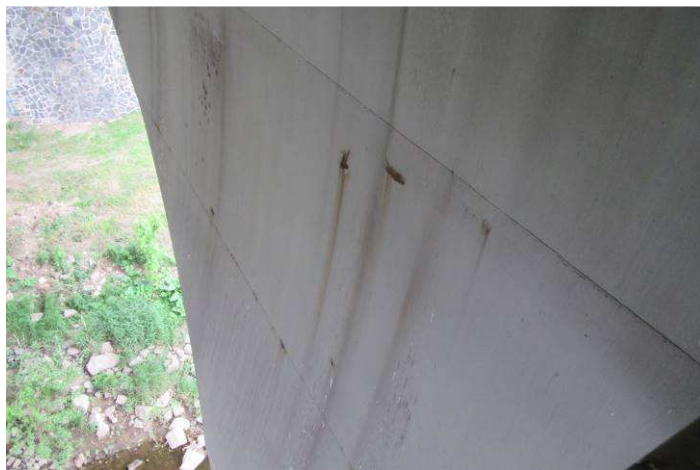
Obr. 70 – Pohled na pylon, lokální prorezavění Ri4 až Ri5, podkorodování, křídování
