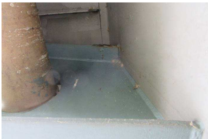
Obr. 25 – Pohled na montážní svary konzolové části ke koncovému plechu konzoly, koroze na hranách, podkorodování
