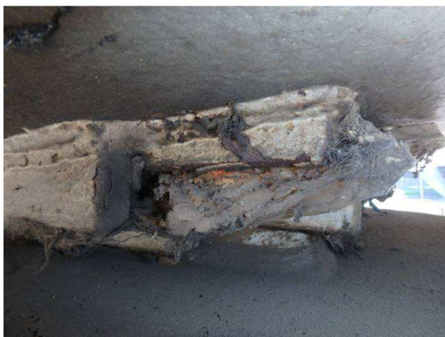
Obr. 317 – Detailní pohled na atypické vahadlové ložisko na pilířích rampy, deformace ocelových částí, degradované a vyteklé PVC vložky
