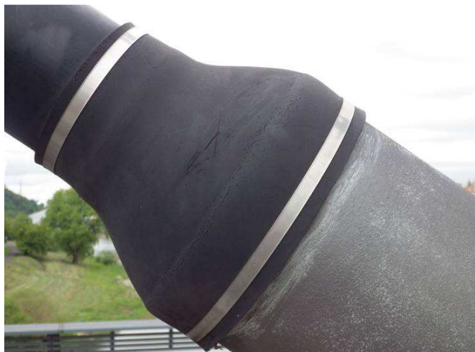
Obr. 267 - Pohled na krycí manžetu konce závěsu, degradace gumy, mechanické poškození, smívání nátěrů ocelové části
