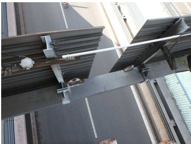
Obr. 281 – Pohled na portál DZ, plošná koroze v místě montážních ok
