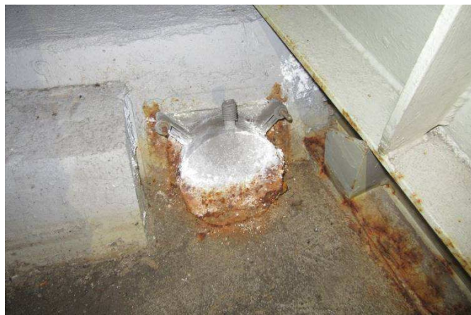
Obr. 268 - Pohled na injektážní krytku předpětí betonové části pylonu, prerezávání, nerovnoměrná koroze, významné usazeniny CHRL
