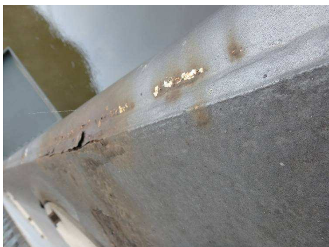
Obr. 147 - Pohled na vnější hranu římsy, prerezavění, podkorodování
