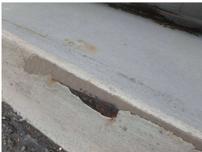
Obr. 139 – Pohled na svislou část obruby vnější římsy, prorozavění, podkorodování a odlupování ochranných nátěrů římsy
