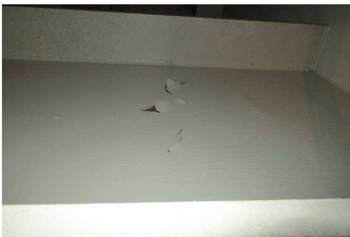
Obr. 113 Pohled na stěnu vnitřního příčnicku pylonu (parapetní část), odlupování celého souvrství ONS
