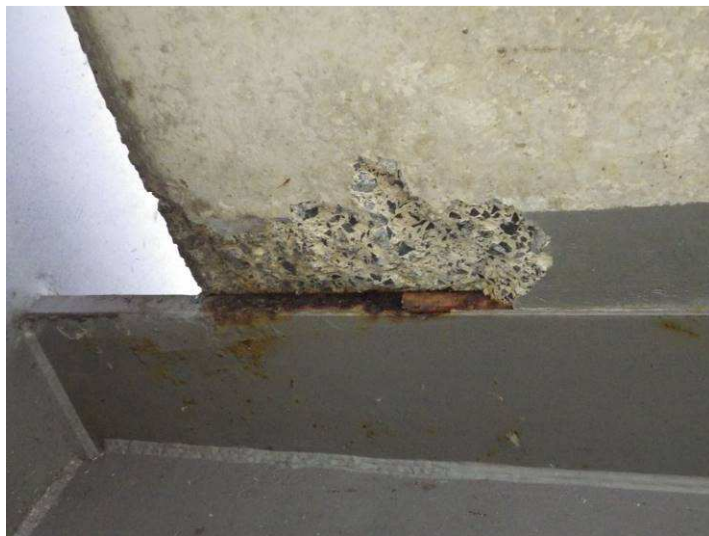
Obr. 08 – Pohled na připojení příčnicku ke spráhující desce, prorezavění Ri4, koroze na hranách, plošná koroze, výskyt CHRL
