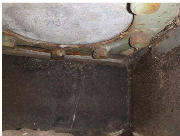
Obr. 250 – Pohled na čistící poklop uvnitř odvodnění, koroze na hranách, prorozavění R5, koroze spojovacího materiálu
