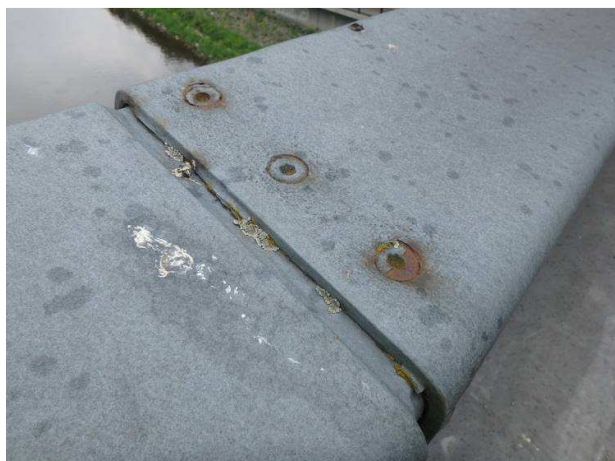
Obr. 241 – Pohled na spoj madla, výskyt hub a lišejníků, koroze spojovacího materiálu
