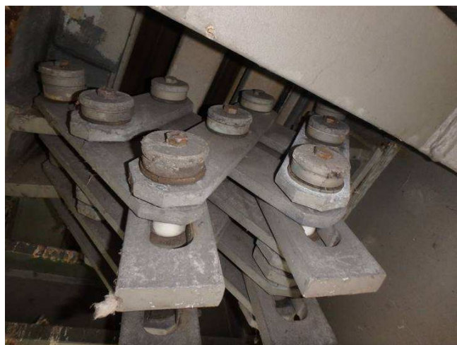
Obr. 298 – Pohled na nůžkový mechanismus MZ, drobná koroze
