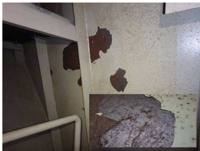
Obr. 120 - Pohled na koncovou část parapetu pylonu, odlupování ONS, výskyt plísní, počínající koroze základního materiálu
