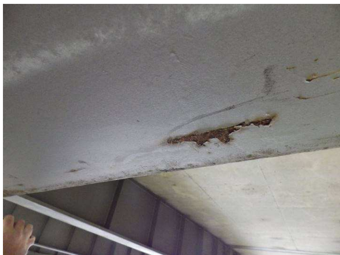
Obr. 73 – Pohled na spodní pas parapetu pylonu, prerezávání, koroze na hranách, podkorodování
