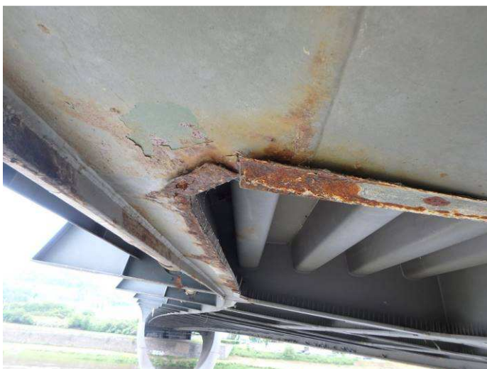
Obr. 41 - Pohled na NK a zábrany proti holubům, koroze na hranách, prerezávání Ri5, odlupování vrchního nátěru, plošná koroze plechu zábran a NK
