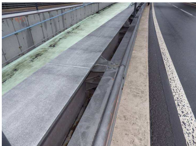
Obr. 229 Pohled na slzičkové plechy kapotáže
