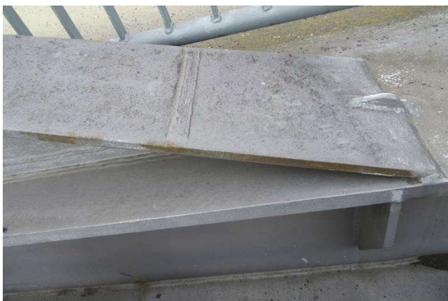
Obr. 211 – Pohled na kotevní oblast závěsu, prorezavění, smívání vrchního nátěru
