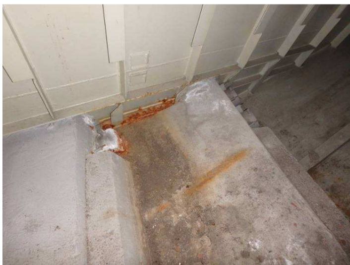
Obr. 101 – Pohled na patní část pylonu, styk oceli a betonu, intenzivní prorozavění, výskyt CHRL, podkorodování a odlupování ONS
