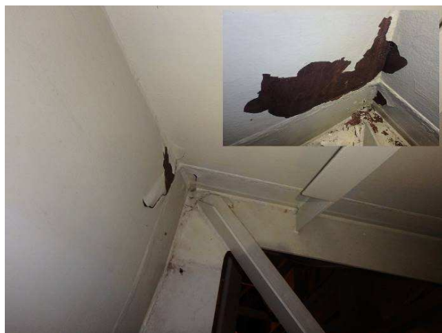
Obr. 116 - Pohled na výztuhu pylonu (parapetní část), odlupování celého souvrství ONS, podkorodování přilehlých oblastí
