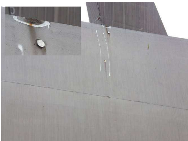
Obr. 63 – Pohled na levý parapet pylonu, koroze na hranách, podkorodování, prorozavění Ri5, křídování
