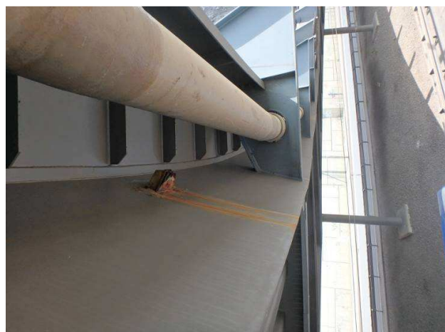
Obr. 258 - Pohled na průnik vlhkosti a vody z vozovky pravděpodobně špatně zaslepenými dočasnými odvodňovači
