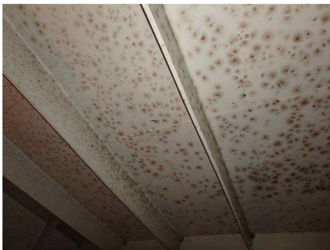
Obr. 133 – Pohled do komory mostu, výskyt černě zabarvených plísni, odlupování
