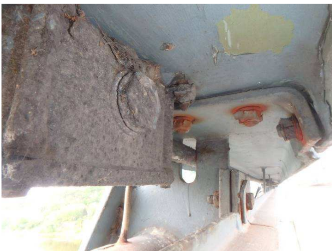
Obr. 201 – Pohled na přípoj sloupku a madla svodidla, koroze spojovacího materiálu, odlupování vrchních vrstev, plošná koroze elektro zařízení
