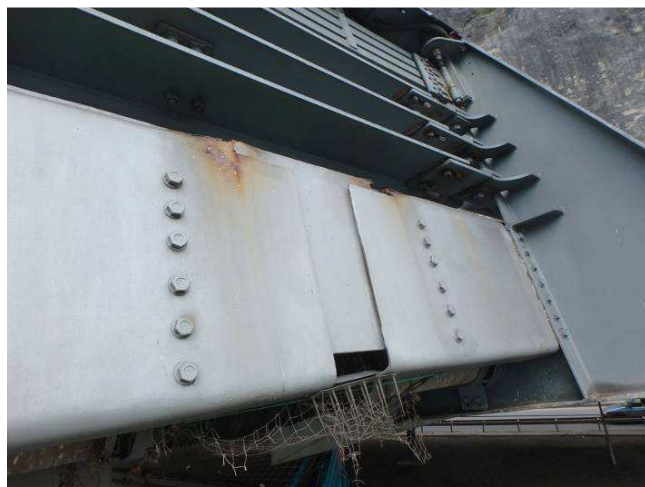
Obr. 156 - Pohled na vnější svislé plochy římsy, koroze na hranách, prerezávání
