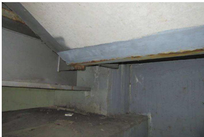
Obr. 16 – Pohled na zakončení mostu, koroze na hranách, prorezavění
