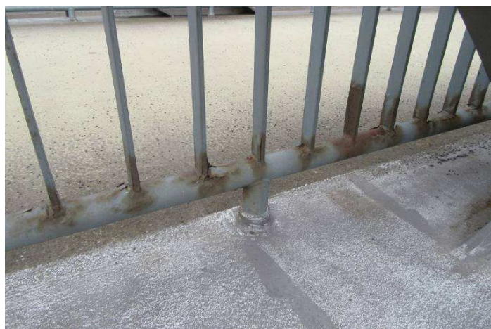
Obr. 220 – Pohled na spodní pas zábradlí, intenzivní prorozavění, podkorodování, plošná koroze
