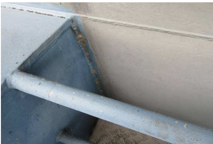
Obr. 81 – Pohled na montážní svar příčnicku pylonu, prorezavění, podkorodování, křídování
