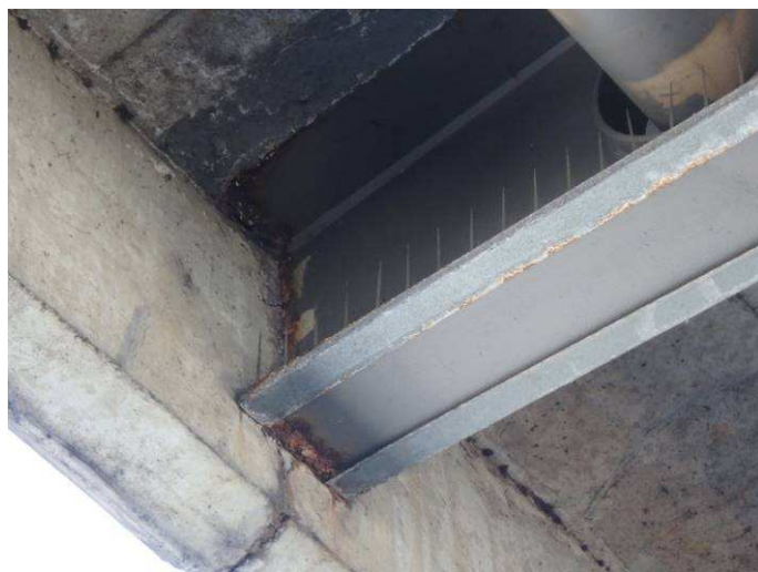
Obr. 38 – Pohled na styk konzoly a betonové římsy na rampě, podkorodování a plošná koroze oblastí přilehlých k betonu
