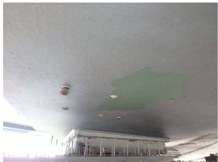
Obr. 52 – Pohled na uložení NK, odlupování vrchního nátěru
