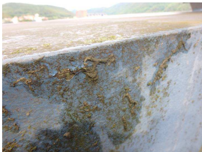
Obr. 92 Pohled na boční plochu příčnicku pylonu (křídla), výskyt mechtů a lišejníků, usazování nečistot, narušené vrchní nátěry, prorozavění, odlupování vrchních vrstev
