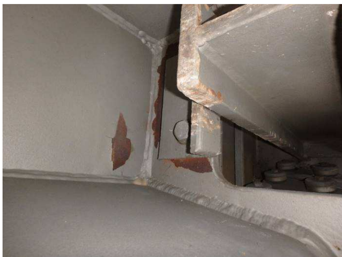
Obr. 31 – Pohled na koncovou část MZ, odlupování, prorezavění
