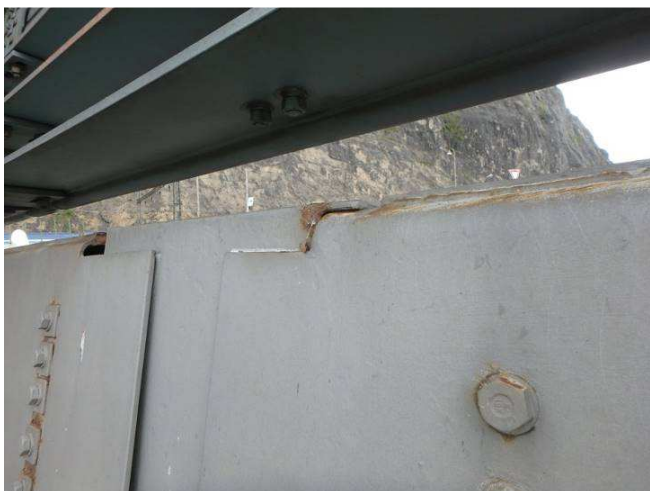
Obr. 155 - Pohled na vnější svislé plochy římsy, koroze na hranách, prerezávání, koroze spojovacího materiálu
