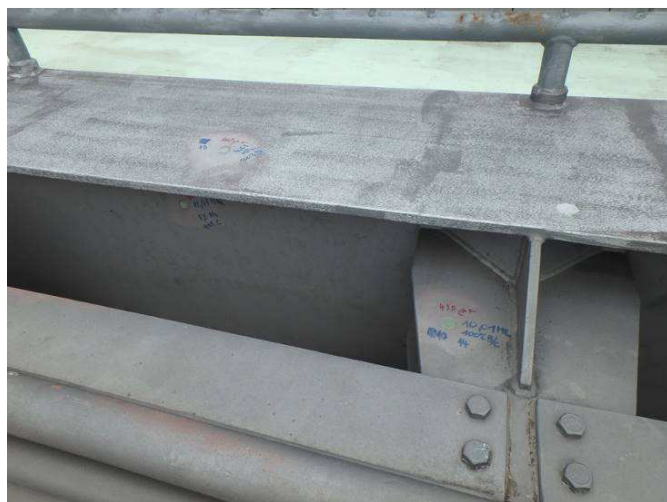
Obr. 172 - Pohled na horní pas komory, prerezavění Ri3, smívání vrchního nátěru
