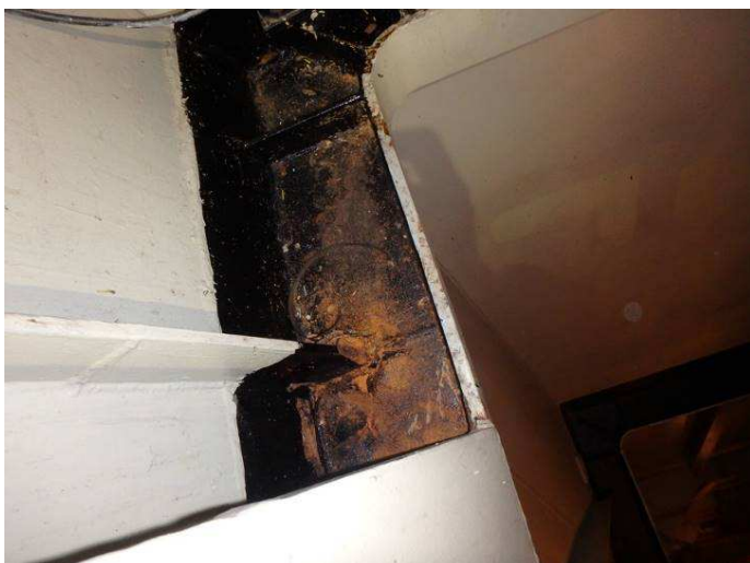
Obr. 105 - Pohled na L výztuhy pylonu, intenzivní prorezavění, plošná koroze, kondenzace vody bez možnosti odtoku
