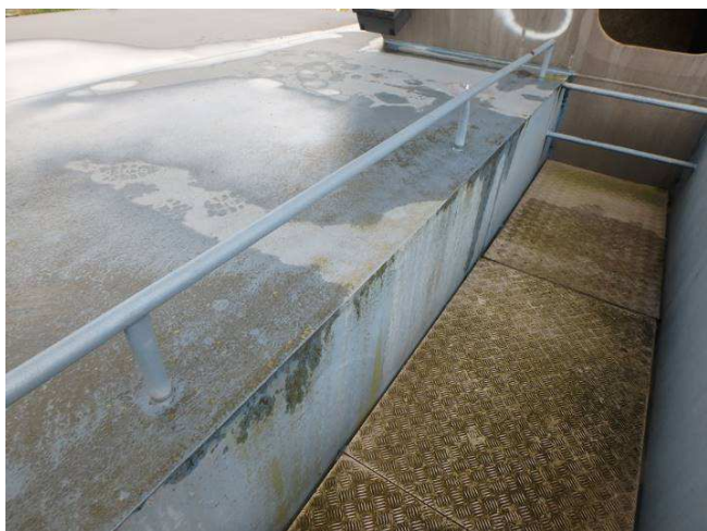
Obr. 91 - Pohled na vodorovné plochy příčnicku pylonu (křídla), výskyt mechtů a lišejníků, usazování nečistot, narušené vrchní nátěry
