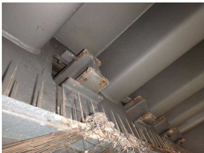
Obr. 301 – Pohled na zarážky MZ, prorozavění, podkorodování, úsady ptačího trusu
