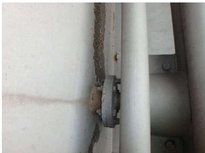
Obr. 182 – Pohled na připojení sloupu VO, prorezavění a podkorodování
