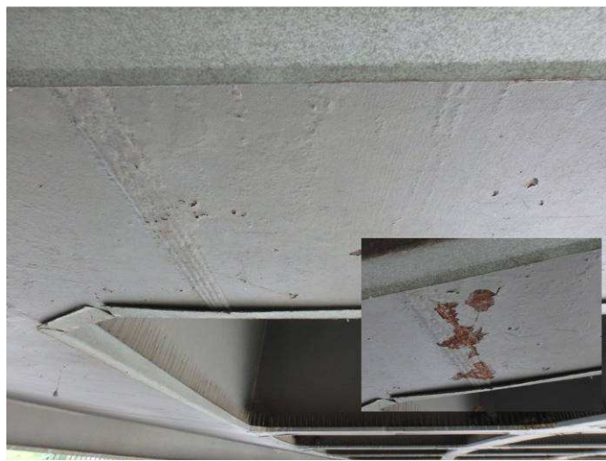
Obr. 28 – Pohled na montážní styk, podkorodování OPS
