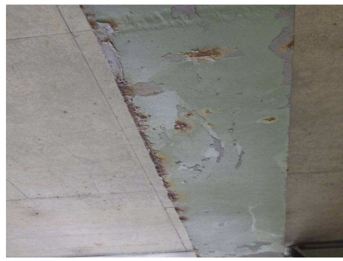
Obr. 48 – Pohled na příčník a montážní svar, odlupování vrchní vrstvy PKO, koroze na hranách, prerezávání
