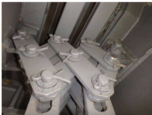
Obr. 294 – Pohled na nůžkový mechanismus vícelamelového MZ
