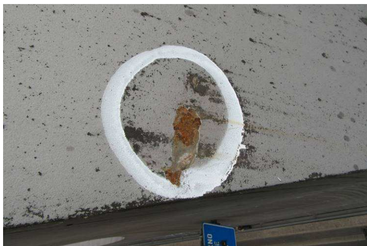
Obr. 68 - Pohled na stěnu pylonu, prorezavění, podkorodování, plošná koroze, křídování
