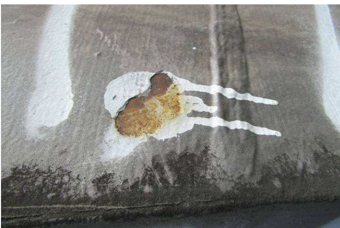
Obr. 60 – Pohled na montážní styk levého pylonu, odlupování, podkorodování, plošná koroze, křídování
