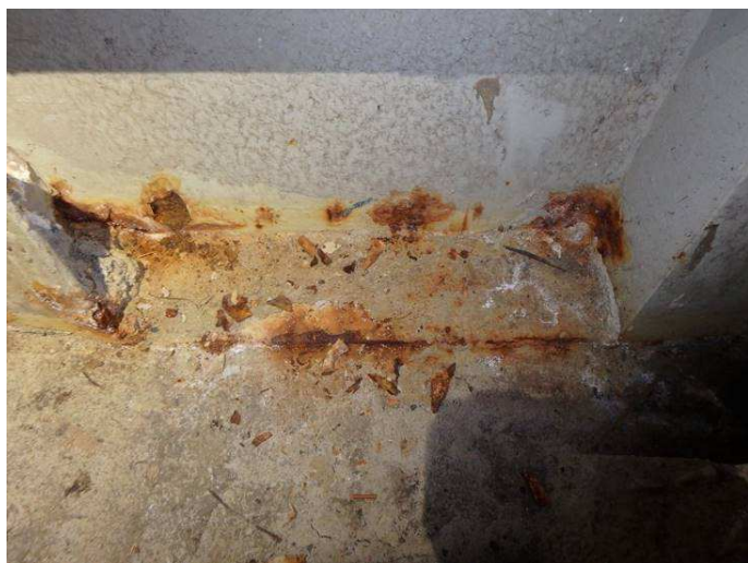
Obr. 103 - Pohled na výztuhy pylonu v patní části, prorezavění, podkorodování, odlupování, zatžené korozní produkty a nečistoty
