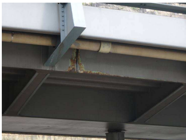
Obr. 257 – Pohled na průnik vlhkosti a vody z vozovky pravděpodobně špatně zaslepenými dočasnými odvodňovači
