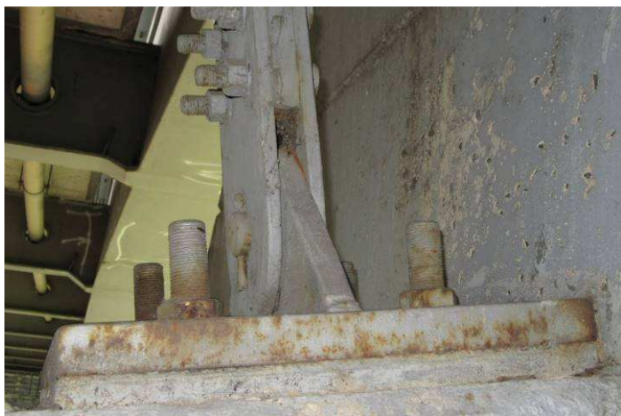
Obr. 15 – Pohled na patní desku táhla, koroze spojovacího materiálu, koroze na hranách, prorezavění Ri5, nečistoty
