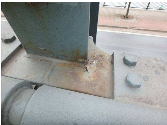
Obr. 237 – Pohled na sloupek svodidla, odlupování vrchního nátěru, prerezávání
