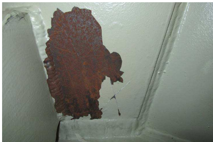
Obr. 112 – Pohled na výztuhu pylonu, plošné odlupování ONS, podkorodování, plošná koroze, nevyhovující X-řez
