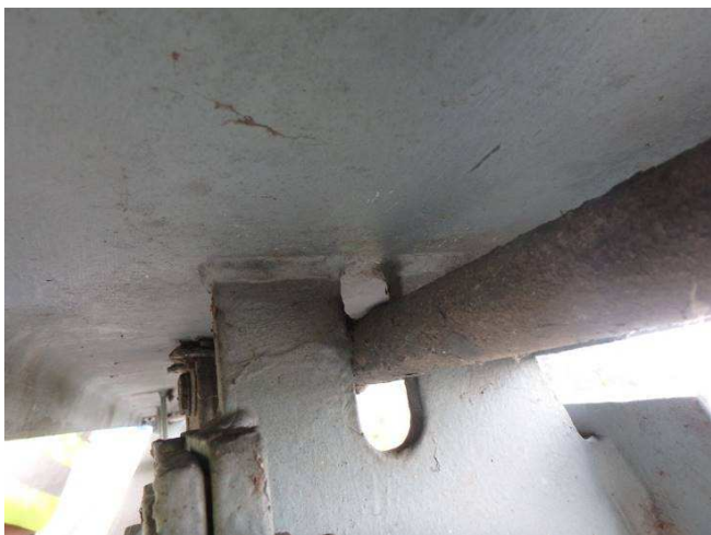
Obr. 203 – Pohled na přípoj sloupku svodidla, koroze na hranách, koroze elektro
