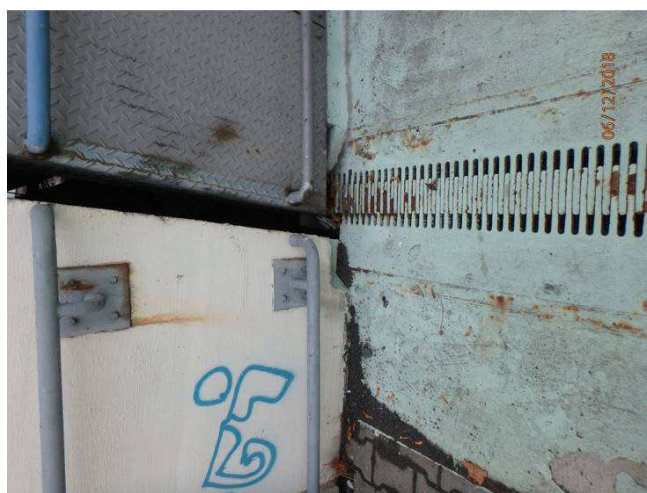
Obr. 234 – Pohled na slzičkové plechy a MZ, prerezavění
