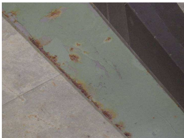
Obr. 45 – Pohled na příčník, odlupování vrchních vrstev, koroze na hranách, prerezávání Ri5
