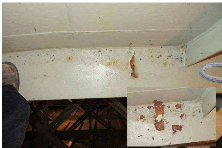
Obr. 109 – Pohled na výztuhu pylonu, odlupování, podkorodování přilehlých oblastí, plošná koroze základního materiálu
