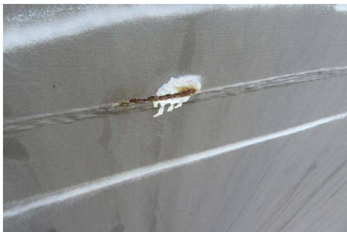
Obr. 58 – Pohled na montážní styk levého pylonu, prerezávání a podkorodování OPS, křídování
