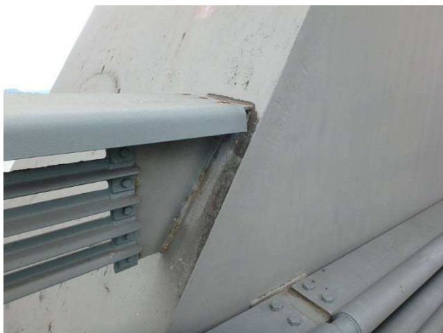
Obr. 93 – Pohled na připojení svodidla k pylonu, prorozavění, kontaminace povrchů mechy
