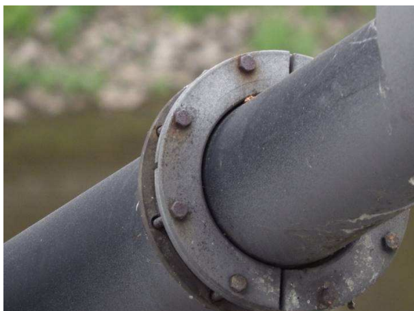
Obr. 266 - Pohled na spojku závěsu, prerezávání a koroze spojovacího materiálu
