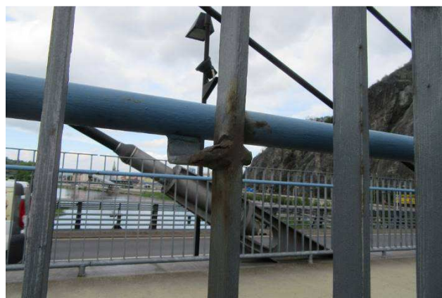
Obr. 222 – Pohled na zábradlí chodníku, prorozavění, podkorodování
