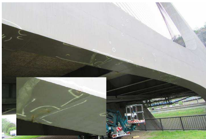
Obr. 84 – Pohled na dolní pas parapetu pylonu, prorezavění v oblasti montážních styků, odlupování vrchních vrstev
