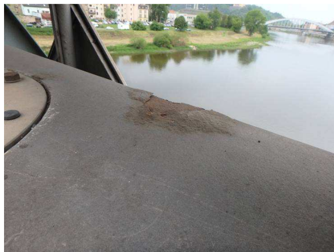
Obr. 142 – Pohled na vnější hranu římsy, prorozavění, podkorodování
