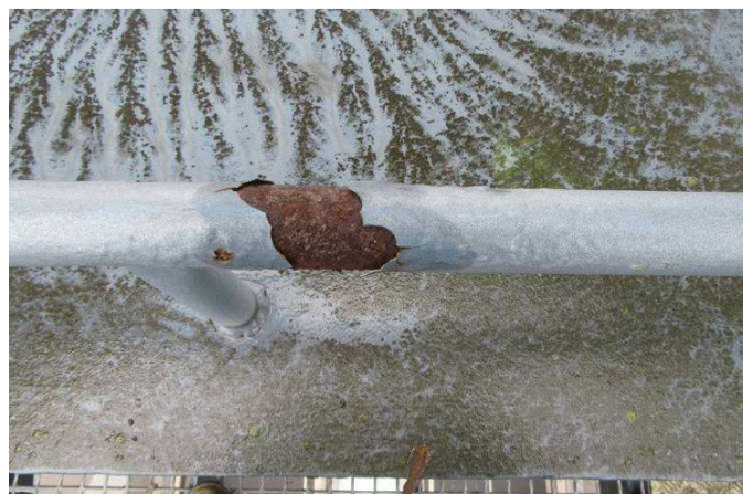
Obr. 86 – Pohled na madlo zábradlí na příčníku pylonu (křídlo), plošné odlupování od základního materiálu, podkorodování, mechy a znečištění ploch, křídování
