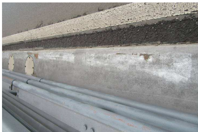
Obr. 138 - Pohled na vnější římsové obruby, prorezavění Ri5, plošná koroze, křídování a smívání vrchního nátěru
