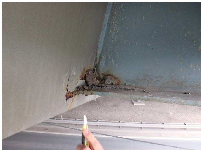
Obr. 27 - Pohled na montážní svary konzolové části ke koncovému plechu konzoly, koroze na hranách, podkorodování, plošná koroze
