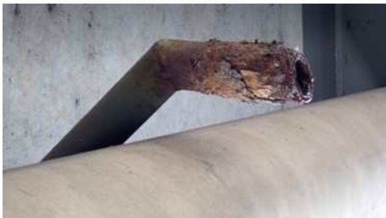
Obr. 252 – Pohled na odvodňovací trubičku, intenzivní koroze po vrstvách
