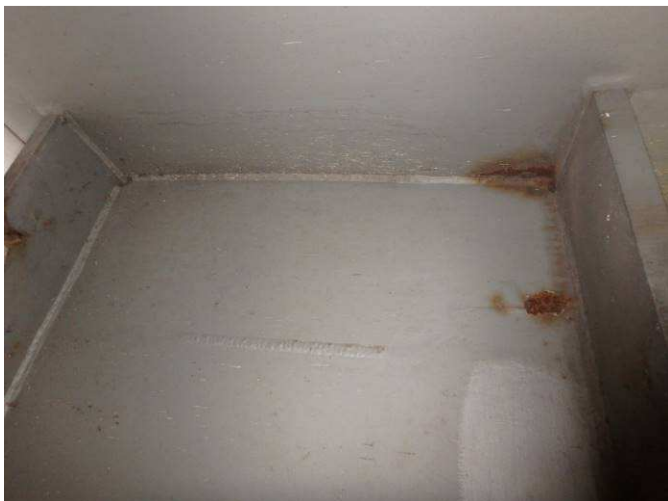
Obr. 07 – Pohled na připojení příčnicku, prorezavění Ri5, podkorodování
