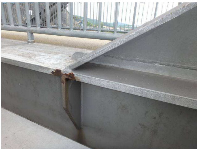
Obr. 215 – Pohled na kotevní oblast závěsu, prorezavění, podkorodování, plošná koroze
