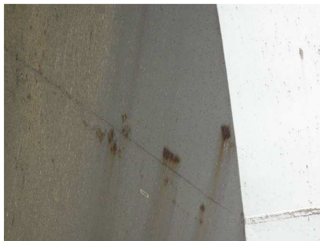
Obr. 62 – Pohled na montážní styk levého pylonu, prorozavění Ri5, podkorodování, křídování
