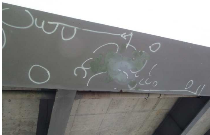
Obr. 83 – Pohled na dolní pas parapetu pylonu, prorezavění a odlupování vrchních a podkladních vrstev
