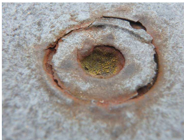
Obr. 242 – Pohled na spojovací materiál, výskyt lišejníků, podkorodování
