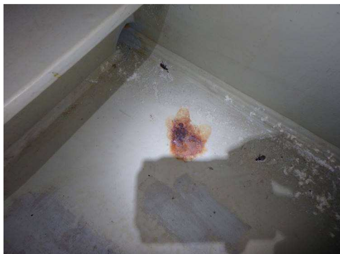
Obr. 129 – Pohled na dno koncového příčnicku, prorezavění a výskyt CHRL
