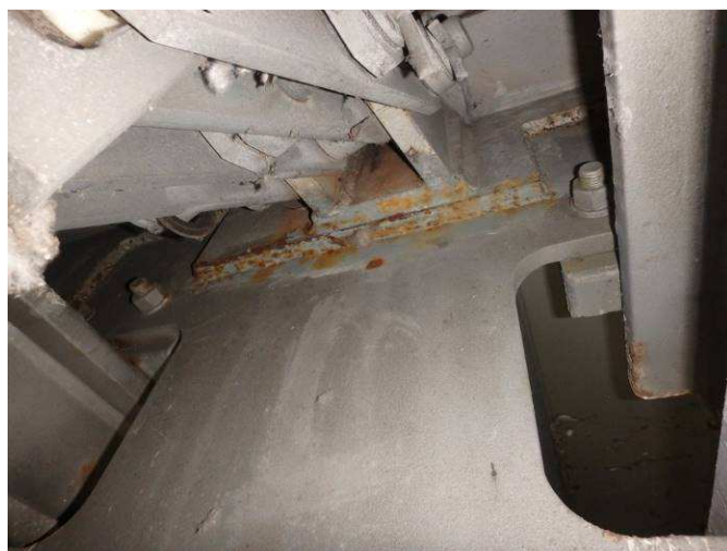
Obr. 34 – Pohled na montážní styk MZ, prorezavění Ri5, podkorodování
