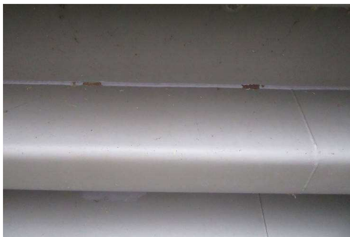
Obr. 50 – Pohled na korýtkovou výztuhu, odlupování OPS v místě svarů výztuh
