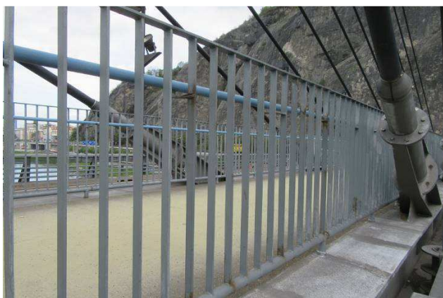
Obr. 221 – Pohled na zábradlí chodníku, prorozavění, podkorodování
