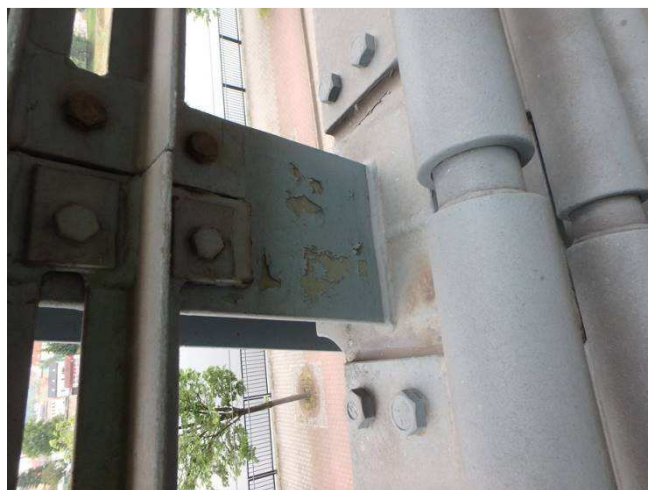
Obr. 236 – Pohled na sloupek svodidla, odlupování, prerezávání, podkorodování
