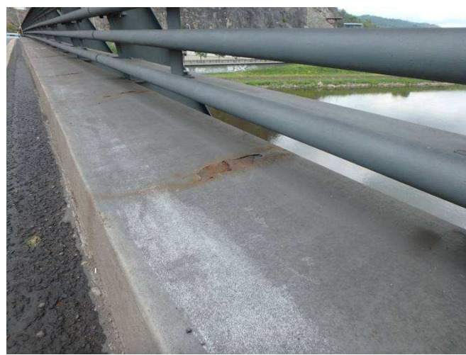
Obr. 148 - Pohled na vnější římsové obruby, prerezavění Ri5, plošná koroze, odlupování, křídování a smívání vrchního nátěru
