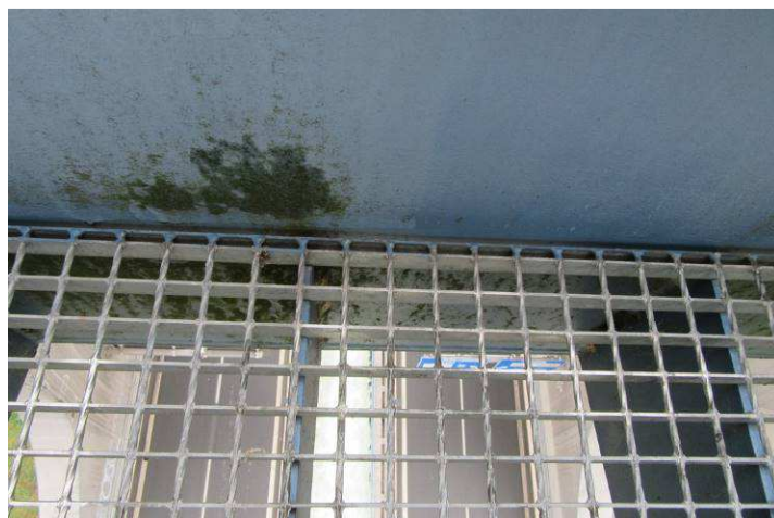
Obr. 80 – Pohled na plochu příčnicku pylonu (křídlo), výskyt mechů a lyšejníků, počínající prorezavění, křídování
