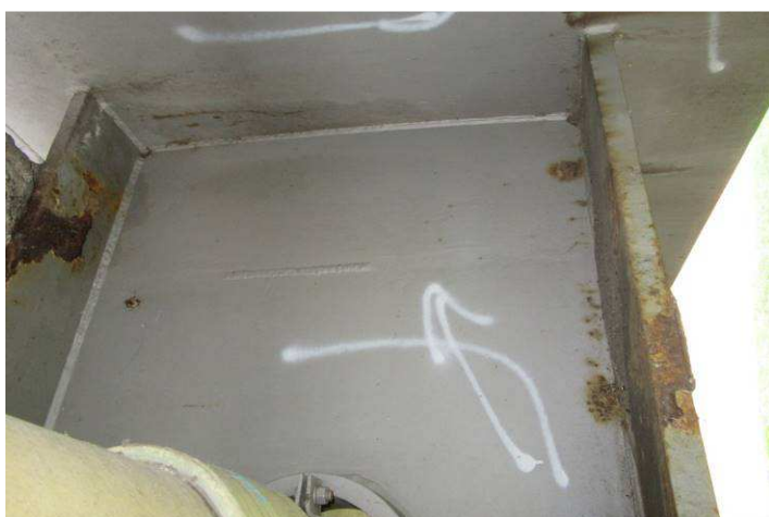
Obr. 05 – Pohled na styk příčnicku a parapetu pylonu, plošná koroze, koroze na hranách, lok. prorozavění Ri5
