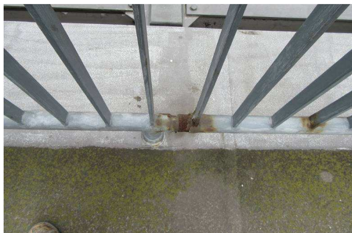
Obr. 272 – Pohled na pochozí izolaci, zanesená nečistotami, mechy a lokální porušení izolace
