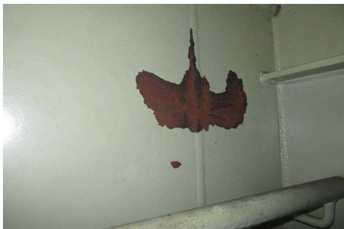
Obr. 115 - Pohled na montážní styk pylonu (parapetní část), odlupování celého souvrství ONS, podkorodování přilehlých oblastí
