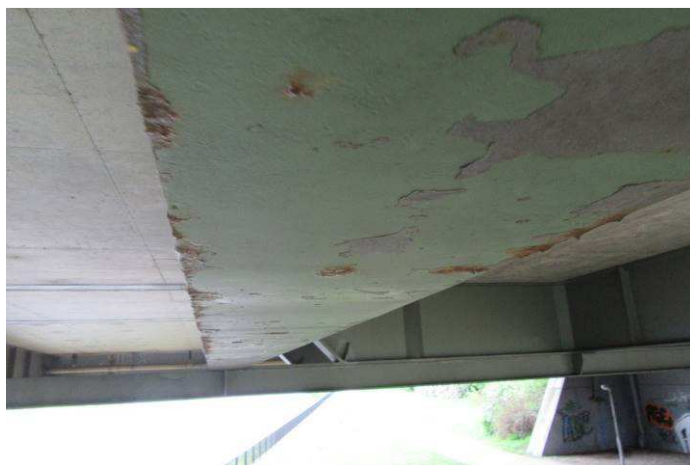
Obr. 44 – Pohled na příčník, odlupování vrchních vrstev PKO, koroze na hranách, lokální koroze v plochách
