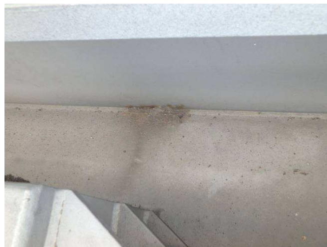
Obr. 166 - Pohled na vnitřní vodorovnou část římsy a svislou část komory, prorozavění a podkorodování
