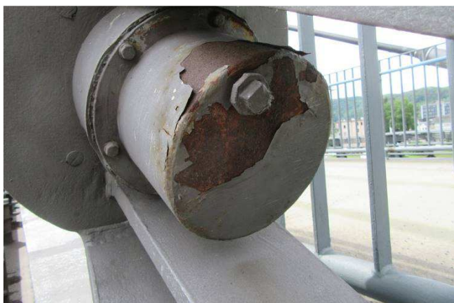
Obr. 209 – Pohled na krytku závěsu, prorazavění, podkorodování, odlupování, plošná koroze
