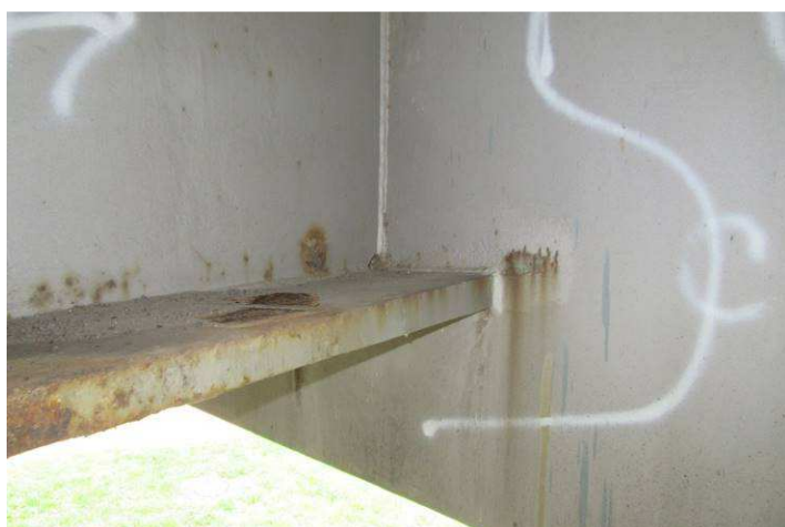
Obr. 06 – Pohled na styk příčnicku a parapetu pylonu, plošná koroze, koroze na hranách, lok. prorozavění Ri5
