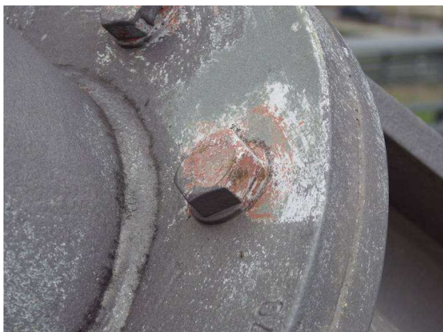
Obr. 213 – Pohled na spojovací materiál u závěsu, smívání vrchního nátěru
