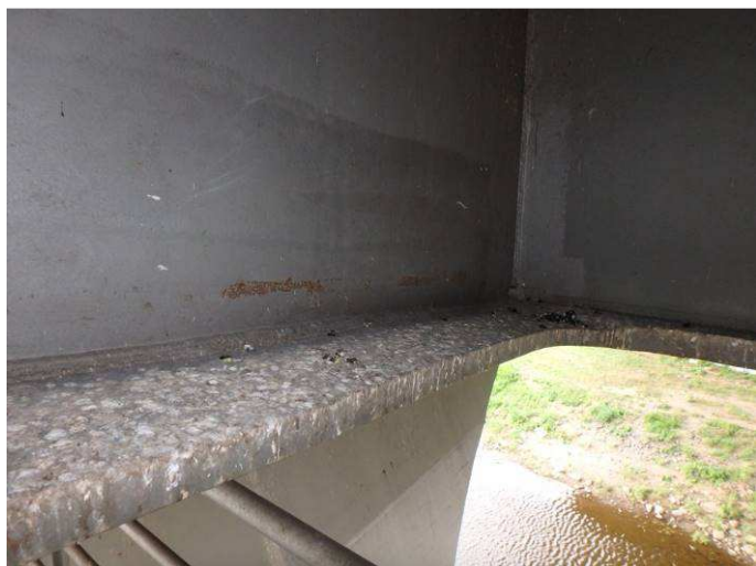
Obr. 23 – Pohled na stěnu a spodní pás, prorozavění Ri4, kontaminace ptačím trusem
