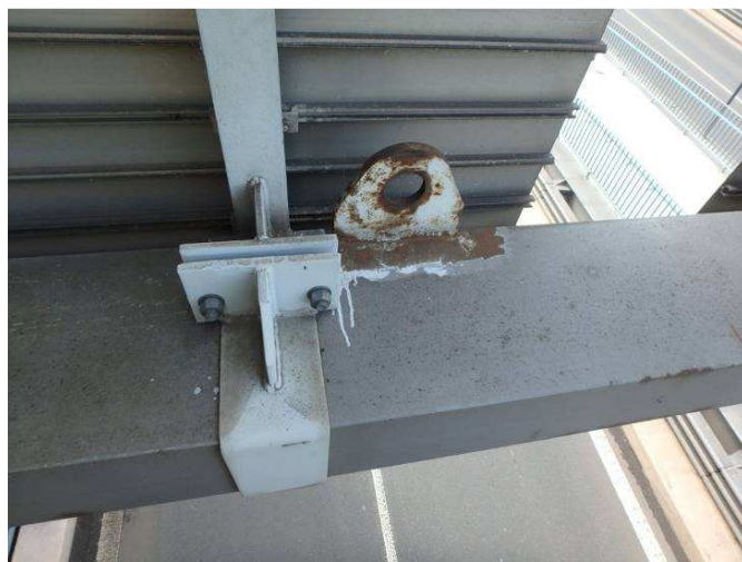
Obr. 282 - Pohled na portál DZ, plošná koroze v místě montážních ok
