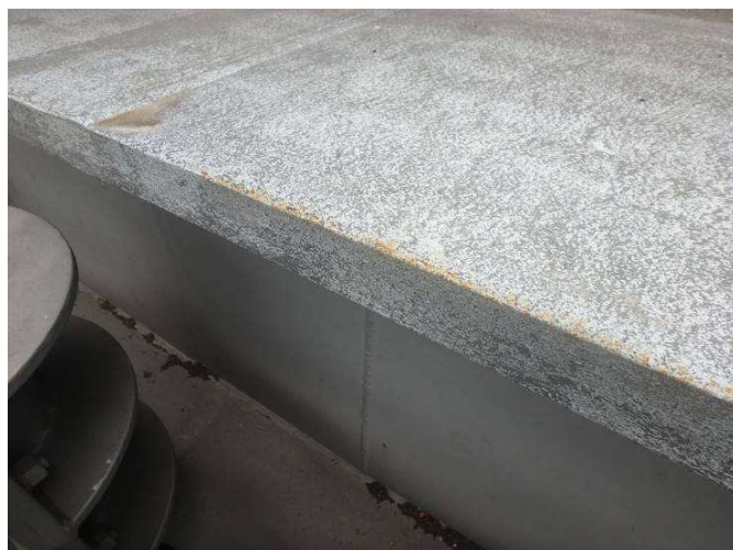
Obr. 170 - Pohled na horní pas komory, prerezavění na hranách, smívání vrchního nátěru
