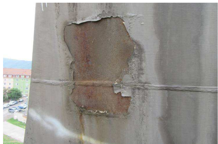
Obr. 53 – Pohled na montážní styk na pravém pylonu, proražavění, podkorodování, odlupování, plošná koroze, křídovávání
