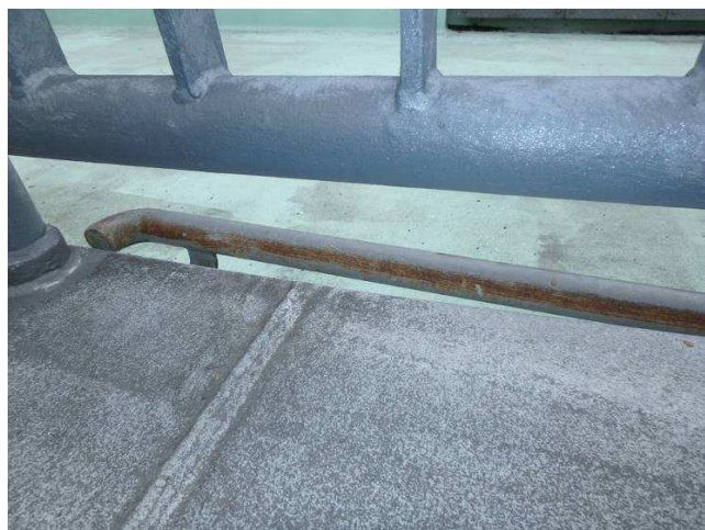
Obr. 224 – Pohled na vodící prvky zábradlí, prorezavění, smívání vrchního nátěru, křídování
