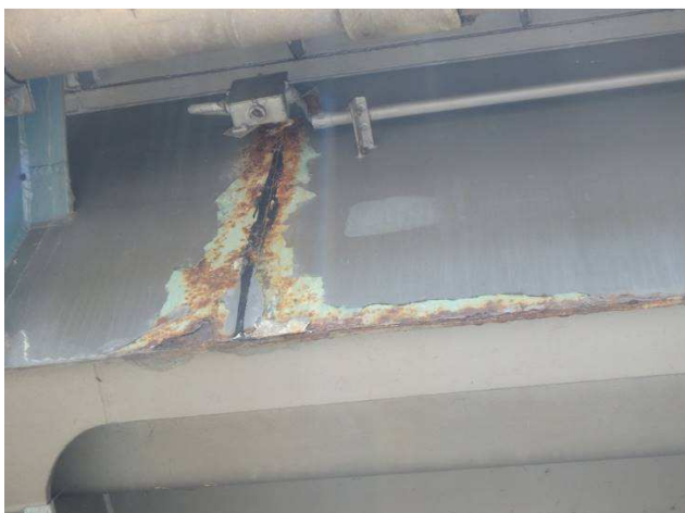
Obr. 259 - Pohled na průnik vlhkosti a vody z vozovky pravděpodobně špatně zaslepenými dočasnými odvodňovači, kombinace s průchodem elektrochráničky
