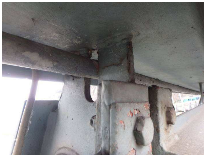
Obr. 190 – Pohled na madlo a sloupek svodidla, koroze na hranách, odlupování, prorezávání
