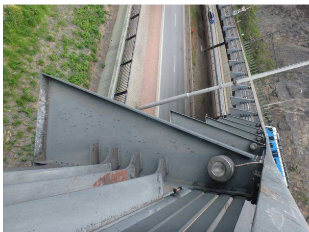
Obr. 243 – Pohled na sloupek svodidla, kontaminace spodního pasu ptačím trusem, prorozavění, podkorodování
