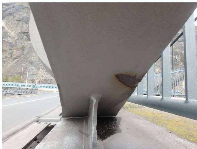
Obr. 216 – Pohled na kotevní oblast závěsu, podkorodování, plošná koroze, usazování nečistot
