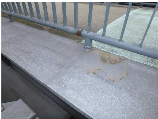
Obr. 169 - Pohled na horní pas komory, prerezavění Ri3 až Ri5, smívání vrchního nátěru
