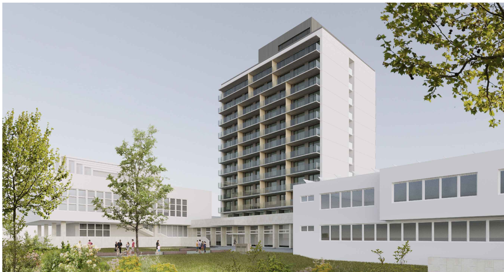
pohled od jihu
