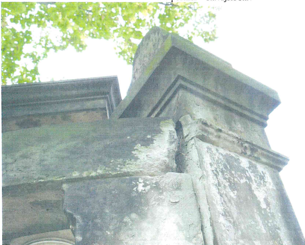
Ústí nad Labem, Střekov, hřbitov, hrobka rodiny Alexandra Edlera von Wölfel, detail krust, biokoroze a koroze kamene portiku – stávající stav
