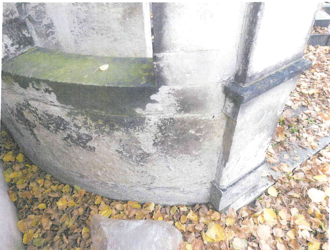
Ústí nad Labem, Střekov, hřbitov, hrobka rodiny Alexandra Edlera von Wölfel, detail krust, biokoroze a koroze kamene portiku – stávající stav
