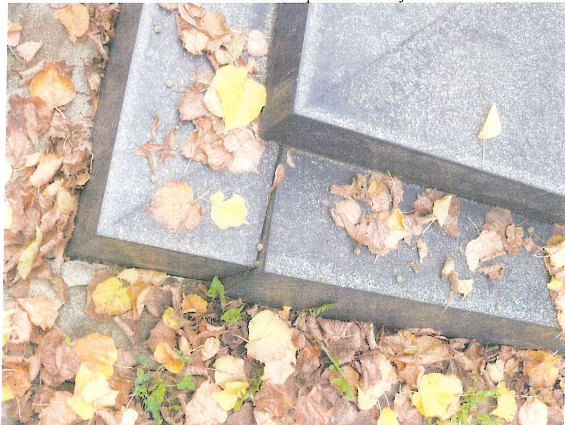
Ústí nad Labem, Střekov, hřbitov, hrobka rodiny Alexandra Edlera von Wölfel, detail rozvolnění skladby obruby hrobového místa – stávající stav
