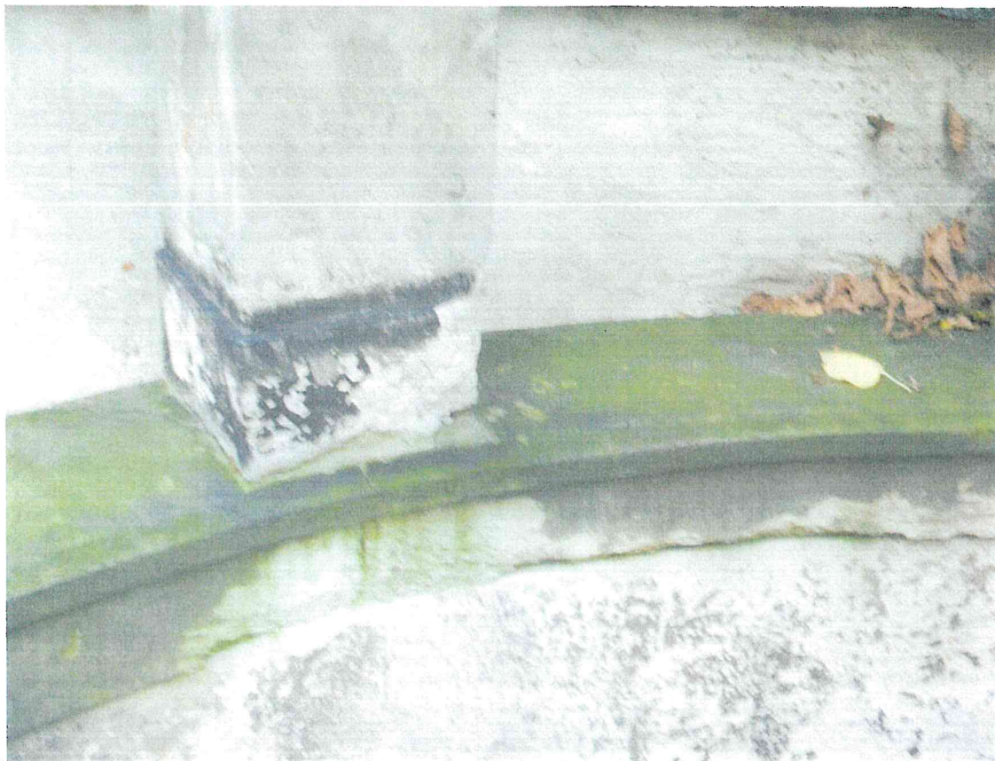
Ústí nad Labem, Střekov, hřbitov, hrobka rodiny Alexandra Edlera von Wölfel, detail krust, biokoroze a koroze kamene portiku – stávající stav
