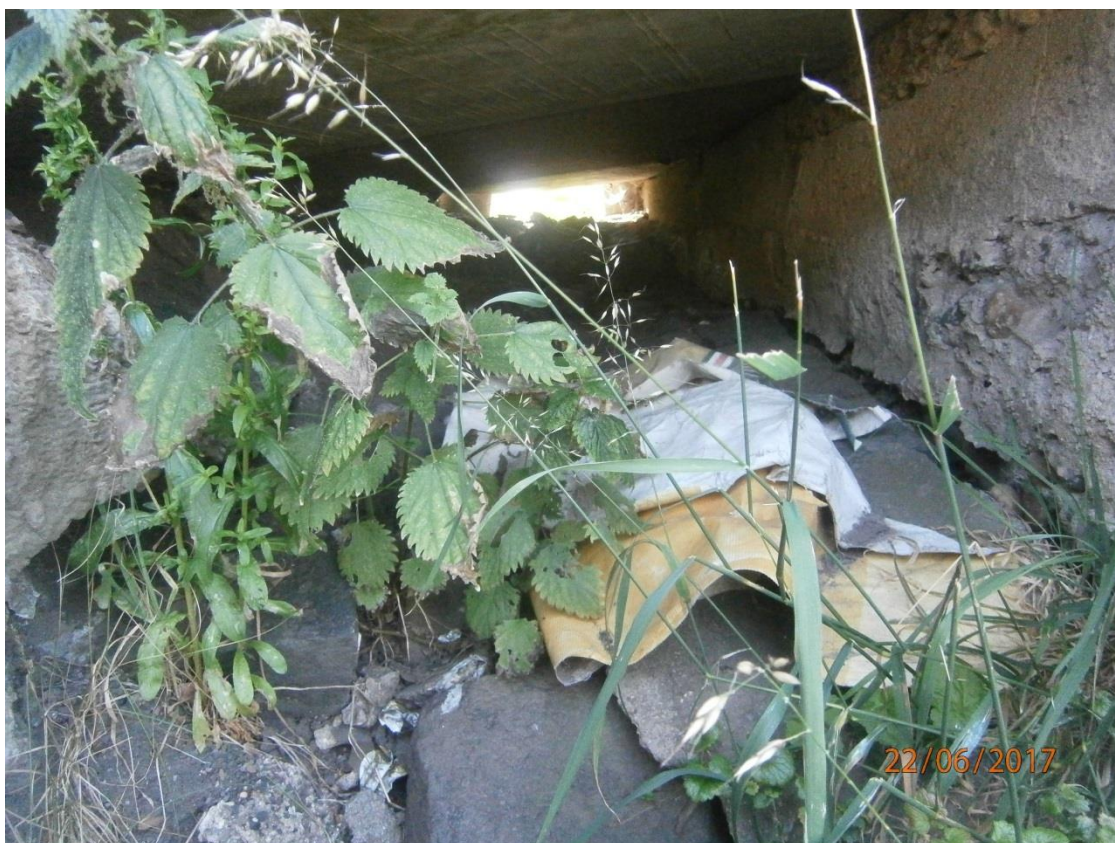
Fotografie č.9 Prostor pod vjezdem do garáže
