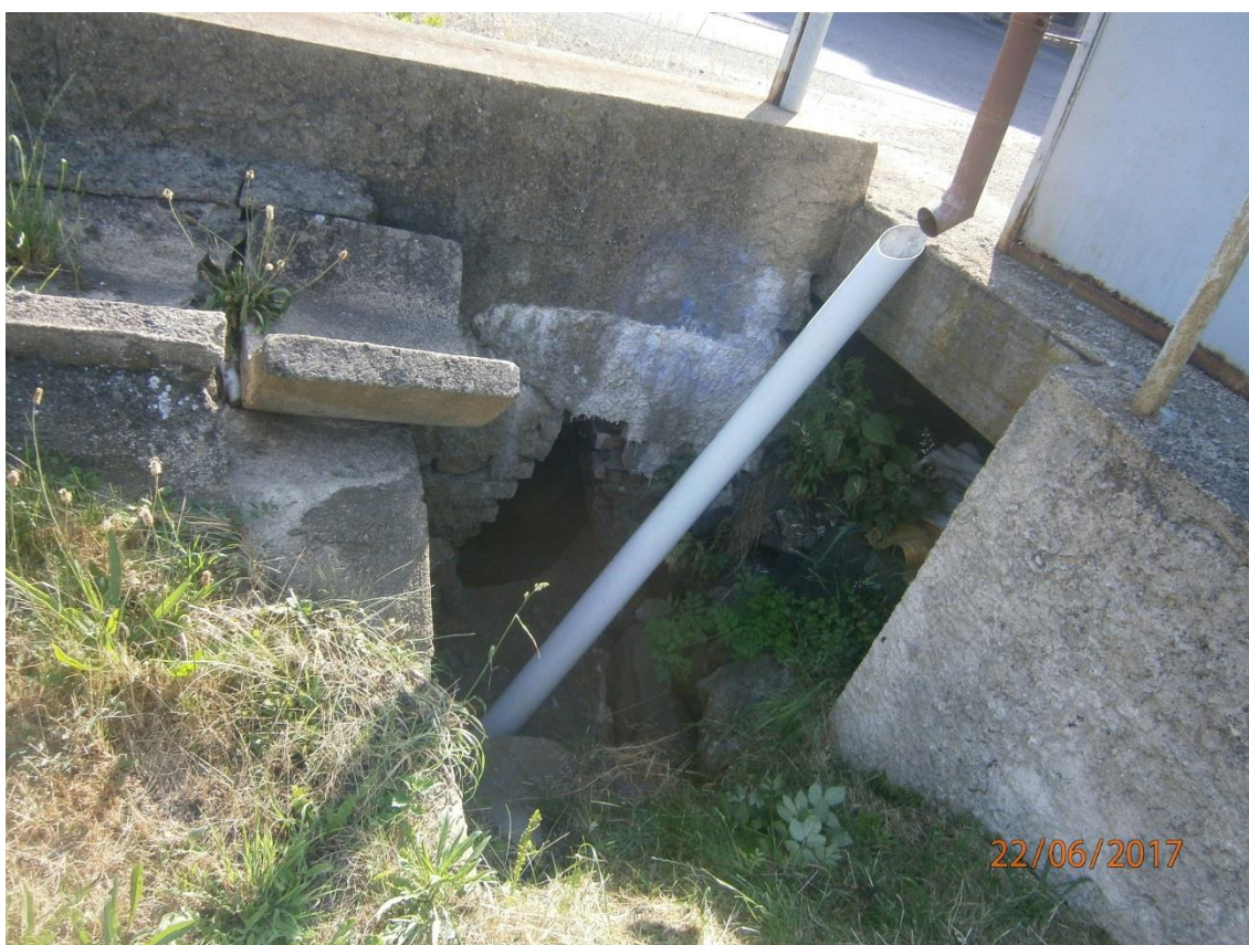
Fotografie č.8 Pohled na žlab, svod z garáže, propustek a stávající odtok dešťové vody
