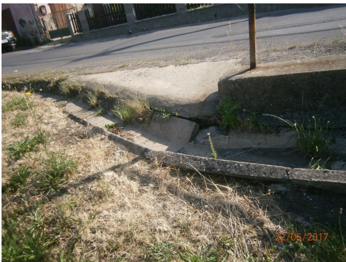
Fotografie č.6 Žlab podél pravé strany komunikace
