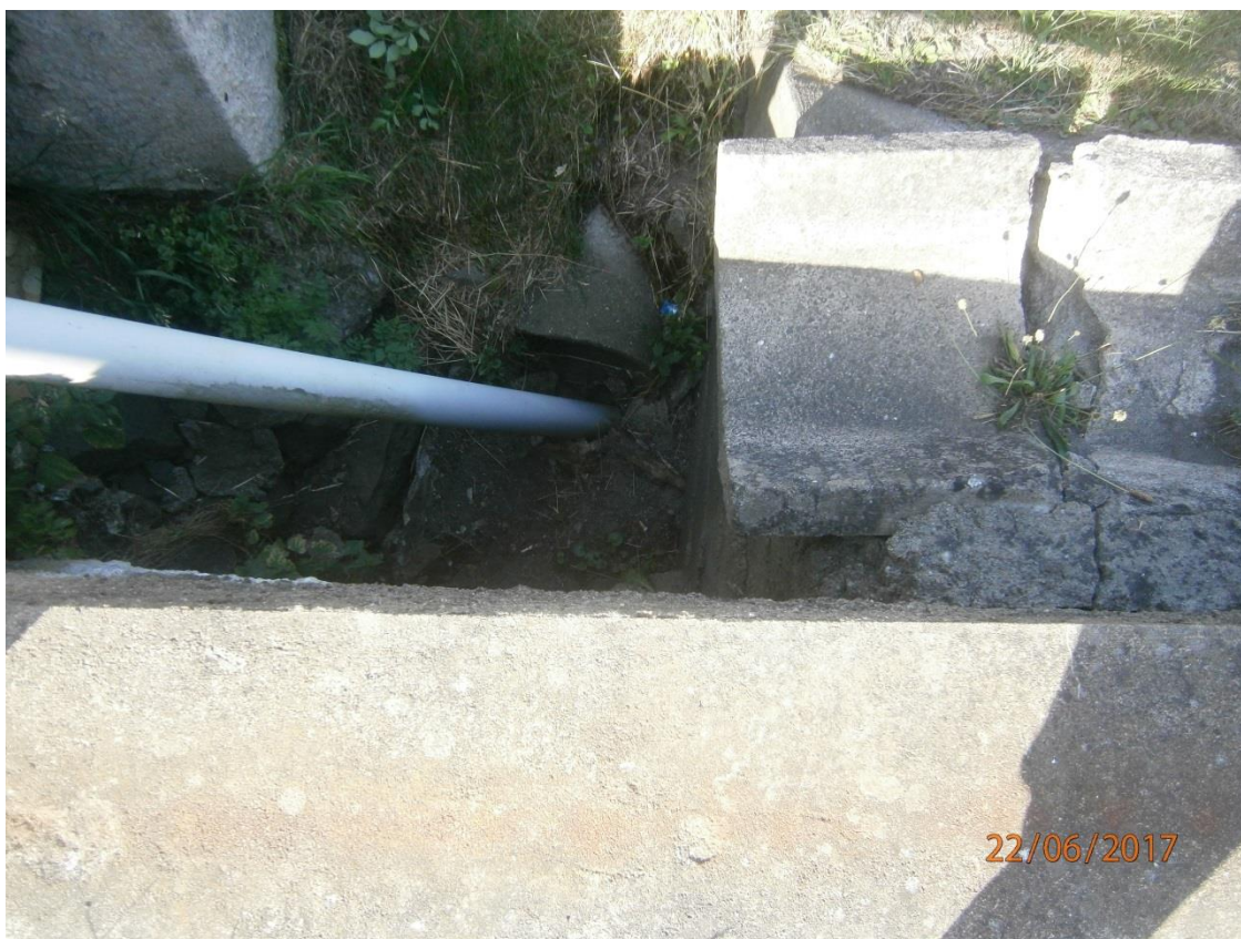
Fotografie č.5 Pohled ze shora na odtok dešťové vody – detail
