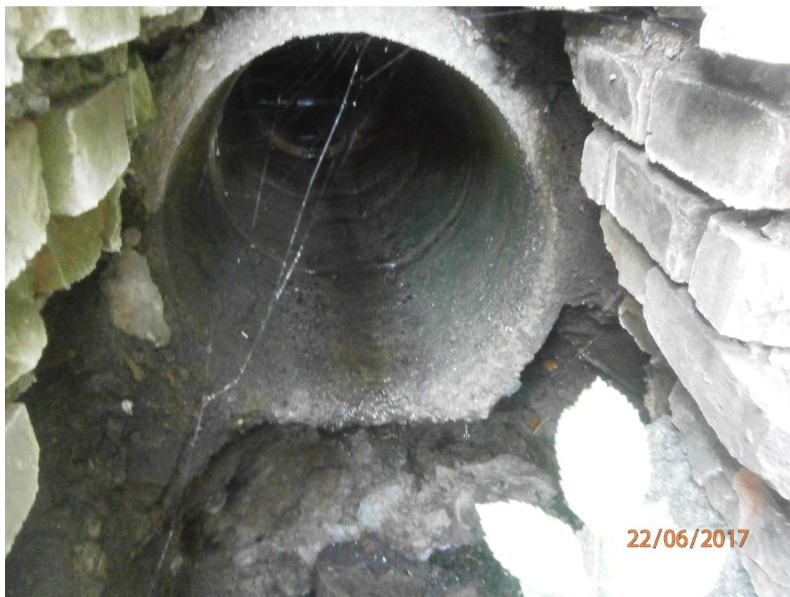
Fotografie č.11 Detail propustku
