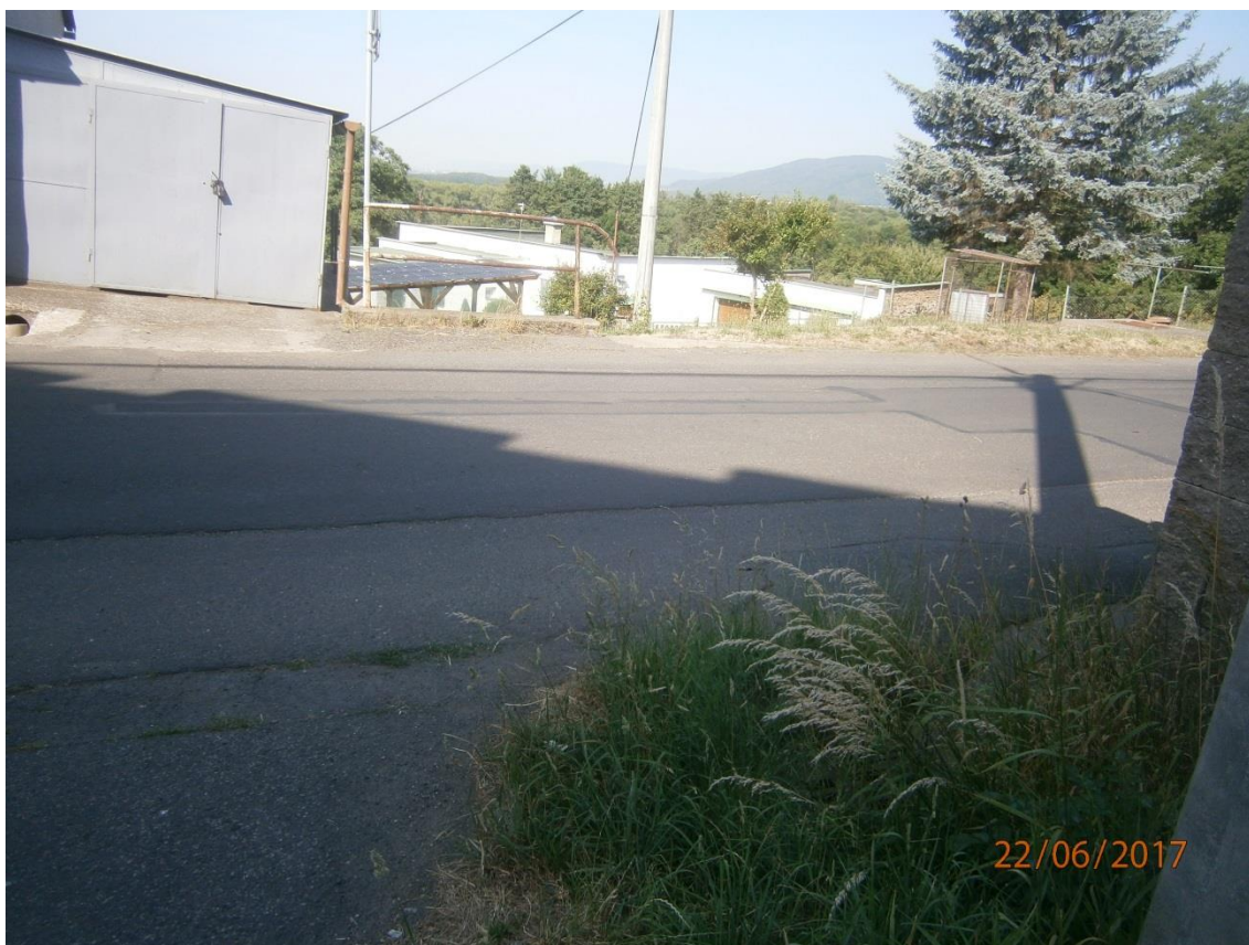
Fotografie č.3 Celkový pohled na komunikaci
