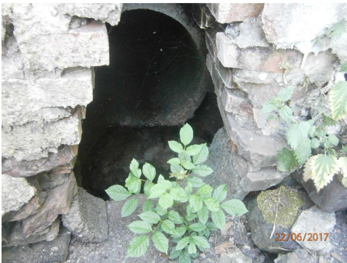
Fotografie č.10 Propustek pod komunikací
