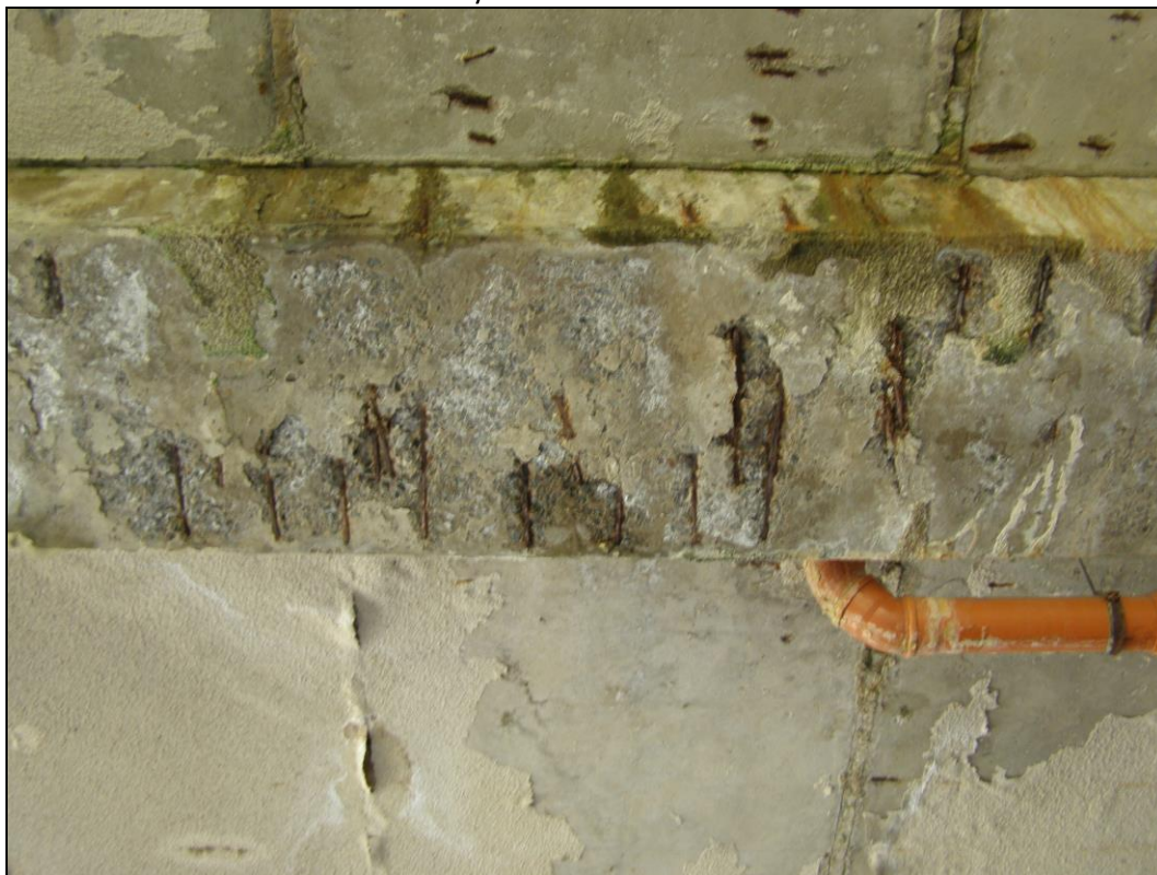
Foto 12: Obnažená a zkorodovaná výztuž ŽB konstrukcí
