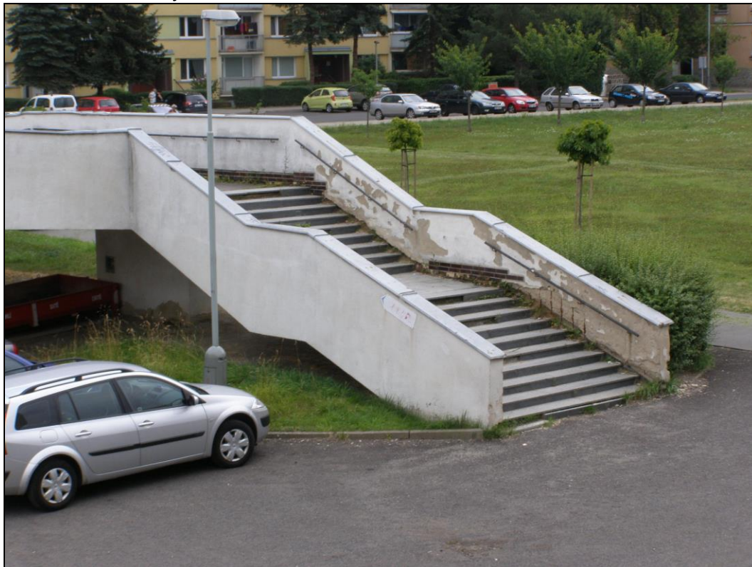
Foto 04: Poškozené jižní schodiště a atika
