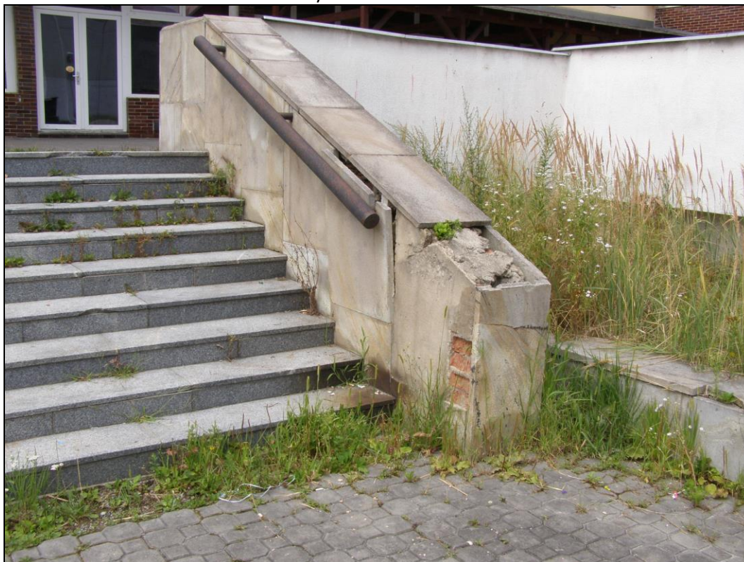
Foto 10: Poškozená atika u bočního vyrovnávacího schodiště
