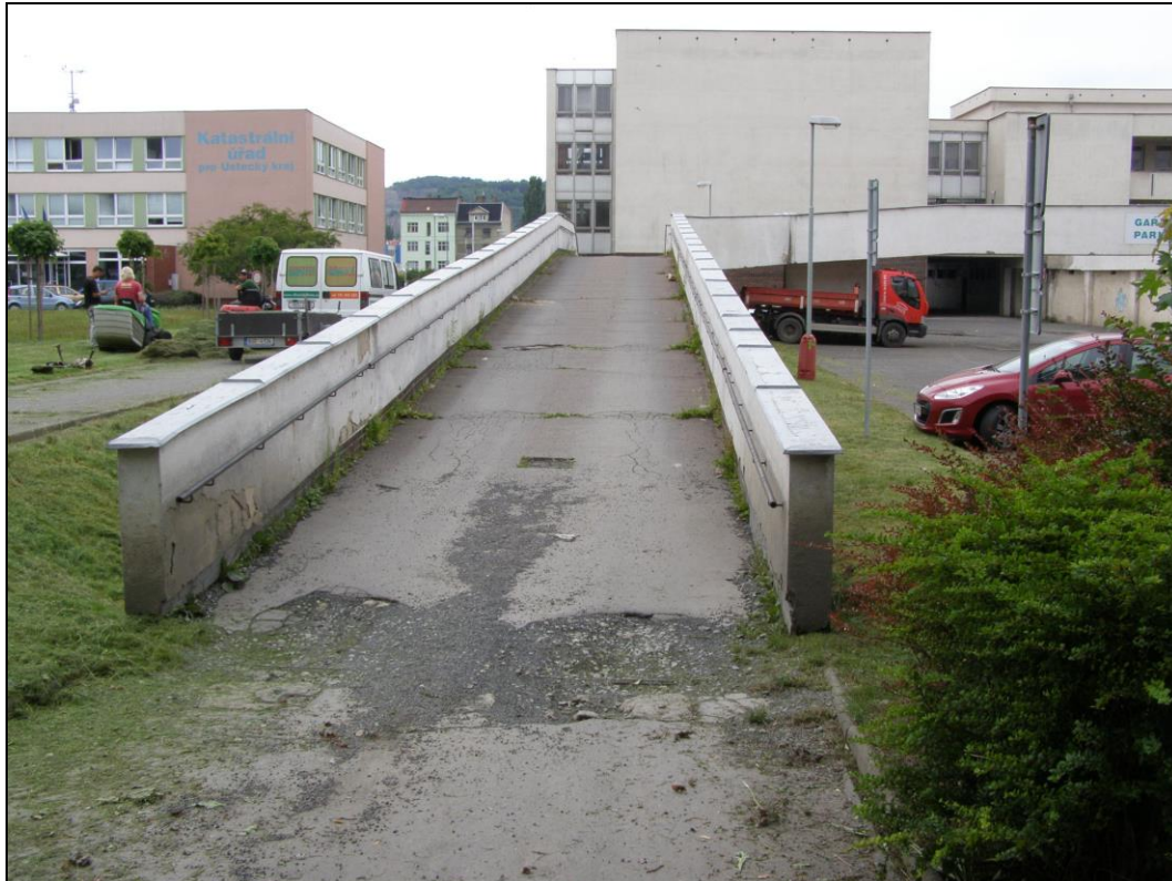
Foto 05: Poškozený povrch nájezdové jižní rampy
