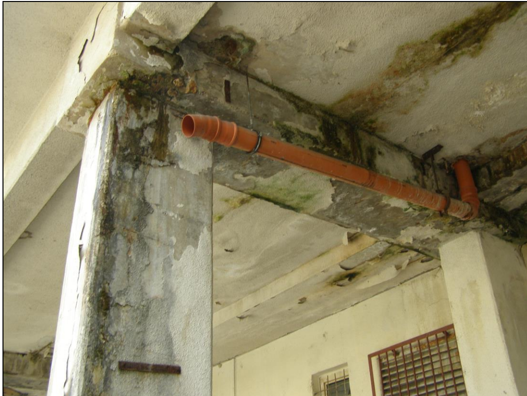
Foto 11: Stropy, průvlaky a sloupky dolního nádvoří poškozené vlhkostí
