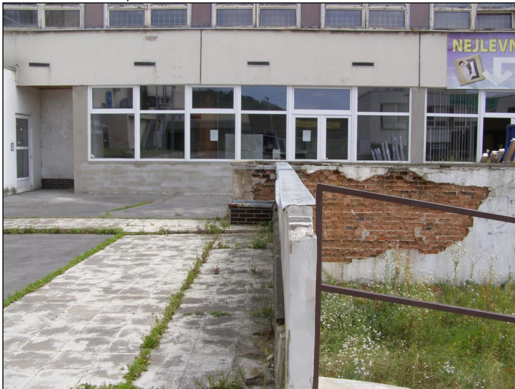
Foto 09: Poškozená vyzděná atika
