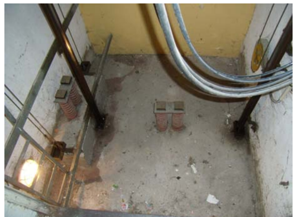
Spodní část výtahové šachty – prohlubeň
