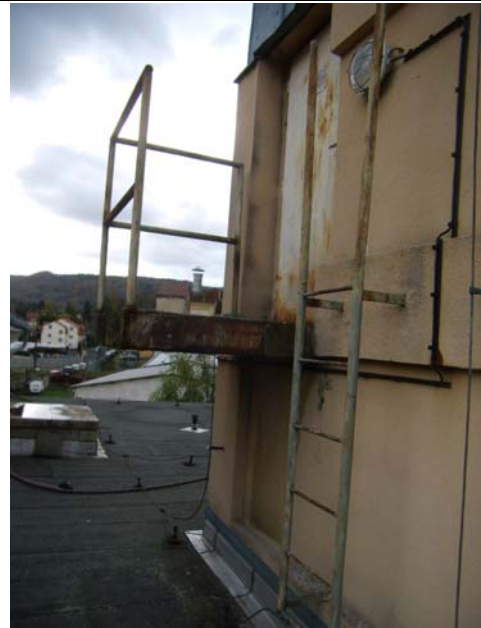
vlastní vstup do strojovny
