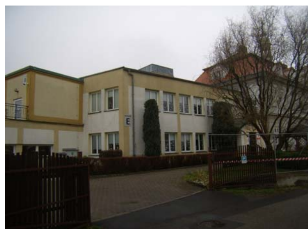
nebo transportovat díly jeřábem ze dvora na střechu
