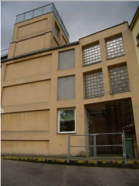
Pohled na šachtu ze dvora
